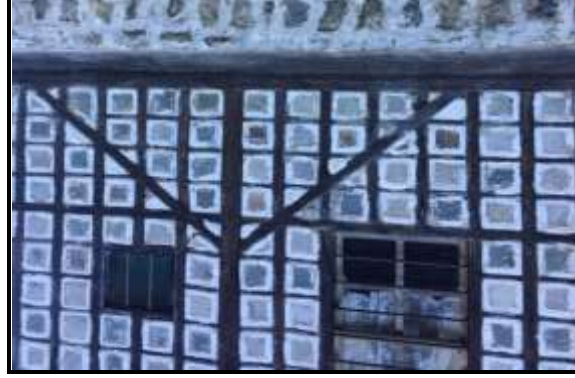
Şekil 32. Oktay Konağı taşıyıcı dikmeler
