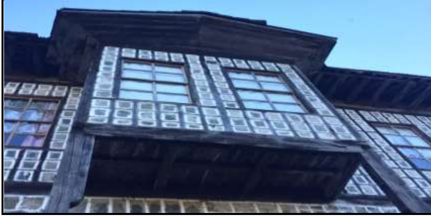
Şekil 30. Oktay Konağı kuzey cephesi
