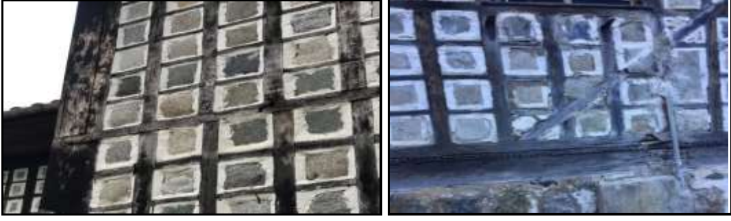
Şekil 36. Dış hava koşullarında göz dolma ve kiriş
