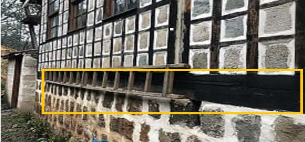
Şekil 61. Uzunhasanoğlu Konağı taban kirişi
