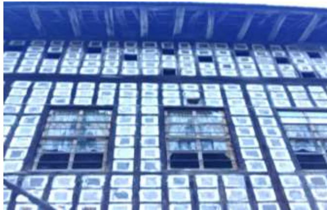
Şekil 70. Göz dolma sistem ile doğal havalandırma
