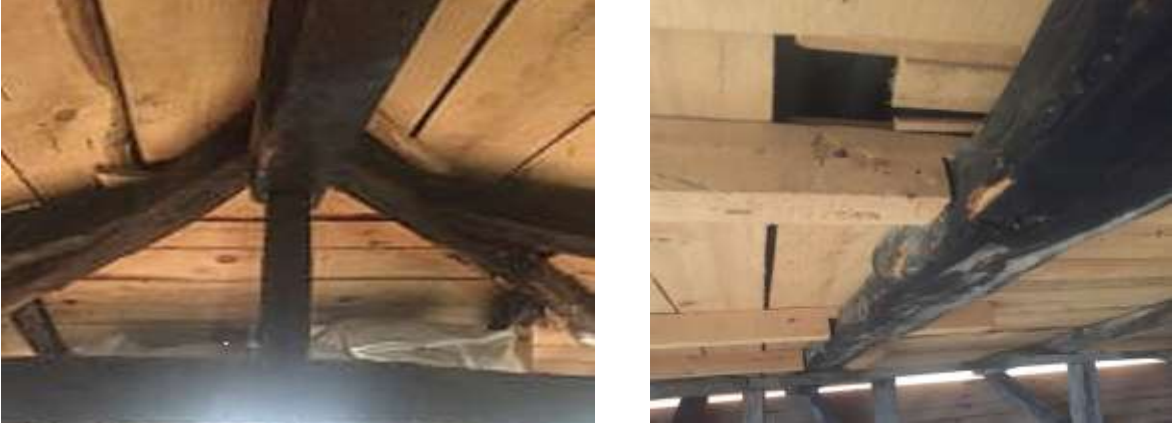
Şekil 67. Uzunhasanoğlu Konağı çatı sisteminde ana omuzu oluşturan mahya kirişi ve onunla eğimli olarak birleştirilen makas kirişleri ve havalandırma penceresi.
