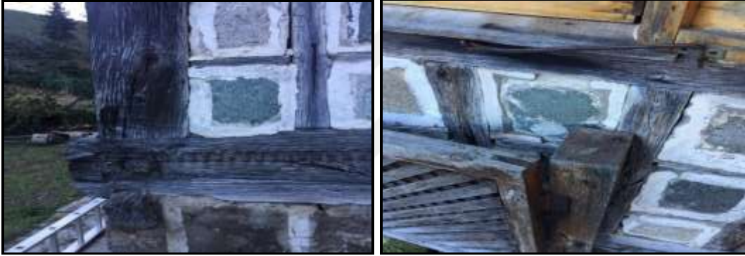
Şekil 37. Oktay Konağı kurtağzı birleştirme ve dış ortam bozulması
