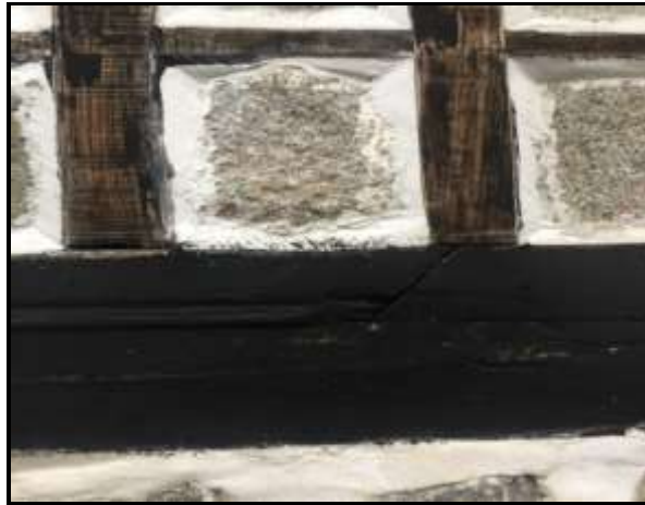
Şekil 33. Taban kirişinde birleştirme
