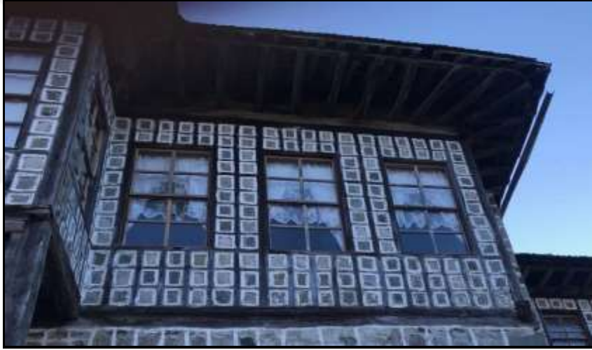
Şekil 35. Oktay konağı saçak ve kirişlerde bozulmalar
