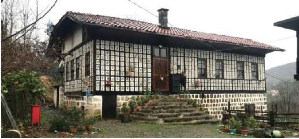
Şekil 60. Uzunhasanoğlu Konağı kuzey cephe görünüşü
