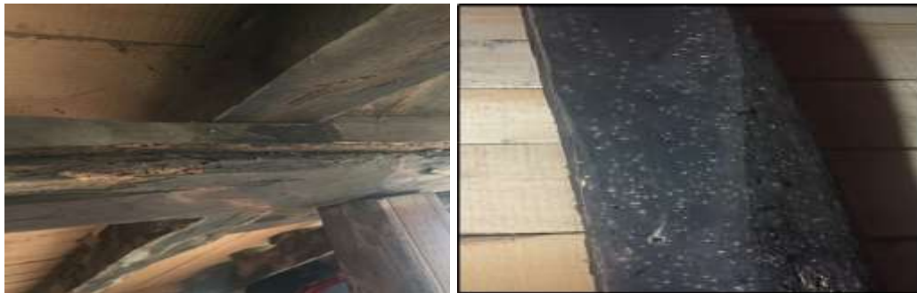
Şekil 39. Böcek Tahribatı ve çatıda böcek uçma delikleri
