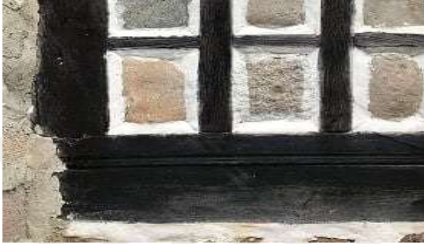
Şekil 64. Göz dolma tekniğinin yakın plan görüntüsü.
