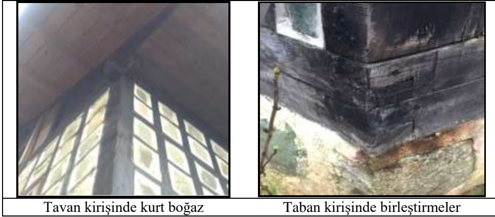
Şekil 31. Tavan ve taban kirişinde birleştirmeler
