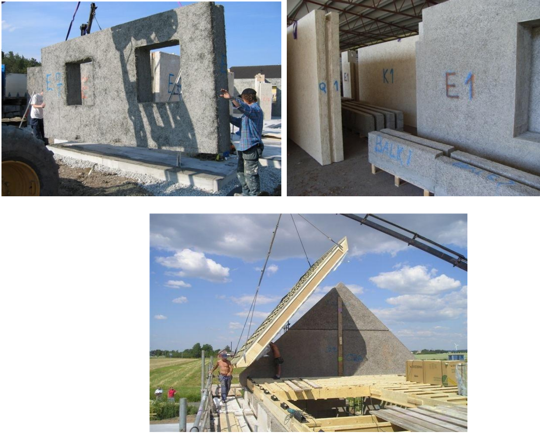
Şekil 7. Büyük OYÇ duvar panelleri ve uygulanması (Rückert, 2008).
