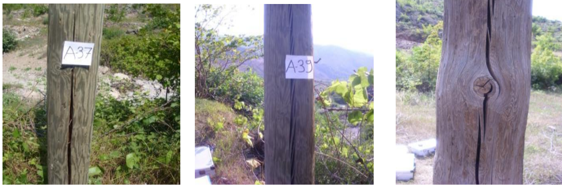
Şekil 45. Artvin-Ardanuç yöresindeki tel direklerinde tespit edilen çatlak ve yarıklar
