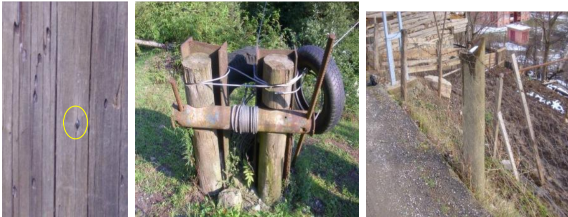
Şekil 47. Artvin-Merkez, Borçka ve Ardanuç yöresindeki tel direklerinde tespit edilen insanların neden olduğu kusurlar (saçma sıkılmış bir tel direği ve kişisel amaçlar için kullanılan tel direkleri)
