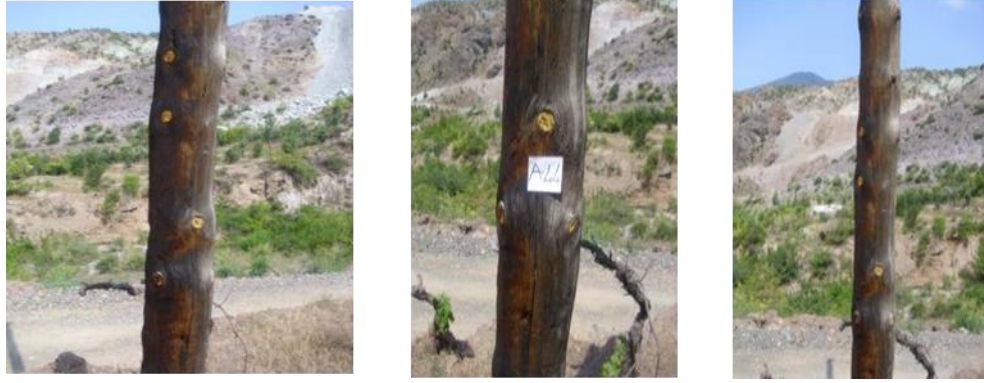
Şekil 44. Yakılan ateş sonucu tel direklerinin toprak zonunda ve daha üst kısımlarında meydana gelen yanmalar
