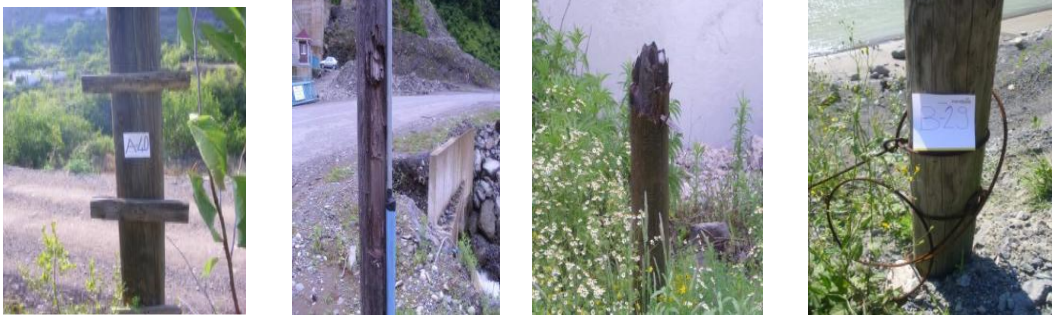
Şekil 46. Artvin-Borçka ve Ardanuç yöresindeki tel direklerinde tespit edilen insanların neden olduğu kusurlar
