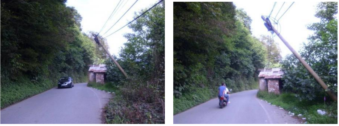
Şekil 8. Düzenli bakımı yapılmamış bir tel direğinin insanların güvenliğini tehdit etmesi (Arhavi Ortacalar mahallesi)
