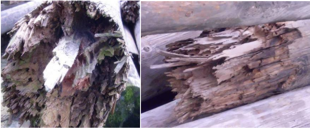
Şekil 43. Trabzon Arsin deposunda atıl haldeki tel direklerinde görülen böcek hasarları
