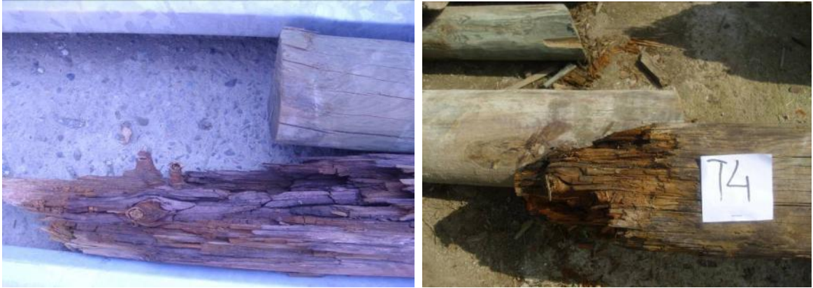
Şekil 36. Artvin ÇEDAŞ ve Trabzon TEDAŞ Arsin Deposunda atıl halde bulunan CCA ile emprenyeli sarıçam tel direklerinin toprak zonunda tespit edilen esmer çürüklükler
