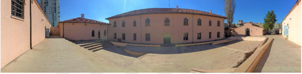
Şekil 21. Restorasyondan sonra müzenin dış duvar yüzeyleri ve zemin uygulamaları (Öztürk A. Arşivi, 2018)
