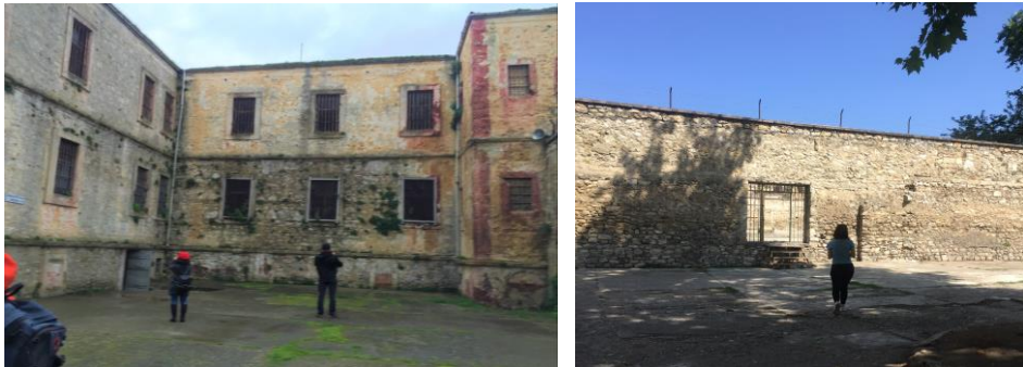
Şekil 28. Avludan görünüm, avlu duvarları ve jiletli teller (Öztürk A. Arşivi, 2018)
