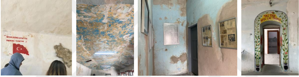
Şekil 65. Tavanlardaki ve duvarlardaki boyaların katmanlaşması (Öztürk A. Arşivi, 2018)
