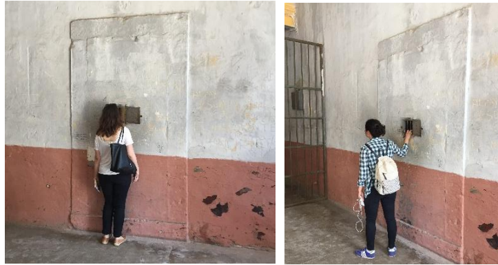
Şekil 61. Betonla sıvanmış kapı (Öztürk A. Arşivi, 2018)
