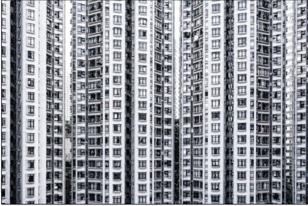
Şekil 1.13. Hong Kong yüksek katlı ve yüksek yoğunluklu apartmanlar, Fotoğrafi çeken Ernest Yuen (Dewolf, 2016)
