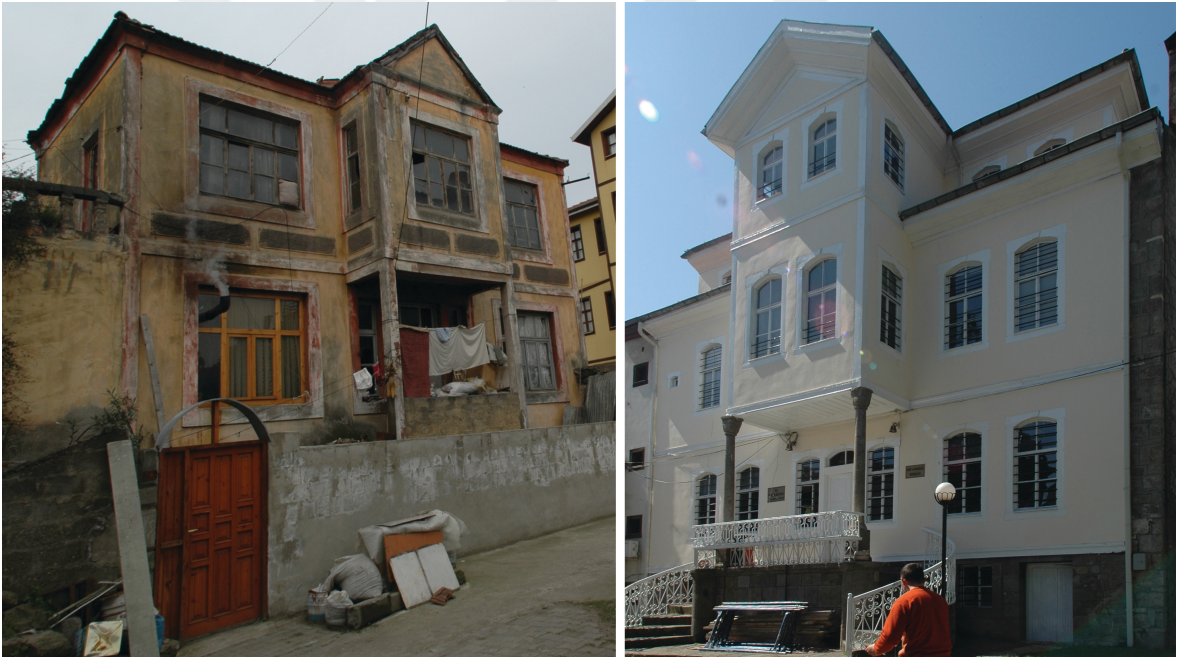
Şekil 2.14. Geleneksel konut cephesi örnekleri. 110 ada 23 parseldeki ve 110 ada 41 parseldeki binalar. Kaynak: Trabzon Büyükşehir Belediyesi
