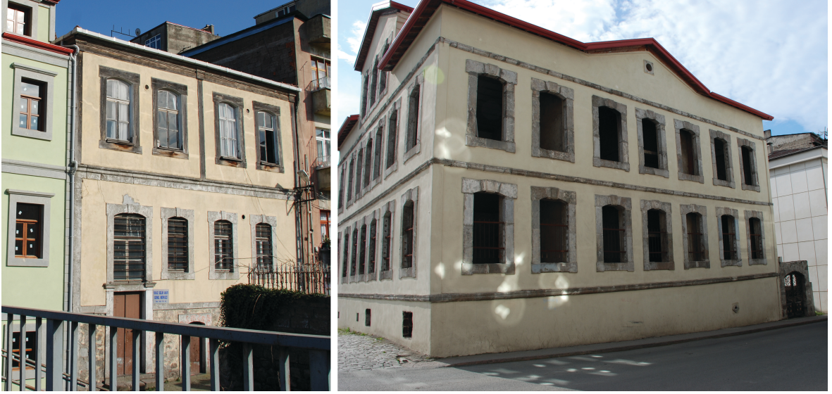
Şekil 2.15. Geleneksel konut cephesi örnekleri. 128 ada 7 parseldeki ve 129 ada 26 parseldeki binalar. Kaynak: Trabzon Büyükşehir Belediyesi
