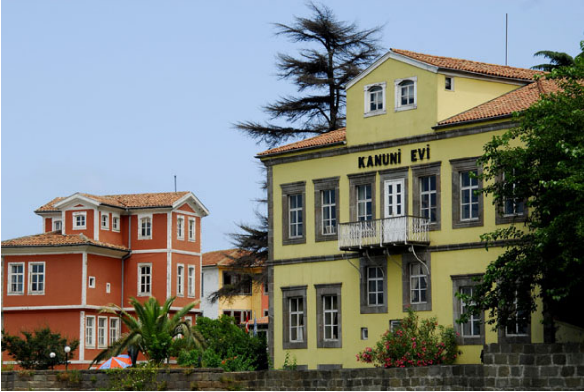
Şekil 3.7. 110 ada 131 parseldeki (solda) yapıdaki kapalı çıkma ve 110 ada 39 parseldeki (sağda) yapıdaki arka cephesinde bulunan açık çıkma
