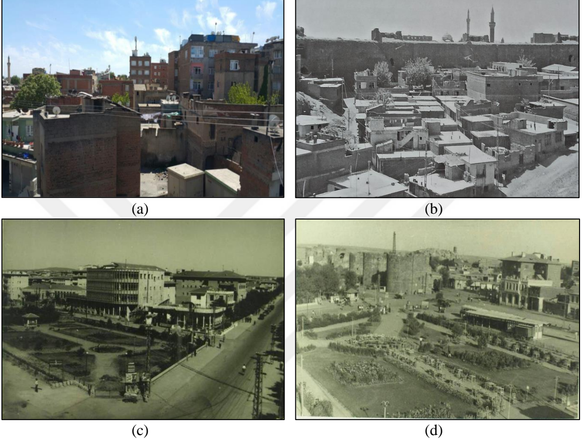
Şekil 12. Suriçi ve Sur dışı yerleşim alanından görünüm
