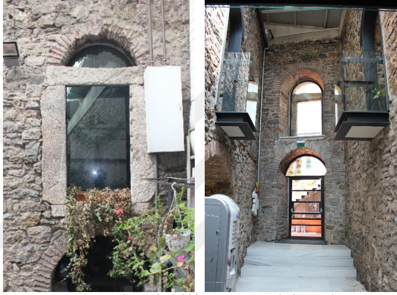
Arka cephedeki kapı ve pencerelerin genel görünümü
