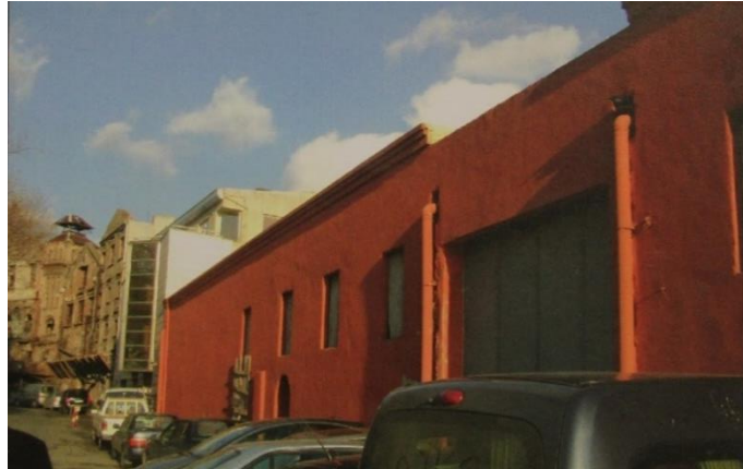
Şekil 8. 2009 yılındaki restorasyondan önce yapının ön cephesi (İstanbul II Numaralı Kültür Varlıklarını Koruma Bölge Kurulu Müdürlüğü arşiv dosyasında 386 numara ve 05.02.2008 tarihli rölöve raporu eki)
