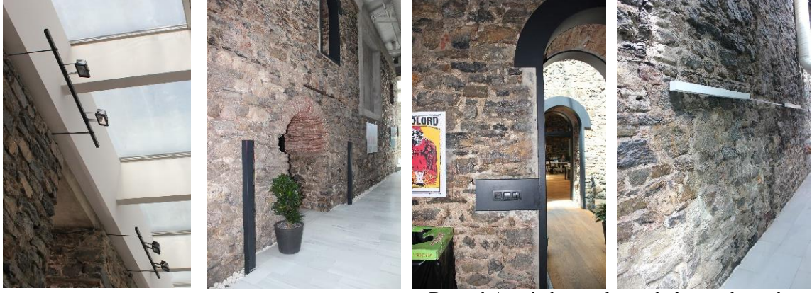
Duvarda/zeminde yer alan aydınlatma elemanları
