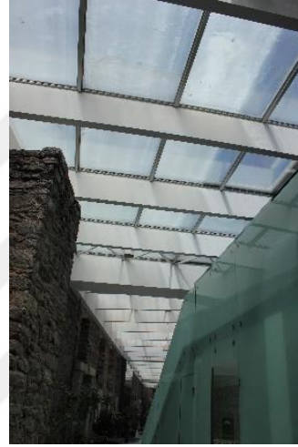
Giriş holünde çelik çatı
