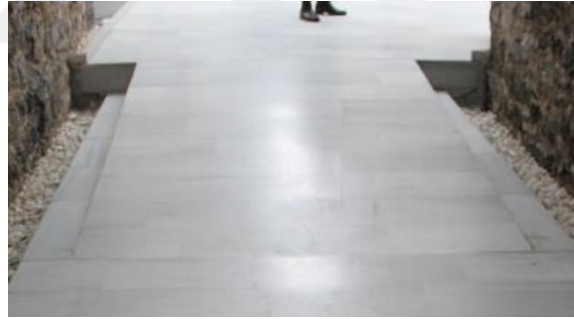
Giriş holünü koridora bağlayan rampa
