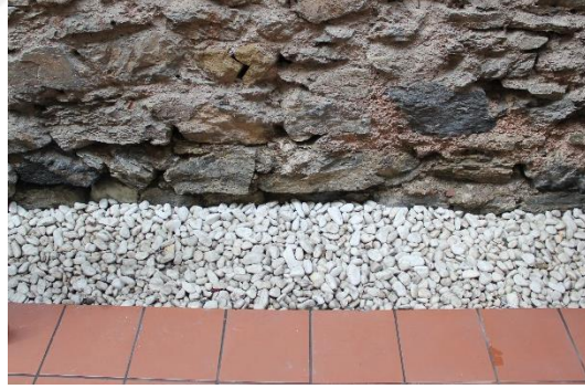
Avlu zemini-taş duvar ilişkisi
