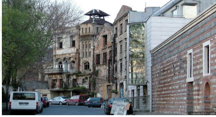
Şekil 7. Tuğla-taş almaşık duvarı sıvanmadan önce yapının ön cephesi (URL- 36)
