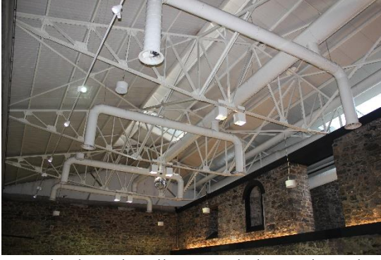
Havalandırma kanalları ve aydınlatma elemanları
