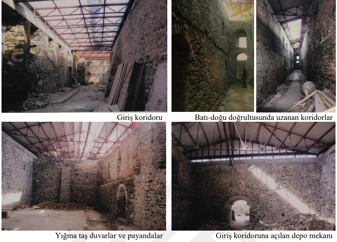
Şekil 12. Ambar yapısının restorasyon öncesi iç mekanı (İstanbul II Numaralı Kültür Varlıklarını Koruma Bölge Kurulu Müdürlüğü arşiv dosyasında 02.04.2007 tarihinde kayıtlara geçen 2006/2481 numaralı rapor ve 386 numara ve 05.02.2008 tarih kayıtlı rölöve raporu eki)
