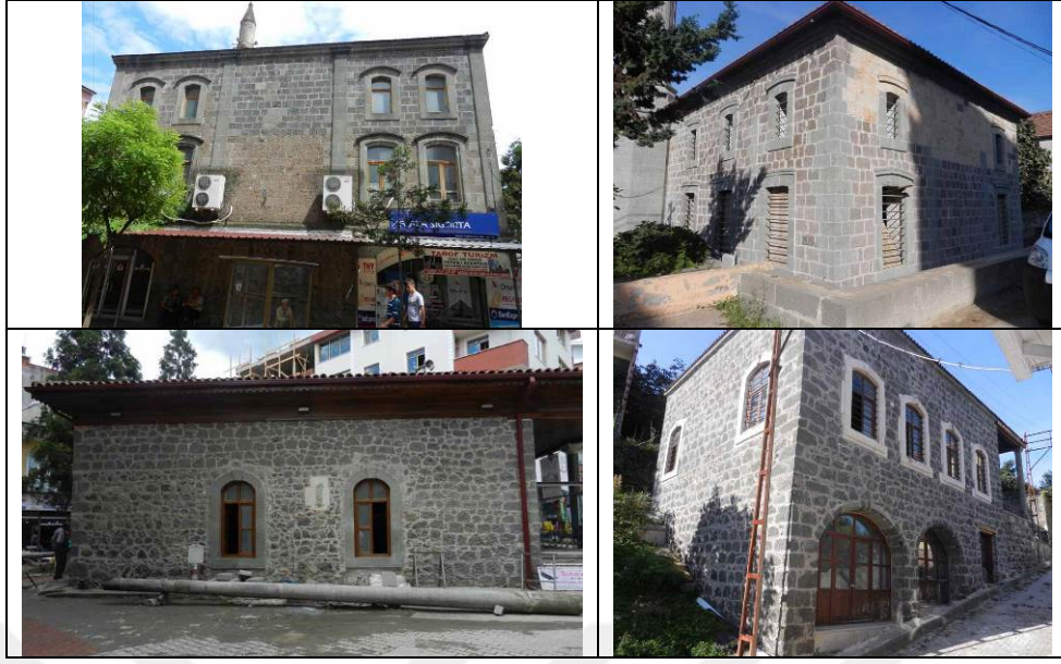
Şekil 318. Merkez Büyük Cami ve Kalecik Mahallesi Camileri (üstte), Hacı Hasan ve Konakönü Camileri'nin (altta) pencere açıklıkları ve cephe düzenleri
