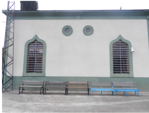
Şekil 559. Çilekli Köyü Camisindeki kaş kemer ve dairesel pencere uygulaması
