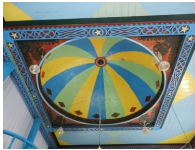
Şekil 66. Dolanlı Köyü Camisi gizli ahşap kubbesi
