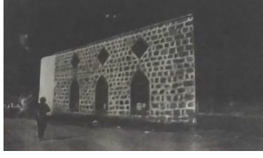
Şekil 104. Kalınçam (Kumyatak) Köyü Camisi cephesi
