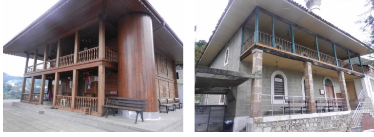
Şekil 533. Manahos Deresi Vadisi, Çamburnu Kuşluca Mahallesi Camisi ve Karacakaya Köyü Camisi
