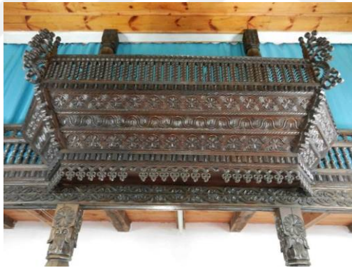
Şekil 433. Bölümlü Mithat Paşa Camisi mahfil çıkması
