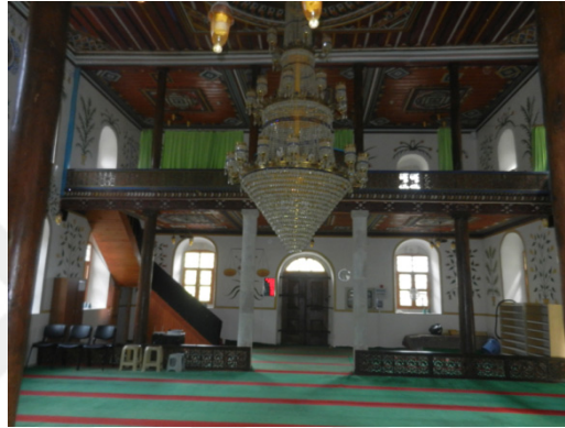
Şekil 569. Yanbolu Deresi Vadisi; Atayurt Mahallesi Merkez Camisi mahfili destekleyen ahşap ve taş sütunlar birarada
