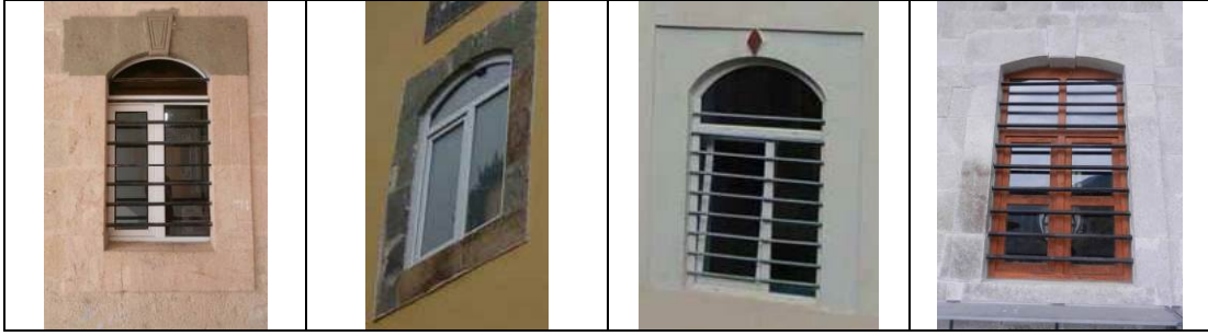
Şekil 285. Işıklı Köyü Merkez, Güneyce Köyü Orta Mahalle, Güneyce Köyü Büyük Mahalle ve Atayurt Mahallesi Merkez Camileri pencereleri
