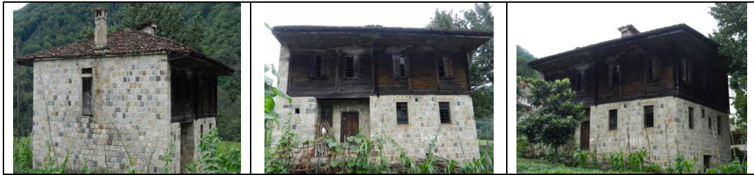
Şekil 26. Baltacı Deresi Vadisi'nin aşağı kısmından bir ev örneği
