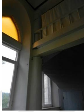
Şekil 107. Vardallı Köyü Camisinin mahfili taşıyan yekpare taş sütunu
