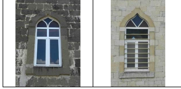
Şekil 138. Açıkan Köyü Eski ve Büyük Mahalle Tomaslı Camileri'nin kaş kemerli pencereleri
