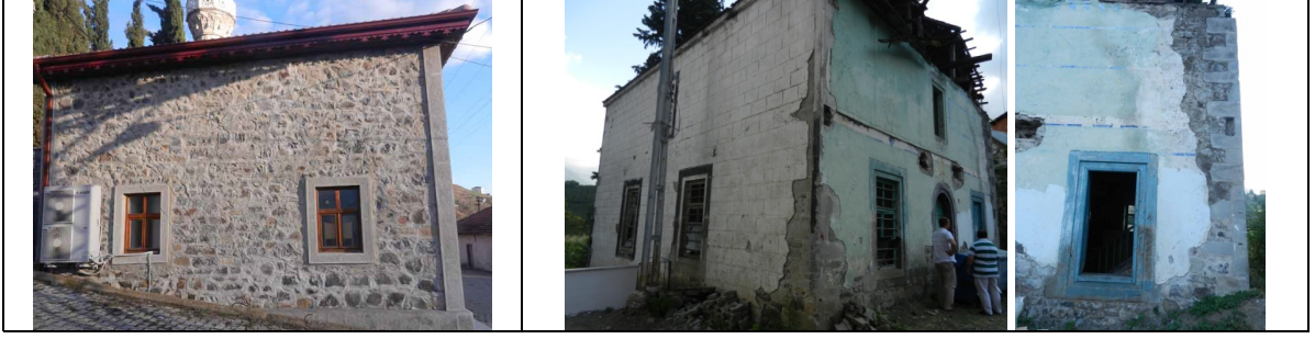
Şekil 192. Kayalar ve Şinik Mahallesi Camileri kaba yonu ve moloz karışımı duvar teknikleri
