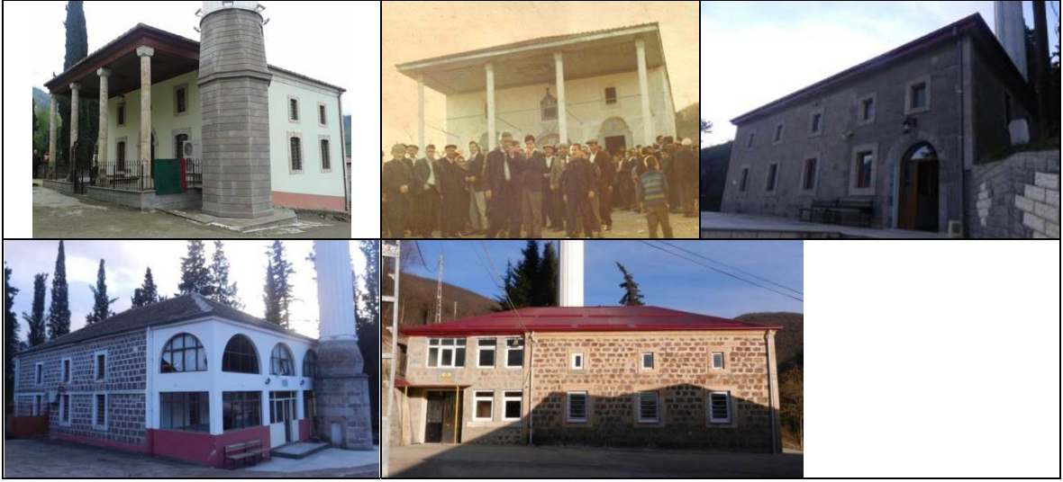
Şekil 203. Dumankaya Merkez, yıkılan eski Akçaköy Merkez, Demirtaş Köyü, Karaman-Derecik- Demirtaş Köyleri, Maden Köyü Camileri
