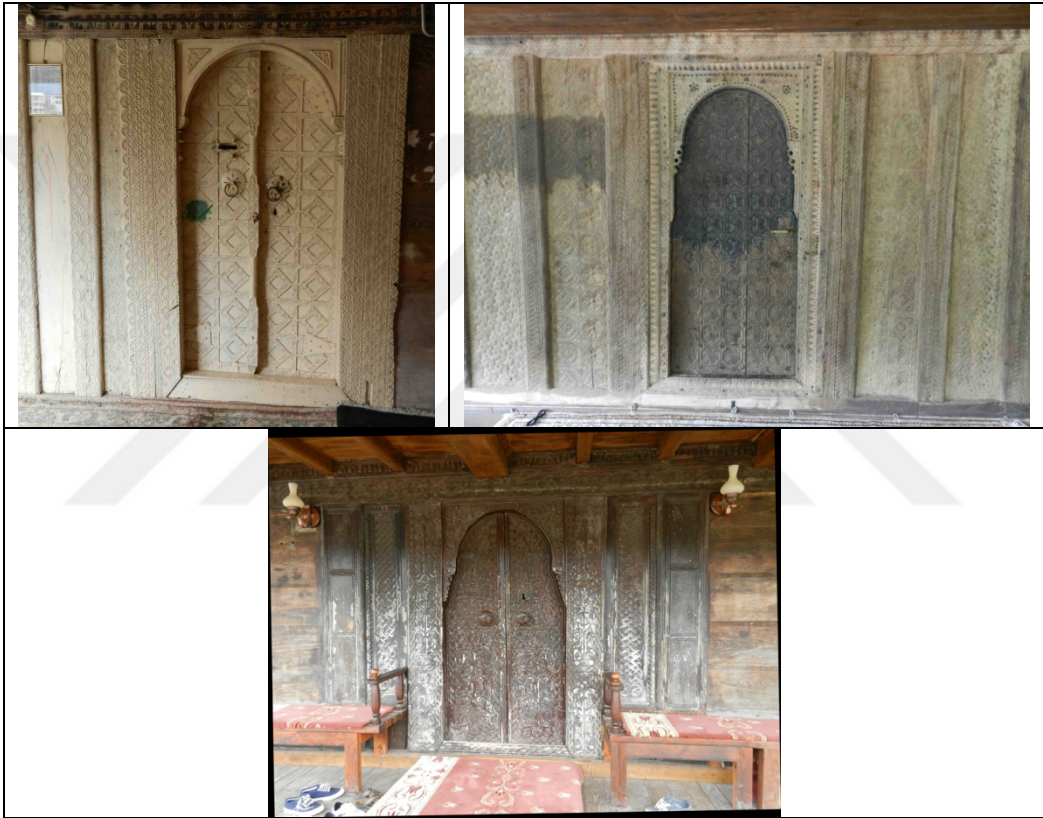
Şekil 557. Cumapazarı Serindere Mahallesi, Kondu ve Hüseyin Hoca Köyü Sahil Camileri'nin bezemeli ahşap giriş kapıları
