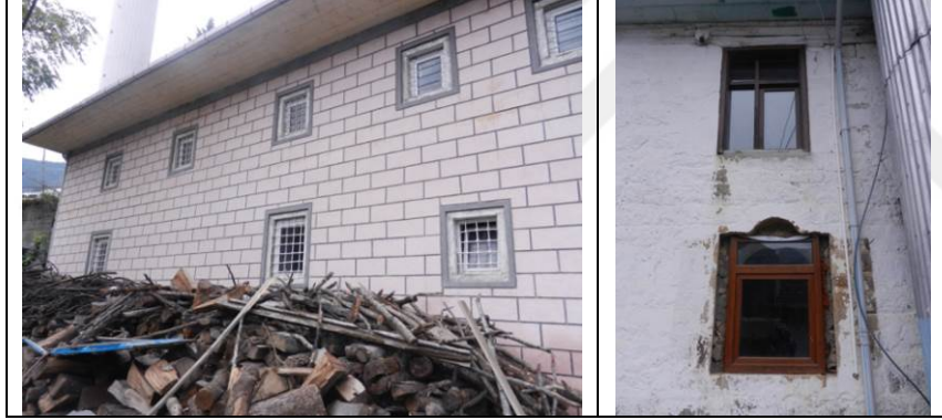
Şekil 359. Beşkøy Yılmazlar ve Yağmurlu Köyü Camileri cephe ve pencereleri
