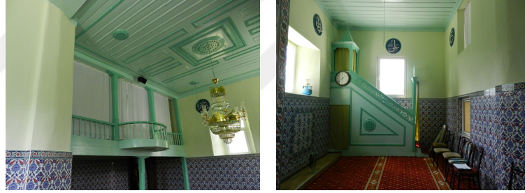
Şekil 68. Akçiriş Köyü Camisinin yıkılan doğu duvarının parçası ve doğu yönünde genişleyen harimi
