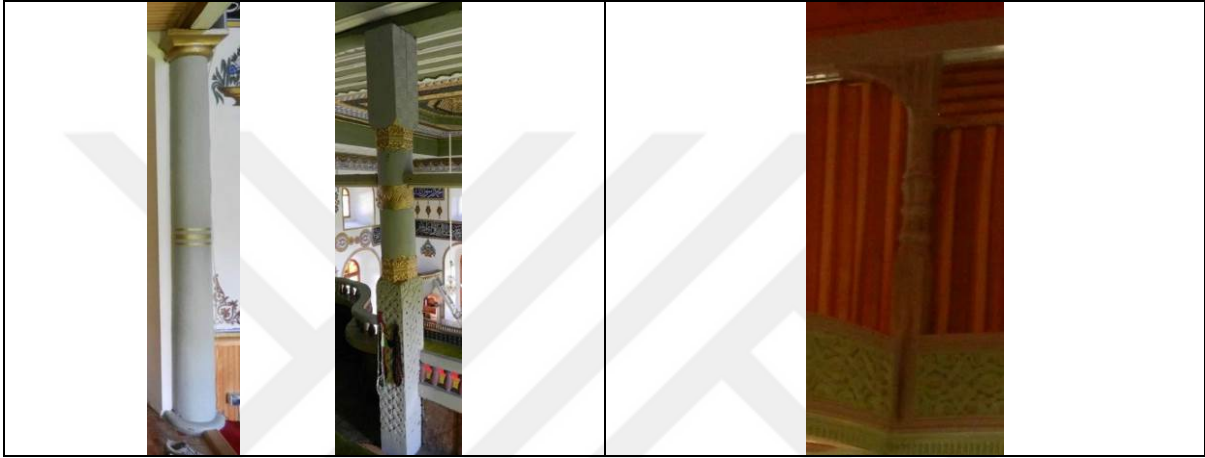
Şekil 392. Kefeli Mahallesi Camisi'nin mahfilini alttan ve üstten destekleyen ahşap sütunlar
