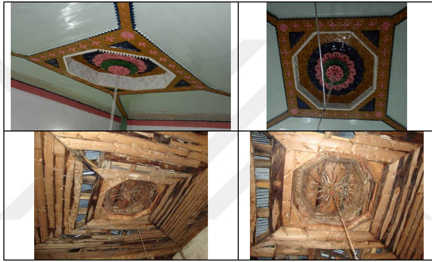
Şekil 476. Sarmaşık ve Dağönü Köyü Camileri kademeli ahşap üstörtüleri
