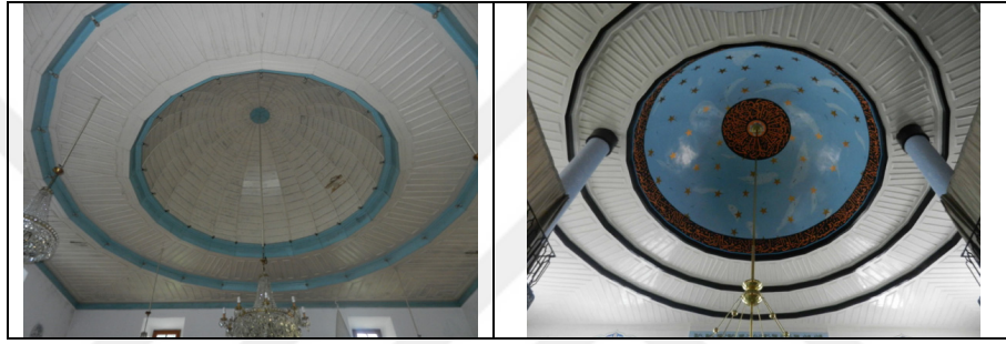
Şekil 519. Sera Deresi Vadisi; Karaman, Derecik ve Demirtaş Köyleri Merkez Camisi ve Yomra Deresi Vadisi; Tepeköy Köyü Camileri gizli kubbeleri
