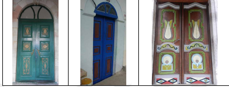
Şekil 283. Çiçekli Mahallesi Merkez, Güneyce Köyü Büyük Mahalle ve Atayurt Mahallesi Merkez Camileri kapı kanatları
