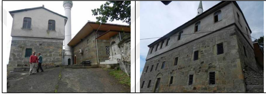
Şekil 342. Yukarı Ovalı Köyü Camisi ve yanındaki taş yapı
