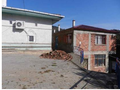
Şekil 295. Caminin sağ yanında yıkılan eski medresenin yerinde yeni lojman yapısı
