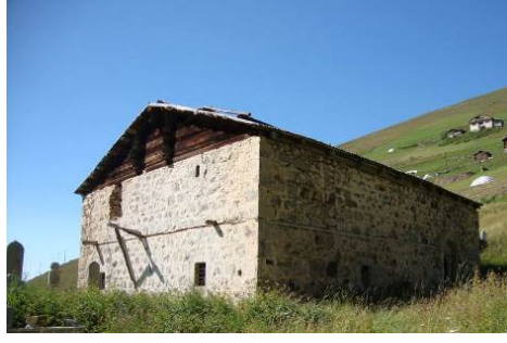
Şekil 501. Dağönü köyü eski Camisi ahşap hatıllı taş yığma duvarları
