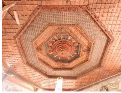
Şekil 299. Turnalı Köyü Camisi iç içe geçmiş sekizgen kademeli tavanı
