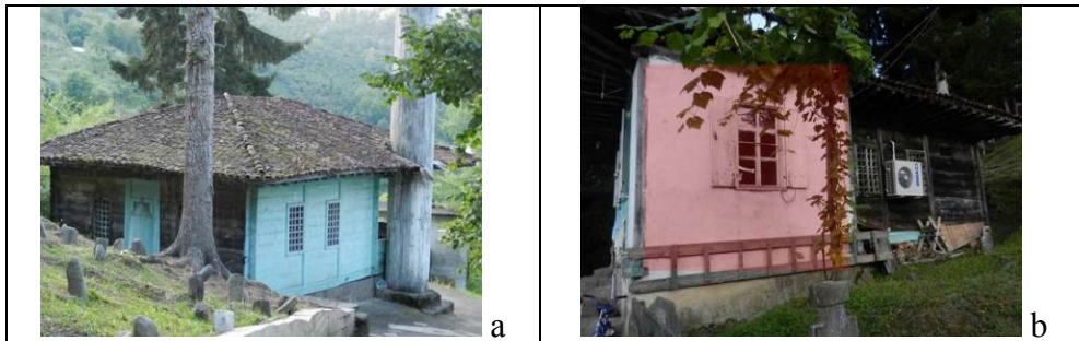
Şekil 399. Bereketli Köyü Masele Mahallesi Camisi ahşap yığma duvarlar (a) ve ahşap iskeletli kagir duvar (b)
