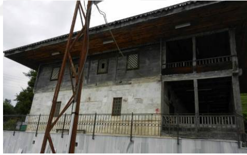
Şekil 503. Sugeldi Köyü Camisi'nin taş ve üzerine ahşap yığma olarak karma yapım tekniği
