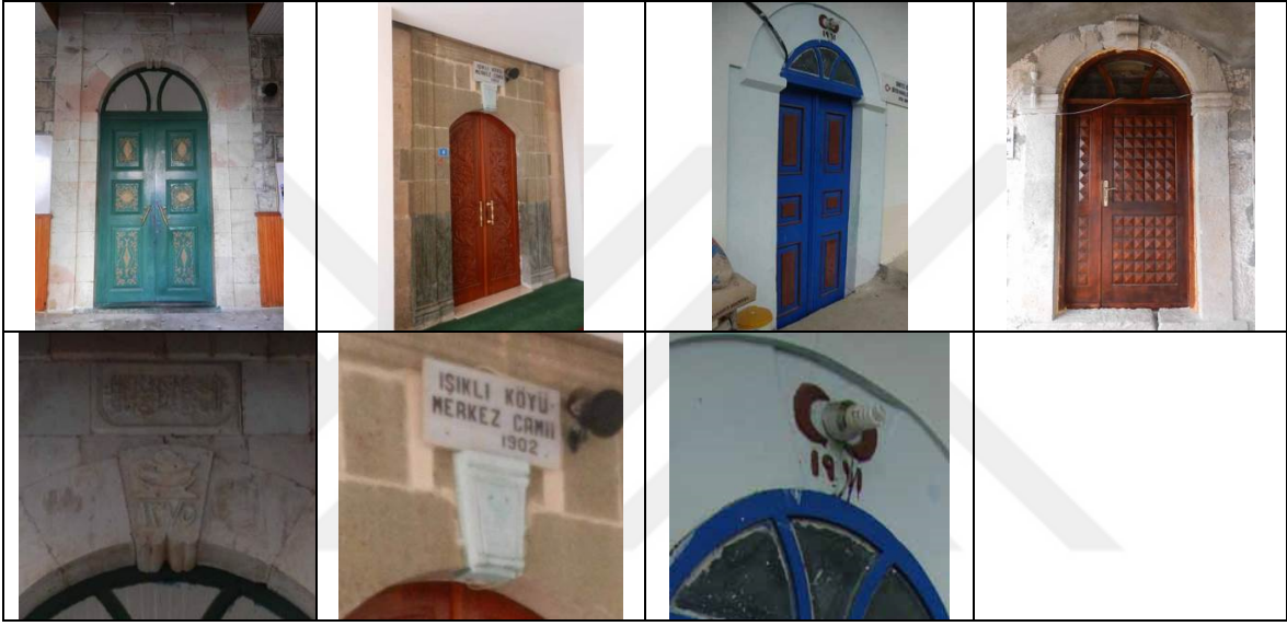
Şekil 281. Çiçekli Mahallesi Merkez, Işıklı Köyü Merkez Güneyce Köyü Büyük Mahalle ve Dilek Köyü Nuroğlu Mahallesi Camileri kemerli kapıları ve kilit taşları
