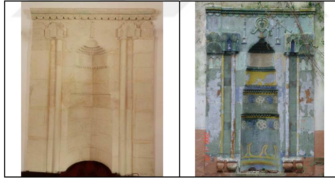
Şekil 307. Hacı Hasan ve Konakönü Camileri mihrapları
