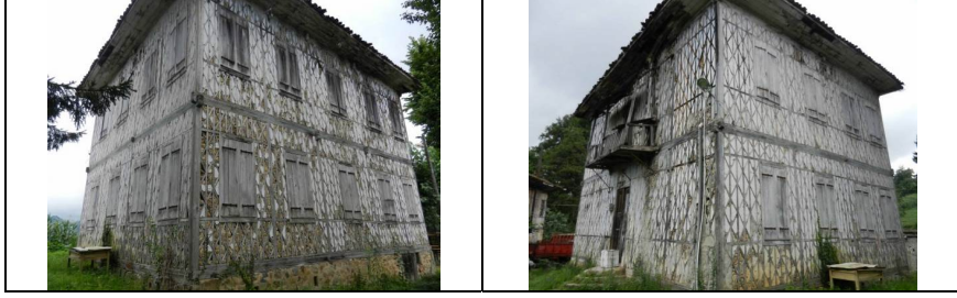
Şekil 27. Baltacı Deresi Vadisi'nin aşağı kısmından bir ev örneği
