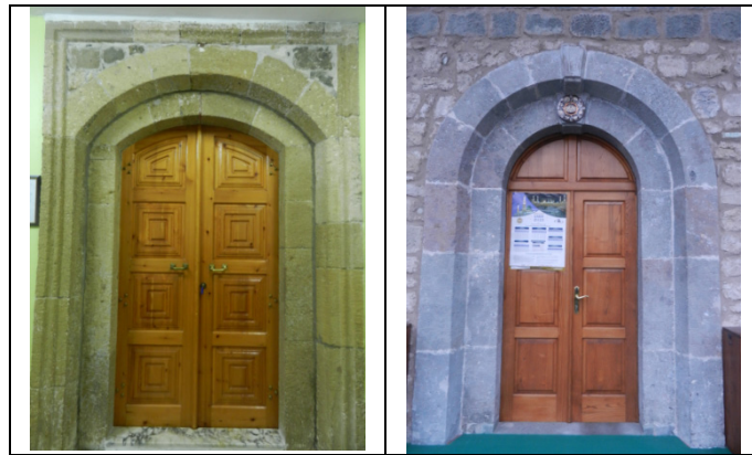
Şekil 177. Orta ve Dürbinar Mahallesi Camileri'nin kapıları
