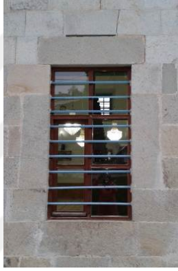
Şekil 449. Gürpınar Hacı Bayramlı Camisi penceresi üzerindeki hafifletme kirişi
