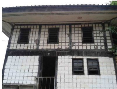
Şekil 455. Tüfekçi Köyü Elmalı Mahallesi Cumhuriyet Camisi'nin göz dolma ahşap karkas cephesi
