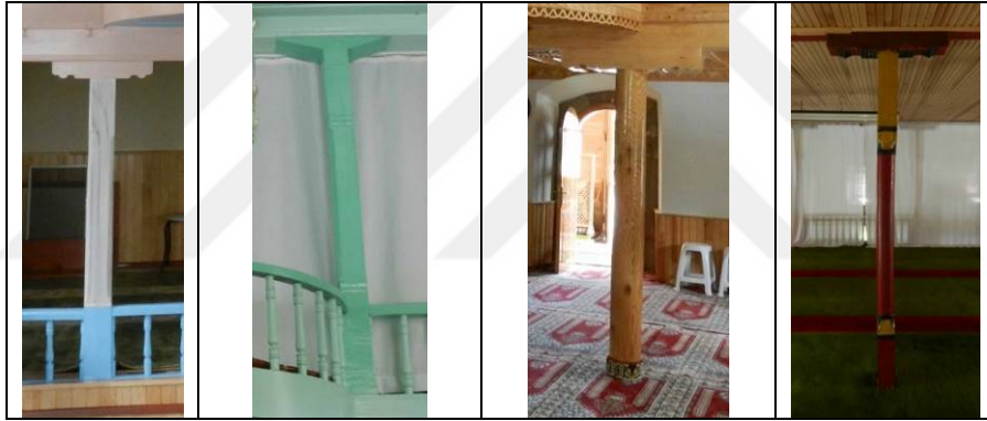
Şekil 106. Çamlıklı, Akçiriş, Dereköy ve Doğancı Köyü Camileri ahşap sütun ve destek yastıkları
