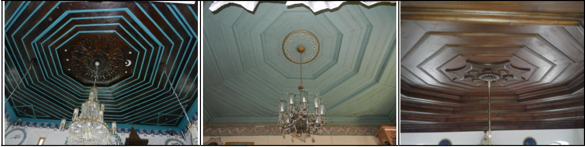
Şekil 521. Değirmendere vadisi; Akmesit (1873), Işıklar Köyü (1870) Camileri, Sera Deresi Vadisi; Dumankaya Köyü Merkez (1902) Camileri sekizgen kademeli tavanları
