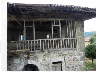
Şekil 502. Sarayköy Camisi kuzey cephesi alt kat taş yığma üzeri ahşap karkas
