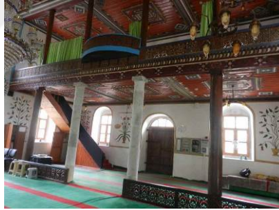
Şekil 289. Atayurt Mahallesi Merkez Camisinde mahfili destekleyen ahşap ve taş sütunlar
