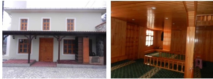
Şekil 155. Nefs-i Pulathane Camisi kuzey cephesi ve harimin kuzey doğu köşesi
