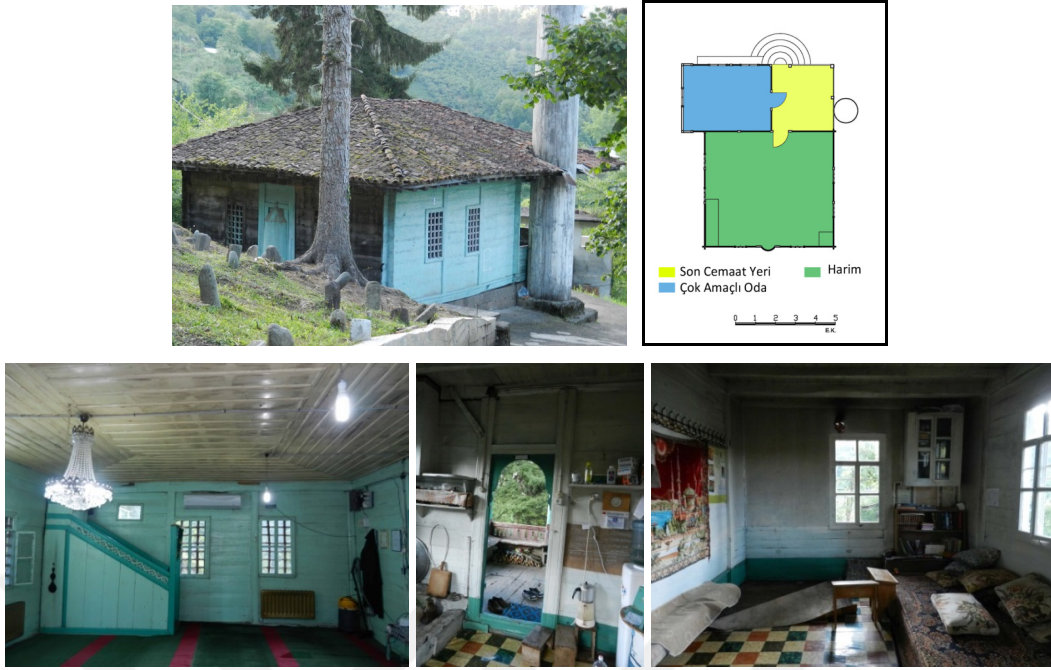
Şekil 513. Küçükdere vadisi; Bereketli Köyü Masele Mahallesi Camisi dış görünüş, plan, harim ve çok amaçlı oda
