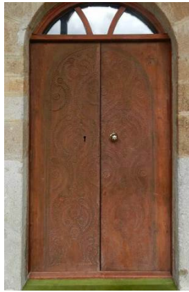
Şekil 387. Aşağı Ovalı Köyü İrfanlı Mahallesi Camisi ahşap kapı kanatları
