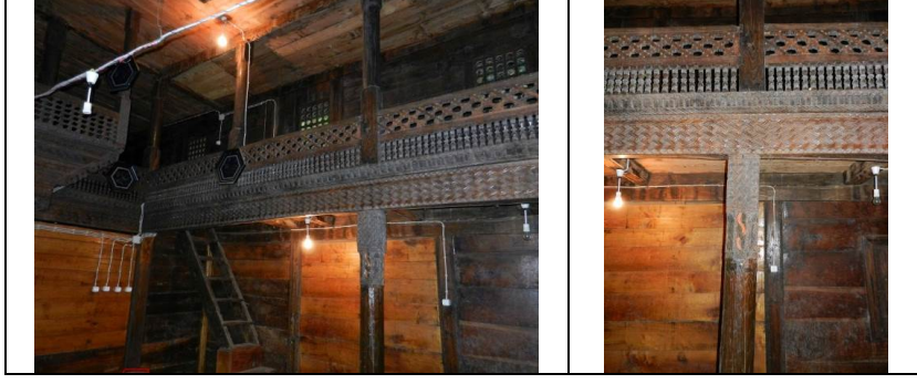
Şekil 498. Dereyurt Köyü Camisi mahfilini taşıyan sütunlar ve doğu yönünde mahfili destekleyen sütun
