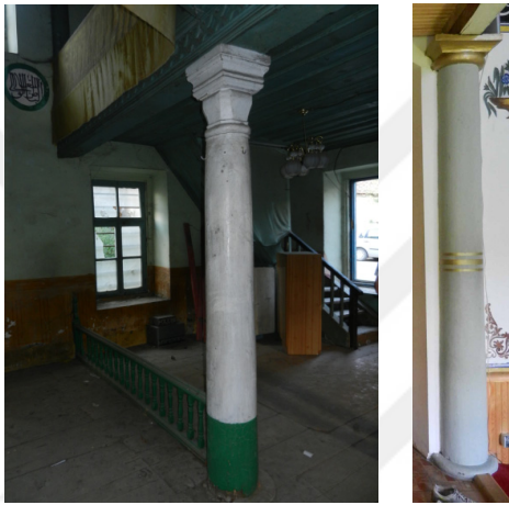
Şekil 572. Şinik Mahallesi Camisi ve Kefeli Mahallesi Camisi ahşap sütunları
