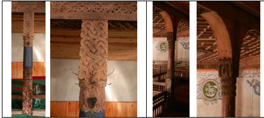
Şekil 322. Turnalı Köyü Camisinde mahfili alttan ve üstten destekleyen sütunlar
