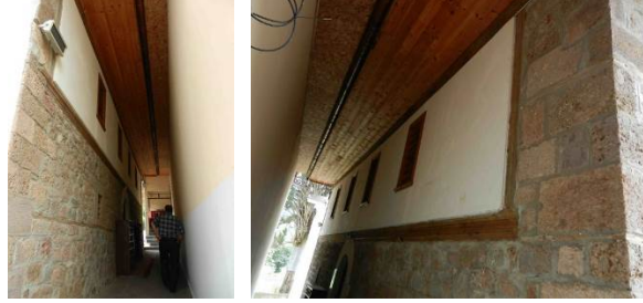
Şekil 459. Bölümlü Büyük Mahalle Camisi'nin kuzey cephesi
