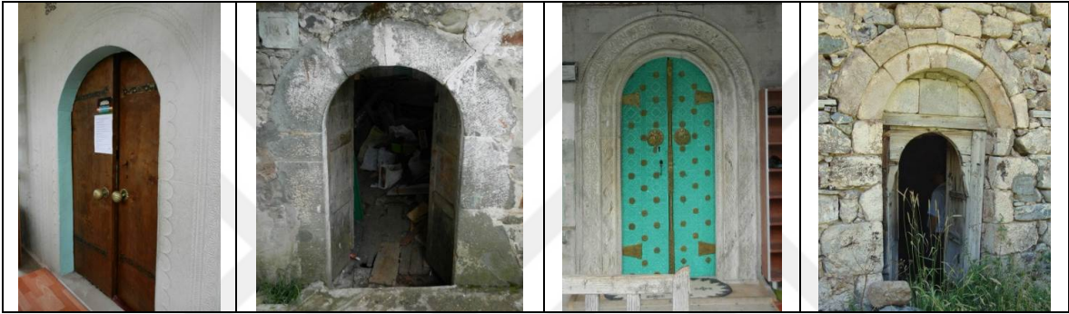
Şekil 486. Ağaçseven, Sarayköy, Sugeldi, Dağönü Köyü Camileri'nin harime giriş kapıları
