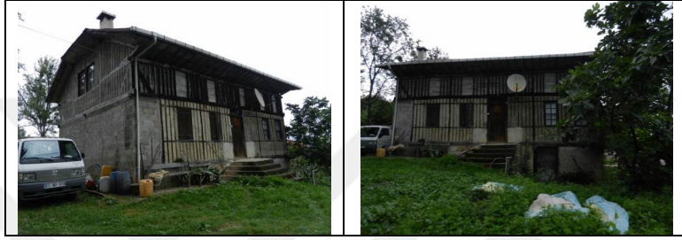
Şekil 28. Baltacı Deresi Vadisi'nin aşağı kısmından bir ev örneği
