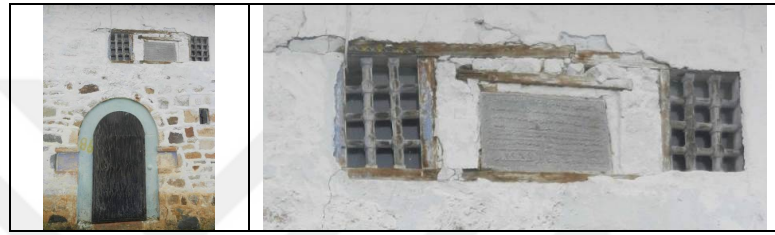
Şekil 494. Sarmaşık Köyü Camisi kuzey doğu yönünde cephedeki kapı, pencereler ve kitabe.
