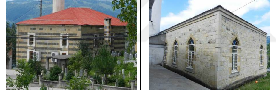
Şekil 146. Karşular Merkez Camisinin iki renkli kesme taştan almalı duvarları ve Büyük Mahalle Tomaslı Camisinin açık renkli ince yonu taş duvarları
