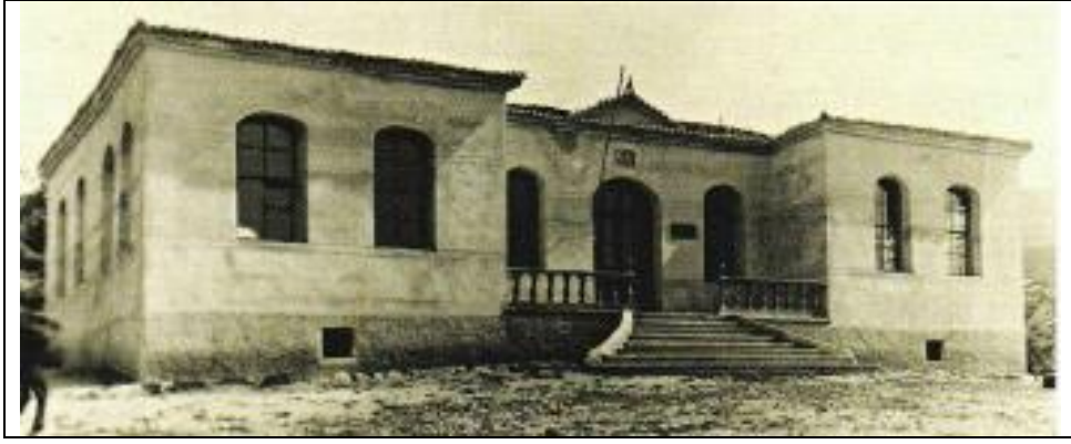
Şekil 54. Edirne Karaağaç Mektebi planının farklı bir cephe düzenlemesiyle inşa edildiği Ödemiş Suludere köyü ilkokulu (Kul, 2011).
