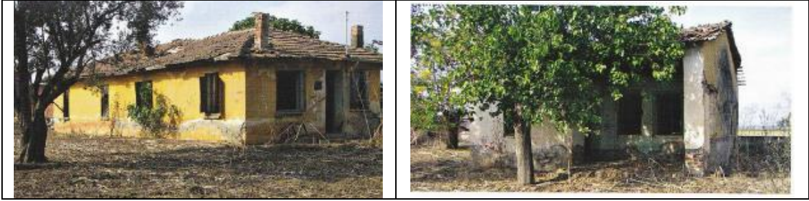
Şekil 65. Mutlu ve Yapanar'ın tasarladığı tip projeye göre 1947 yılında inşa edilmiş işlik binası ve 1946 yılında inşa edilmiş lojman binası (Kul, 2011).
