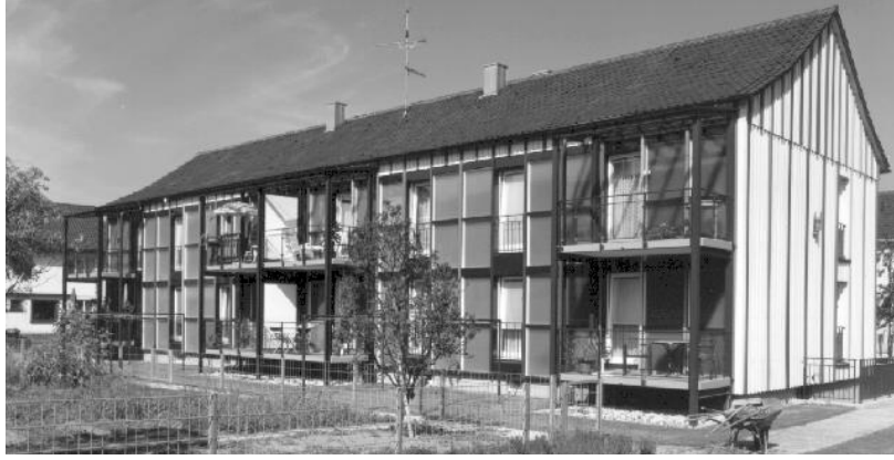
Şekil 12. Saydam yalıtım uygulanan bina cephesi, Sonnenäckerweg, Freiburg
