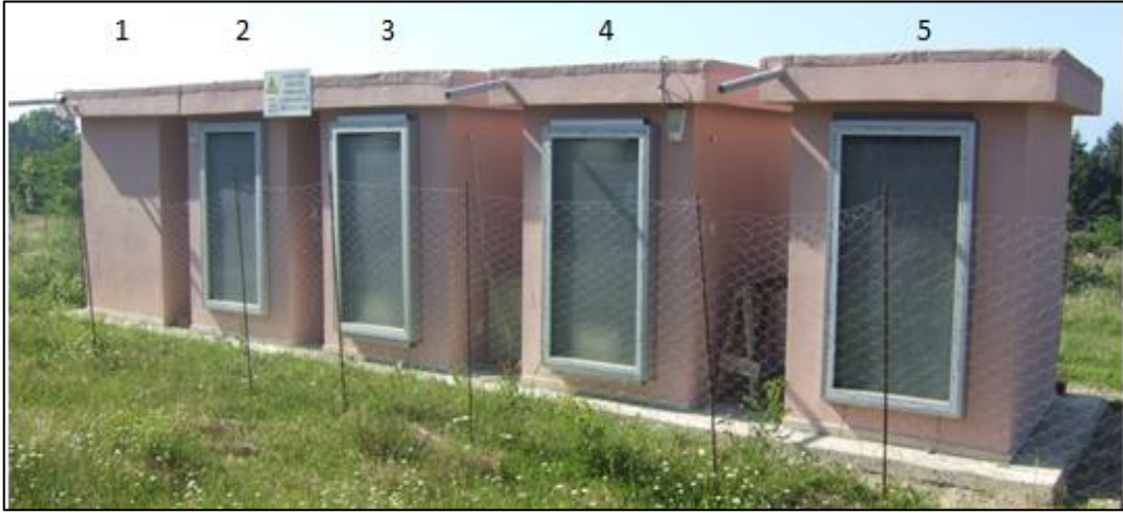
Şekil 22. Deney düzeneğinin genel görünümü (güney cephesi)
