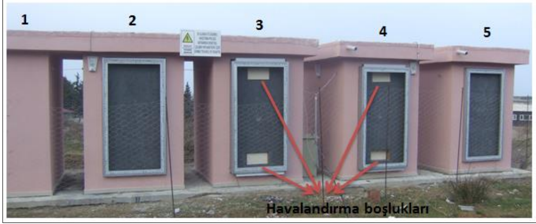
Şekil 24. Saydam yalıtım malzemesi uygulanmasından önce boyanan siyah yüzeyler ve duvarda açılan havalandırma boşlukları
