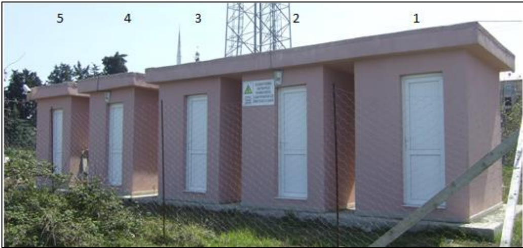
Şekil 23. Deney düzeneğinin genel görünümü (kuzey cephesi)
