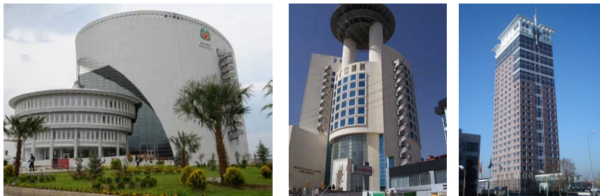
Şekil 89. Malatya Belediyesi, MHP Parti Binası, Tekfen Holding Binası
