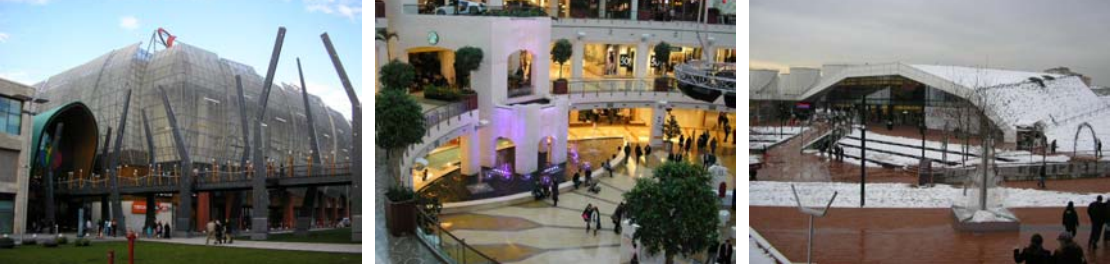
Şekil 4. Forum İstanbul, İstinyepark, Meydan alışveriş merkezlerinde içerisi dışarı ilişki kalitesiyle ilgili görünüm
