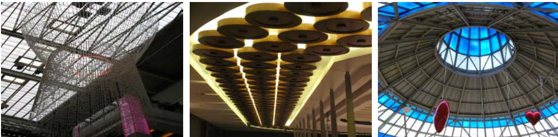
Şekil 10. Capitol, City's, Carrefoursa alışveriş merkezlerinde aydınlatma kalitesiyle ilgili görünüm
