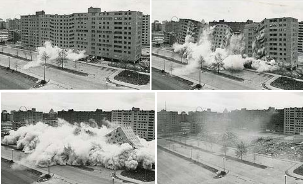
Şekil 97. Le Corbusier/St. Louis-Pruitt İgoe konutlarının yıkılma görüntüleri [329]
