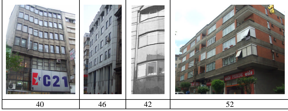
Şekil 21. Trabzon ili Brütalist yapı örnekleri
