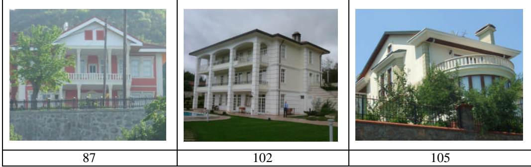
Şekil 32. Trabzon ili Eklektik-Popülist Postmodern yapı örnekleri
