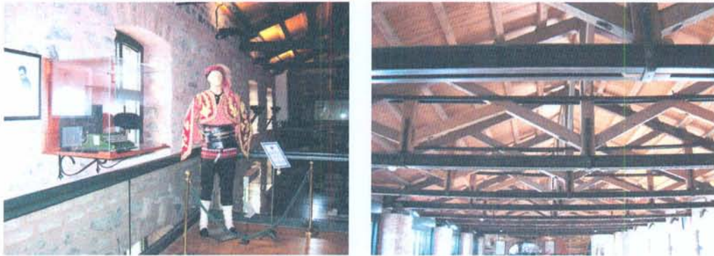
Şekil 139. Hasköy Tersanesi'nin L binasına restorasyon sırasında eklenen ara kat ile duvar arasındaki boşluk (solda) ve korunan ahşap çatı makaslarından görünüm [274].
