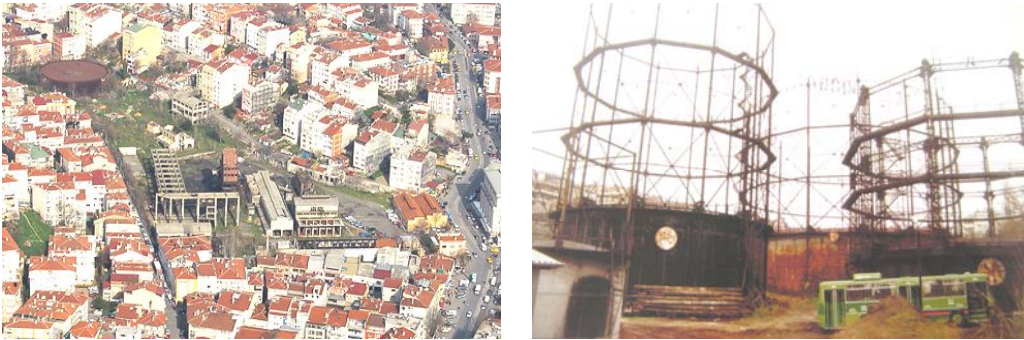
Şekil 84. Hasanpaşa Gazhanesinin havadan görünümü (solda) [226] ve günümüzde sadece biri ayakta kalan gazometrelerinden (sağda) [224] görünüm
