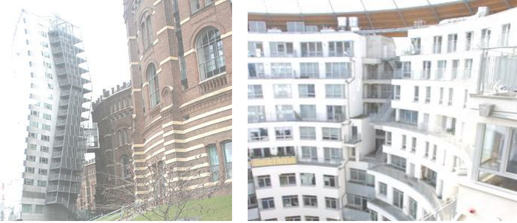
Şekil 57. Viyana'daki Gazometre B Binasıyla bağlantılı ek kütle (sağda) [127] ve Gazometre C Binasının içinde inşa edilen konut cephelerinden (solda) görünüm [128].
