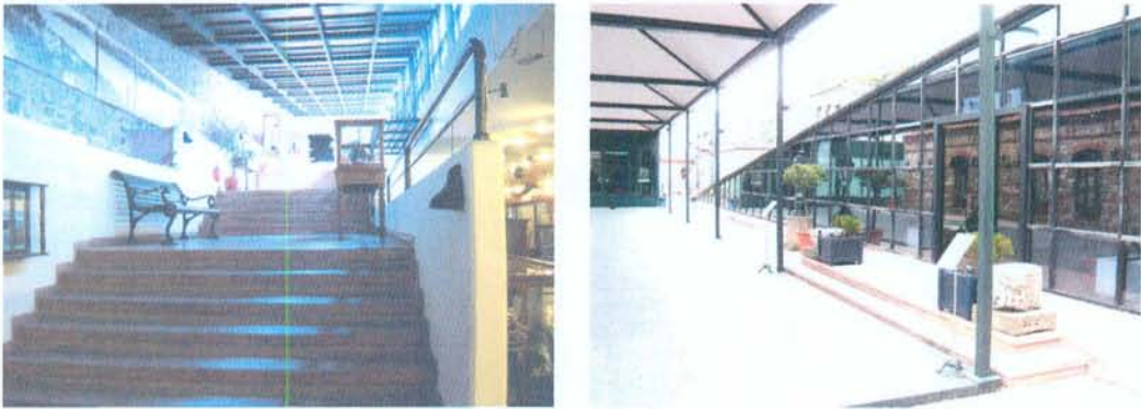
Şekil 130. Lengerhane'nin avlusunun altında inşa edilen ek binayla bağlantısını sağlayan merdivenlerden (solda) ve bu merdivenlerin avluya bağlantısının sağlandığı kapısından (sağda) görünümeler [269].
