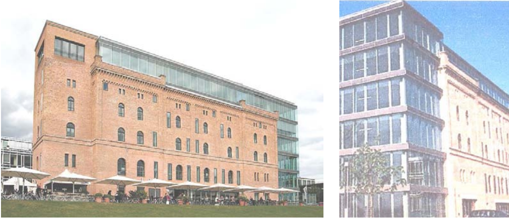
Şekil 38. Beuel'deki (Bonn-Almanya) eski çimento fabrikasının (Oberkasseller Zementwerk) ofis kompleksine dönüştürüldükten sonra cephesine ve çatısına uygulanan saydam ekten görünüm [84].
