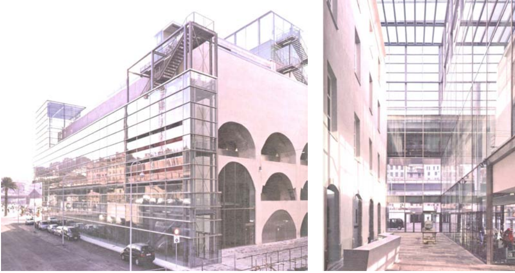
Şekil 39. Galata Deniz Müzesi (Galata Maritime Muzeum) olarak yeniden kullanılan Cenova'daki (İtalya) tarihi tersane ve cephaneliğin cephesine eklenen cam kafesin dıştan (solda) ve içten (sağda) görünümüleri [85].
