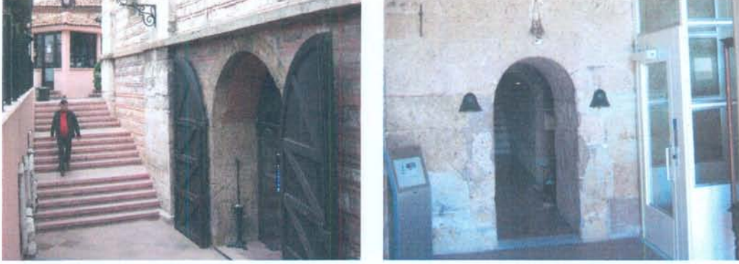
Şekil 125. Lengerhane'nin müze girişi olarak kullanılan kuzeybatı cephesindeki girişi (solda) ile girişin hemen ardında yer alan tunç fırınına ulaşan geçitin girişinden (sağda) görünüm [269].
