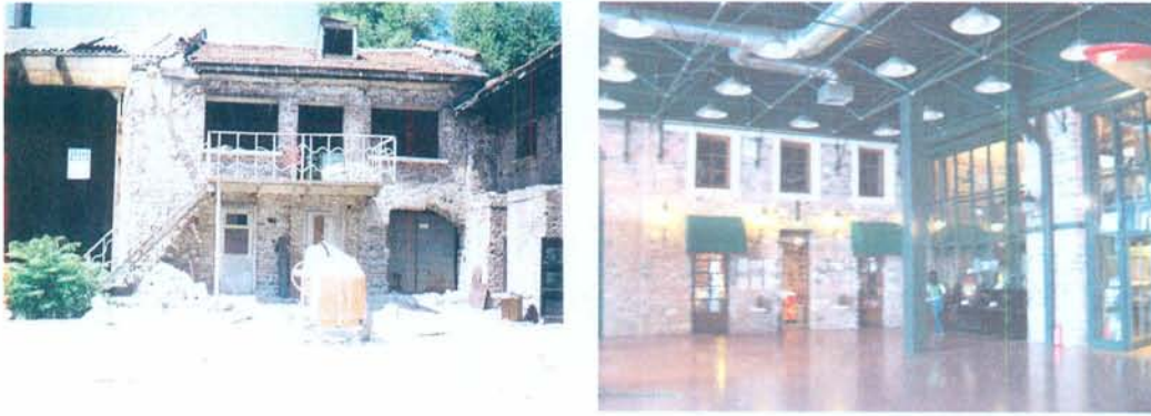
Şekil 137. Restorasyon sonrasında özgün görünümüne kavuşturulan Hasköy Tersanesi'nin J binasının avluya bakan cephesinin restorasyon öncesinden (solda) [155] ve sonrasında (sağda) görünümü [274].
