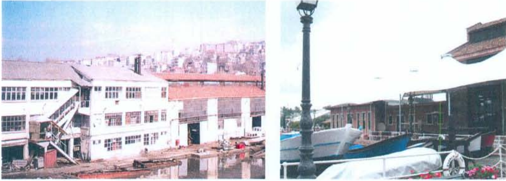
Şekil 141. Tek katlı olarak yeniden yapılan Hasköy Tersanesi'nin N binasının restorasyondan önceki 3 katlı betonarme halinden (solda) [273] ve restorasyon sonrasında (sağda) görünüm [274].
