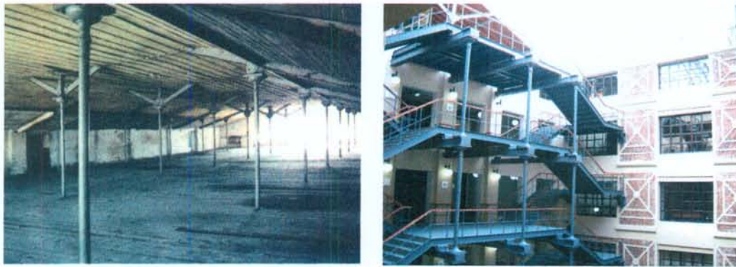
Şekil 99. Cibali Tütün ve Sigara Fabrikası'nın H Binasında, yeniden kullanım sonrası oluşturulan atriumun, restorasyon öncesi (solda) [248] ve restorasyon sonrası (sağda) [231] görünüşleri
