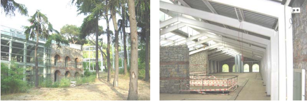
Şekil 83. Kuzguncuk Gazhanesinin günümüzdeki restorasyon aşamasında, cephesinden (solda) ve iç mekanından (sağda) görünüm, 2008 [156].
