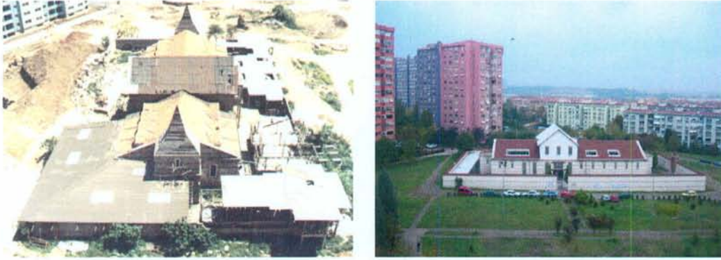
Şekil 115. İspirtohane'nin önceki restorasyonunda aldığı ekler (solda) [155] ve eklerin temizlendiği günümüzden görünümü [265].
