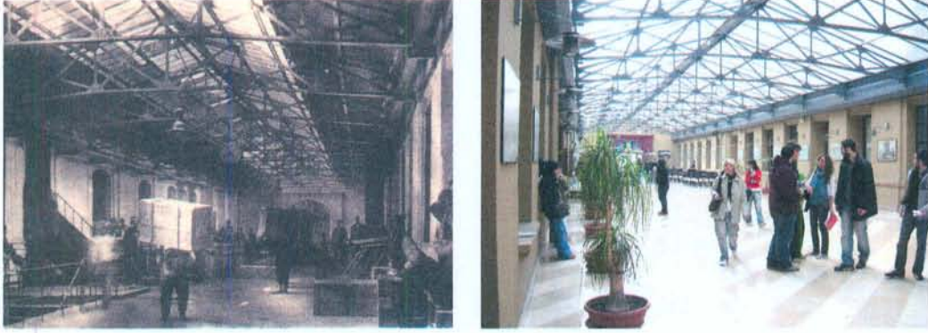
Şekil 100. Cıbalı Tütün ve Sigara Fabrikası'nın mamul giriş çıkışının yapıldığı geçidin, restorasyon öncesi (solda) [248] ve sonrasında (sağda) [231] görünümüne ait fotoğraflar
