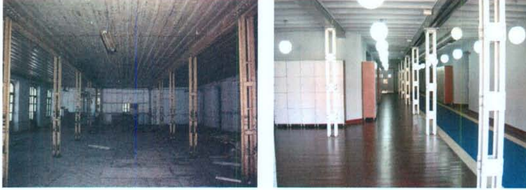
Şekil 98. Cibali Tütün ve Sigara Fabrikası'nın yeni bölücü elemanlar kullanılan mekanlarının restorasyon öncesi (solda) [248] ve restorasyon sonrası (sağda) [231] görünüşleri
