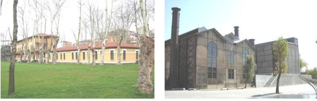
Şekil 88. Silah tarağı Elektrik Fabrikası'nda Rezidans olarak kullanılan lojman binaları (solda) ve Kütüphane olarak kullanılacak olan 1 ve 3 numaralı kazan dairelerinden (sağda) görünümü [156].
