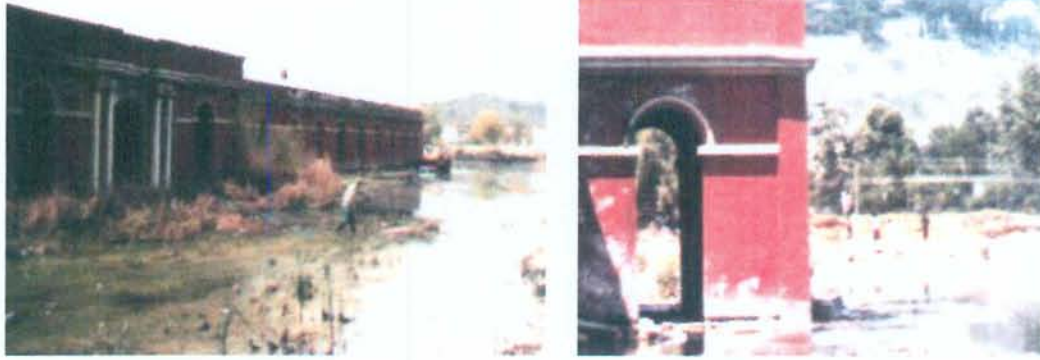
Şekil 105. Feshane'nin restorasyonu öncesinde, Haliç'ten sızan suyun cümle kapısı önünde oluşturduğu görüntü [257].
