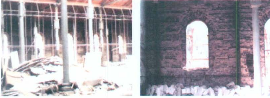
Şekil 107. Feshane'nin önceki restorasyonundan kalma bölücü eklerin temizlenmesi (solda) ve duvarlardaki kaplamaların sökülerek raspa edilmesi (sağda) aşamasından görünüm [257].
