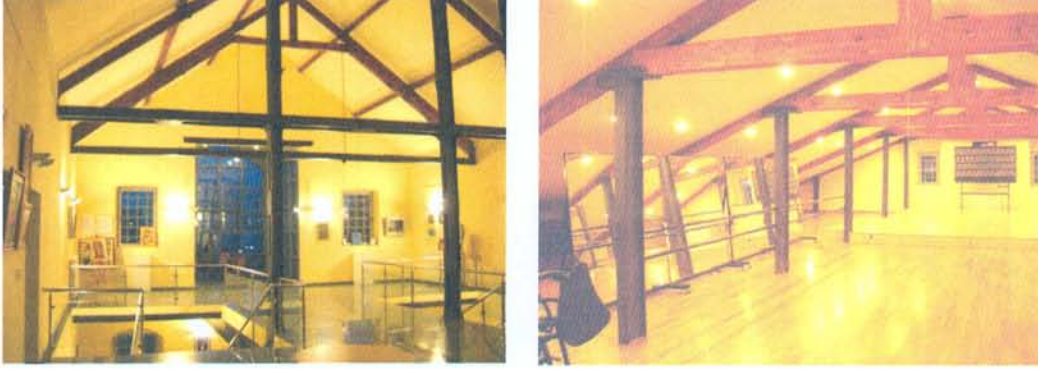
Şekil 118. İspirtohane'nin sağlamlaştırılarak korunan çatı makaslarından görünüm; geçici sergi alanı (solda), prova odaları (sağda) [264].
