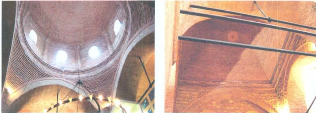
Şekil 126. Lengerhane'nin raspa edilerek tuğla dokusu ortaya çıkarılan orta kubbesinden (solda) ve yeniden yapılan tonozlarından (sağda) görünüm [269].
