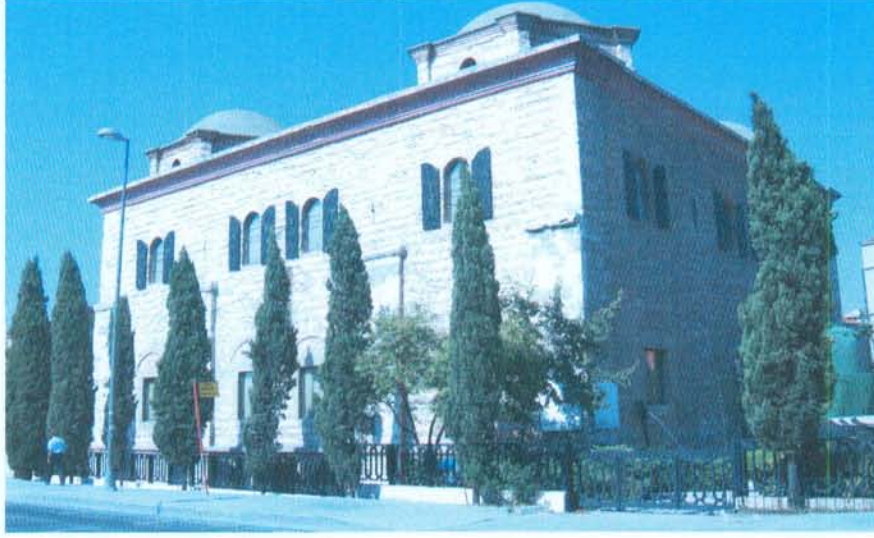
Şekil 121. Yapının genel görünümü [269].
