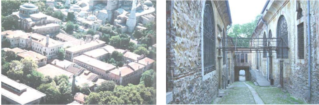
Şekil 76. Darphane-i Amire yapılarının havadan (solda) [199] ve çarkhane ve kalıp atölyesinin açıldığı sokaktan, 2008 (sağda) [156] görünüm
