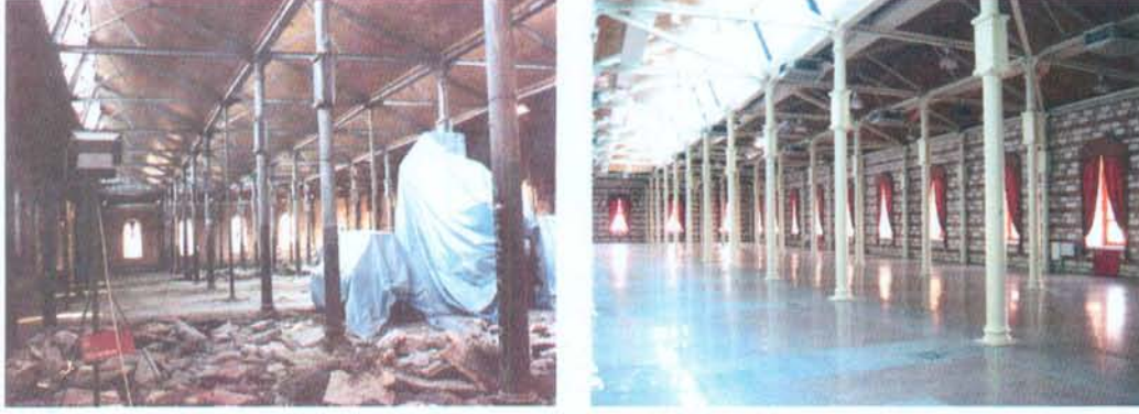
Şekil 109. Feshane'nin temizlenerek korunan döküm kolonları ve çelik kirişlerinin restorasyon öncesi (solda) [155] ve sonrasında (sağda) [258] görünümüne
