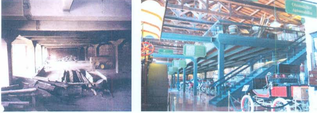
Şekil 136. Sonradan eklenen betonarme ara katı temizlenerek yerine çelik konstrüksiyonlu ara katı eklenen Hasköy Tersanesi'nin C binasının restorasyon öncesinden (solda) [155] ve sonrasında (sağda) görünümü [274].
