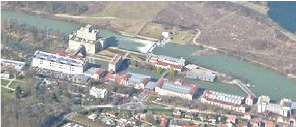
Şekil 51. Nestle genel Merkezi olarak yeniden kullanılan Noisel'deki Menier Çikolata Fabrikasının binalarından görünüm [117].
