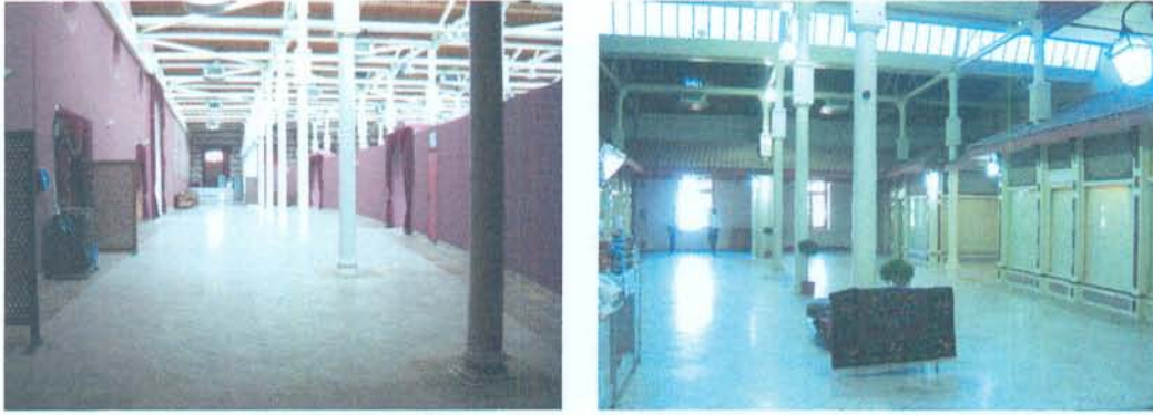
Şekil 108. Feshane'nin önceki restorasyonunda ilave edilen kavisli duvar (solda) ve bölücüler eklenerek oluşturulan ofis birimlerinden (sağda) görünüm [258].
