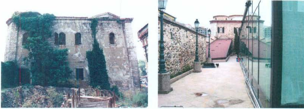
Şekil 124. Lengerhane'nin özgün girişinin bulunduğu kuzeybatı cephesinin restorasyon öncesindeki (solda) [155] ve restorasyon sonrasında eklentilerle görünümü (sağda) [269].
