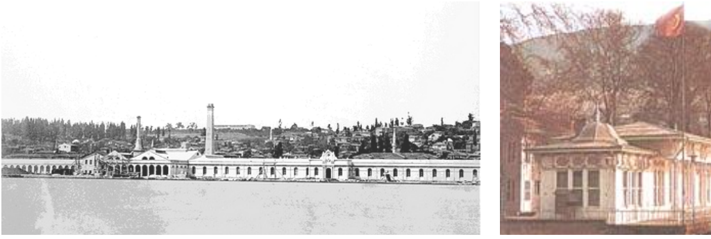
Şekil 66. 19. yüzyıl sonunda Feshane-i Amire'den (solda) [154] ve 1970'lerde Hereke Fabrika-i Hümayunundan (sağda) [169] görünümeler
