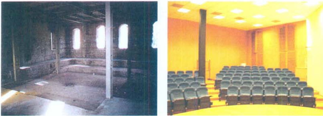
Şekil 114. İspirtohane giriş katı kuzey mekanının restorasyon öncesinden (solda) [155] ve çok amaçlı salon olarak düzenlendiği restorasyondan sonraki (sağda) [264] görünümü
