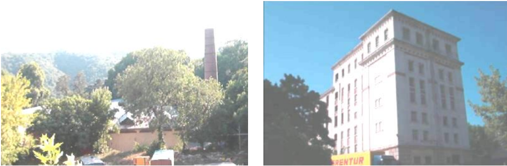
Şekil 70. Büyükdere Tekel Kibrit ve Nektar Fabrikası'nın depo (solda) ve lojman (sağda) olarak kullanılan yapılarından görünümüne ait iki fotoğraf.
