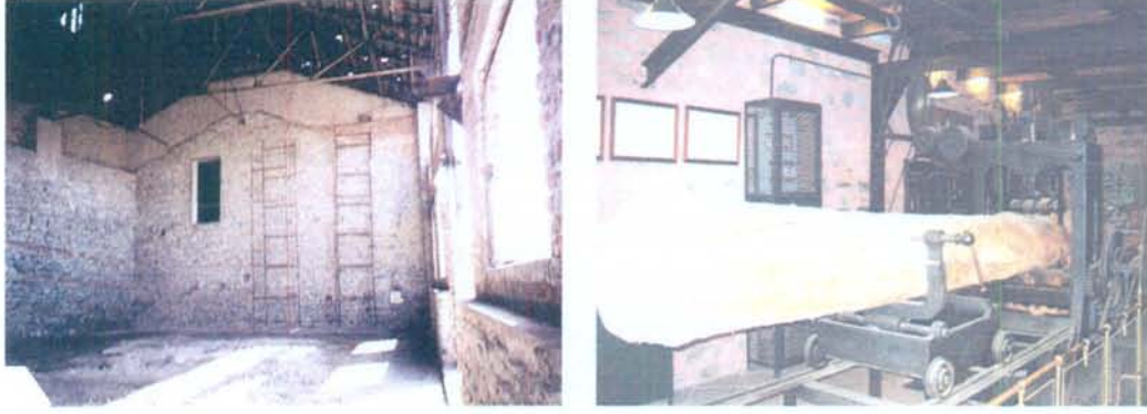
Şekil 134. Haliç Tersanesi'nin özgün taş duvarları üzerine ilaveler yapılarak çatı makasları yükseltilemiş D binasından (solda) ve aynı binada korularak sergilenen tescilli katarakt tezgahından (sağda) görünüm [274].
