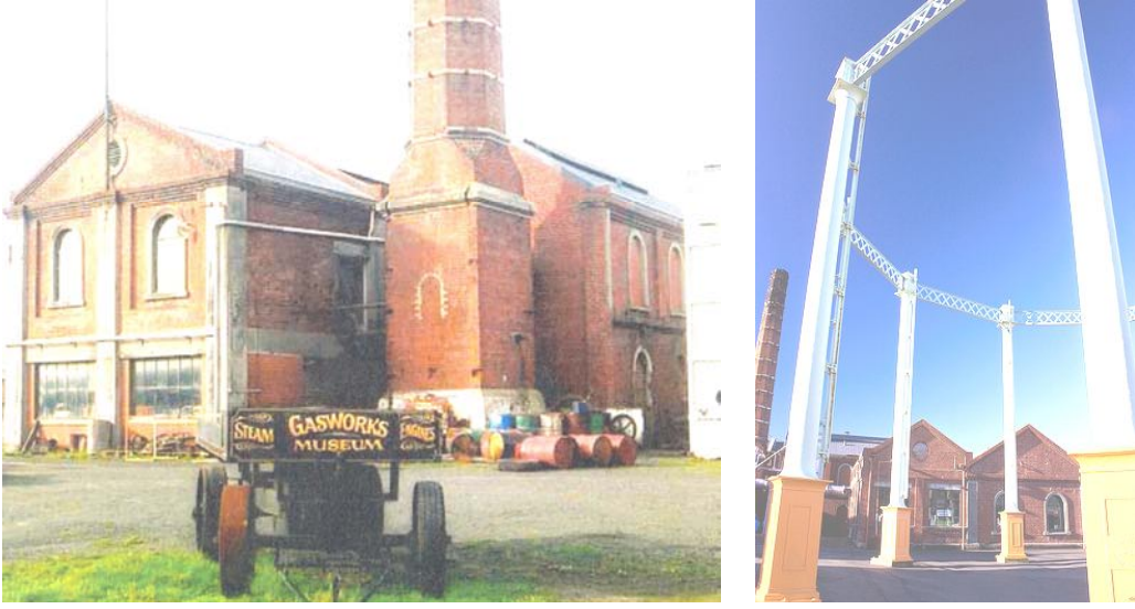
Şekil 45. Havagazı Müzesi olarak yeniden kullanılan Dunedin'deki eski Havagazı Fabrikasının korunan makine dairesi (solda) ve yeniden yapılan gazometresine ait sütunlar ve kafes kirişleri (sağda) [110].
