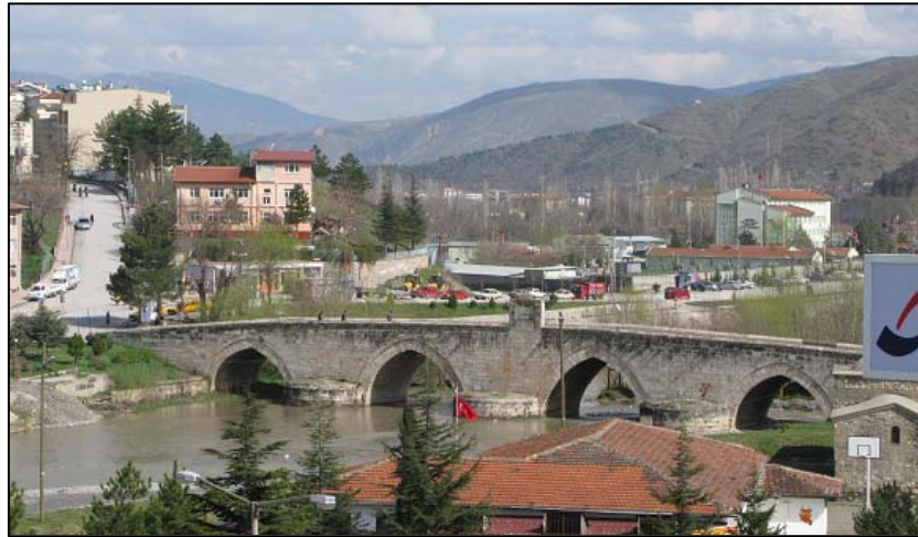
Şekil 24. Hıdırlık (Yeşilirmak) Köprüsü
