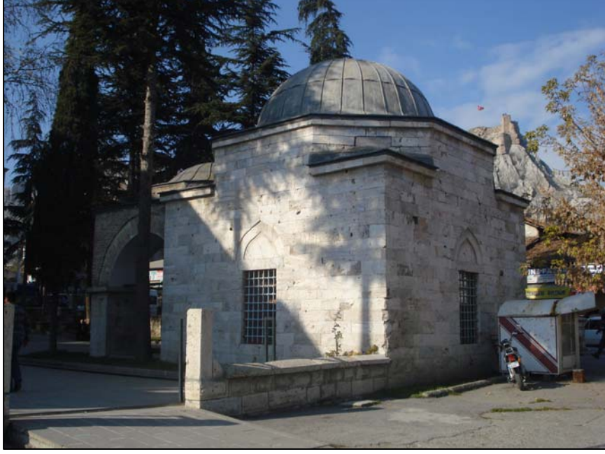
Şekil 150. Ali Paşa Türbesi
