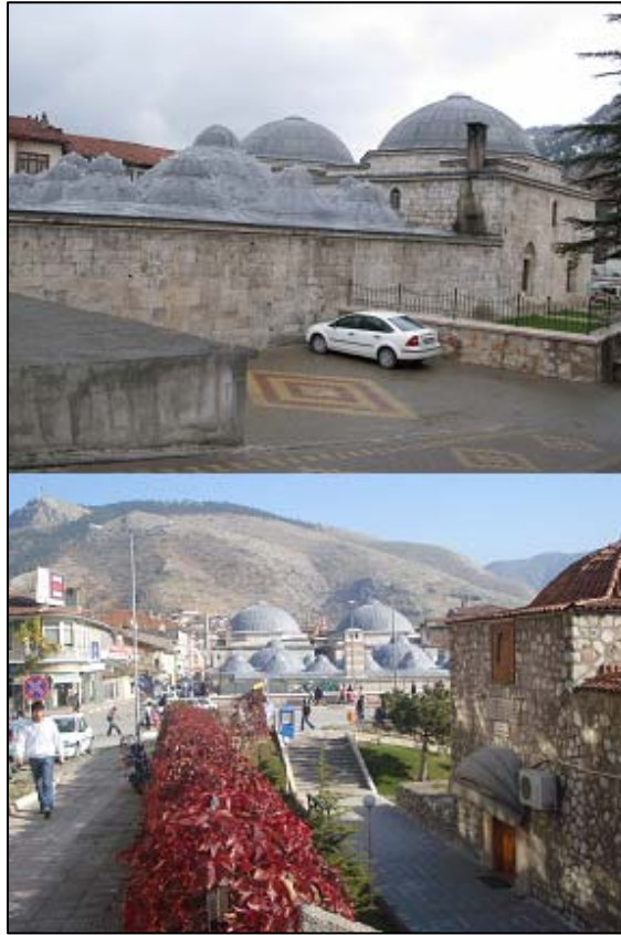
Şekil 166. Ali Paşa Hamamı
