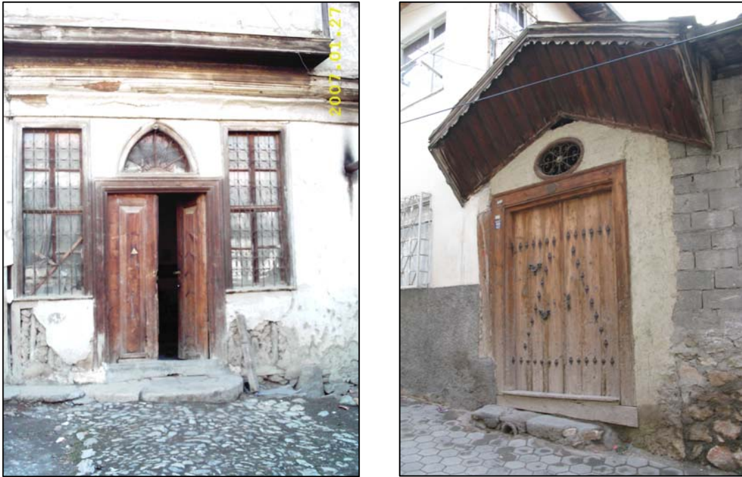
Şekil 205. Ahşap giriş kapısı
