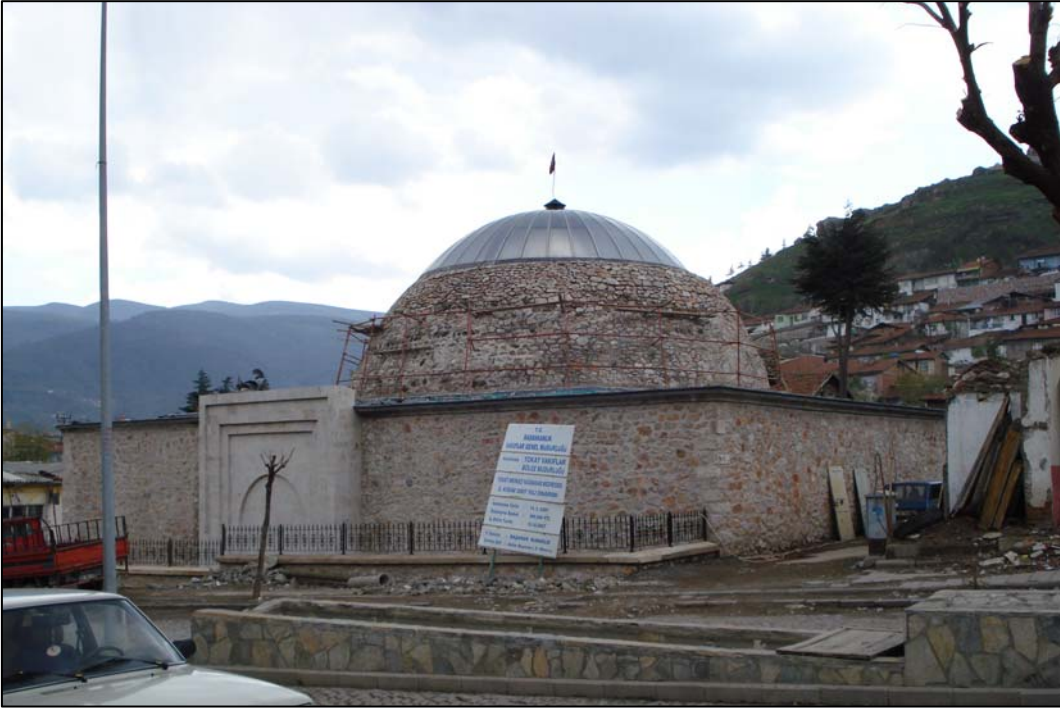
Şekil 22. Çukur (Yağıbasan) Medresesi restorasyonu tamamlandıktan sonra
