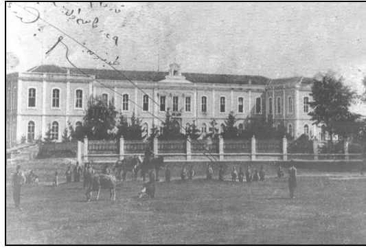
Şekil 43. Trabzon Lisesi’nin yıktırılan eski binası, (Albayrak, 2008: 210).
