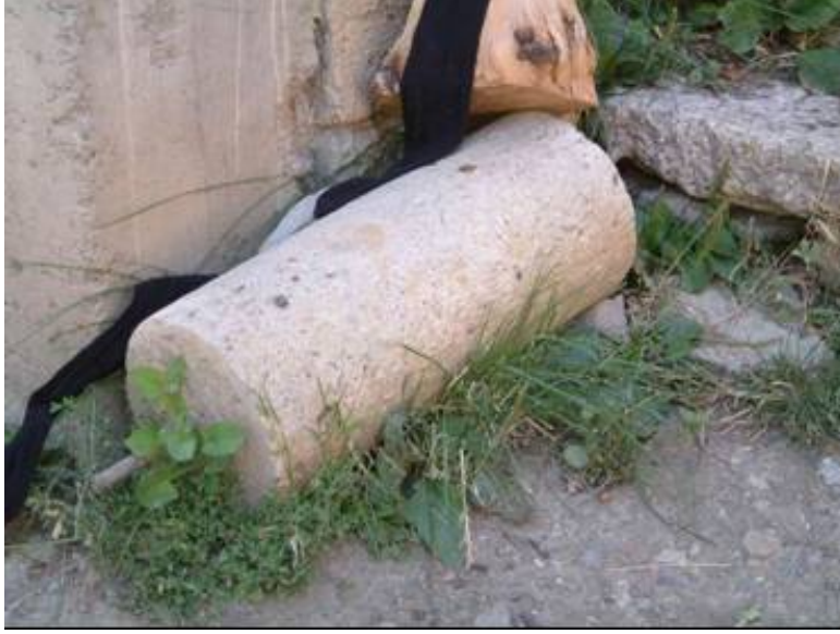
Şekil 41. Düz damların sıkıştırılmasında kullanılan loğ taşı
