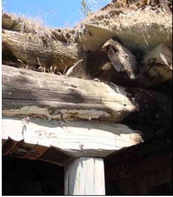
Şekil 38. Ahşap taşıyıcı sistemli kırlangıç örtü bindirme sistemi
