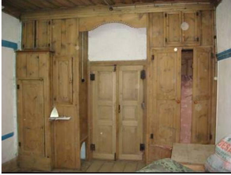
Şekil 73. Oda içi yüklük (içerisinde hamamcık kısmı bulunan)
