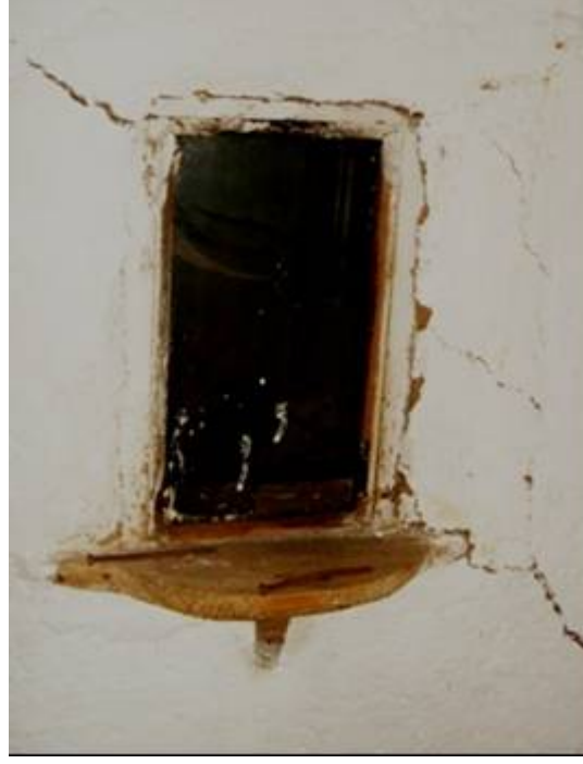
Şekil 57. Merdiven aydınlatma penceresi
