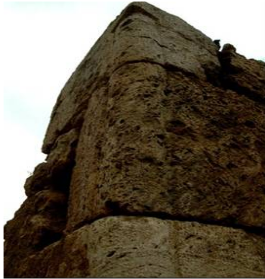
Şekil 82. Sokağa uygun formda köşe pahlı taş duvar
