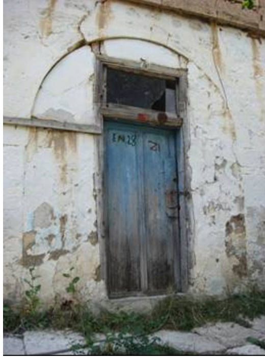
Şekil 47. Kemer kapı sistemi (izleri kalmış)
