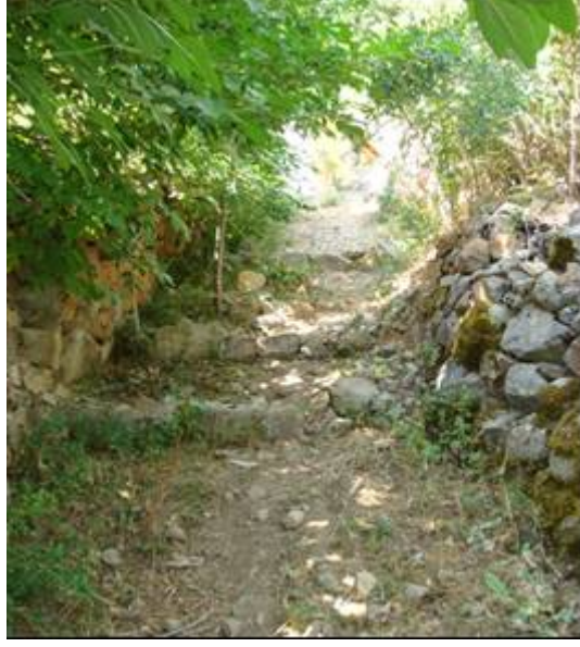
Şekil 46. Taş malzeme kullanılarak kademelendirilmiş toprak yol
