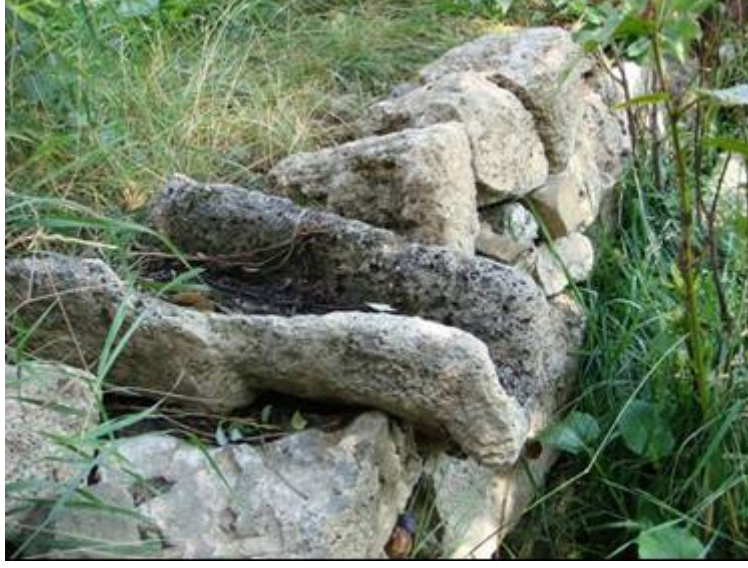
Şekil 42. Düz damda suyun uzaklaştırılmasında kullanılan tuf malzemenen yapılmış oluk
