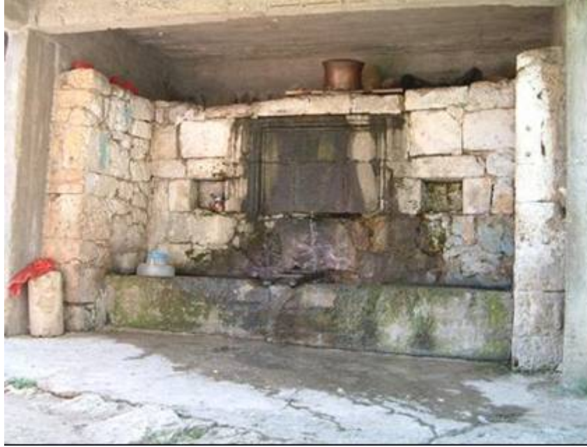
Şekil 29. Gavalak 4 Mh.(Bulutayla Mh.) çeşme
