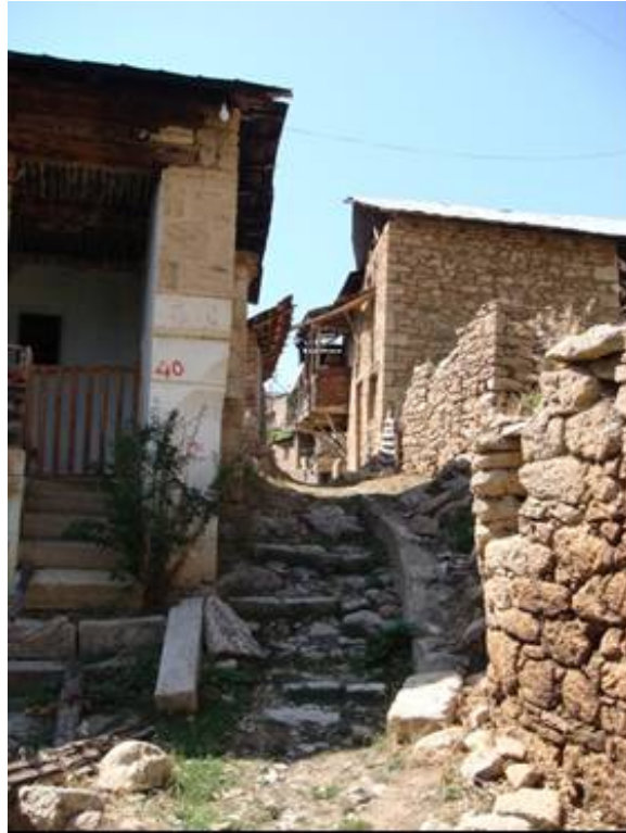
Şekil 62. Mahalle arası sokak merdiveni ve taş kaplamalar
