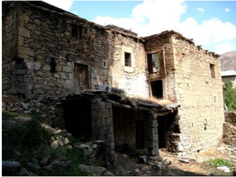
Şekil 94. Üç katlı yapı örneği (İmera-Aşağı Mh Ayvaz evi)
