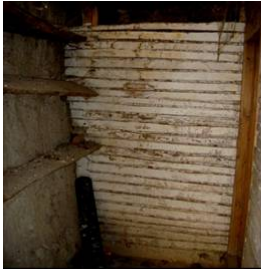
Şekil 37. Ahşap arası toprak-taş dolgu duvar örneği
