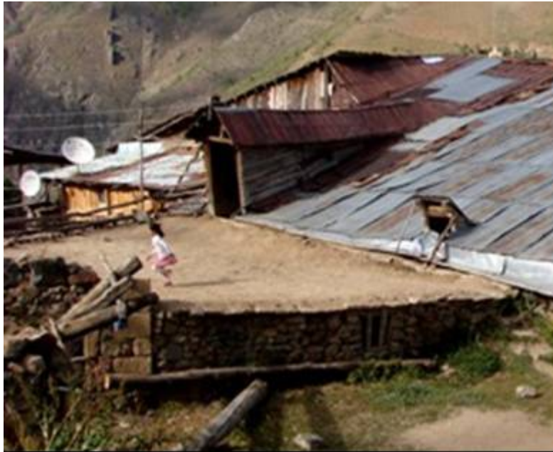
Şekil 40. Bölgede bulunan düz damlardan üzeri kapatılmamış dam örneği (çatılı yapılarında damları aynı özelliktedir)
