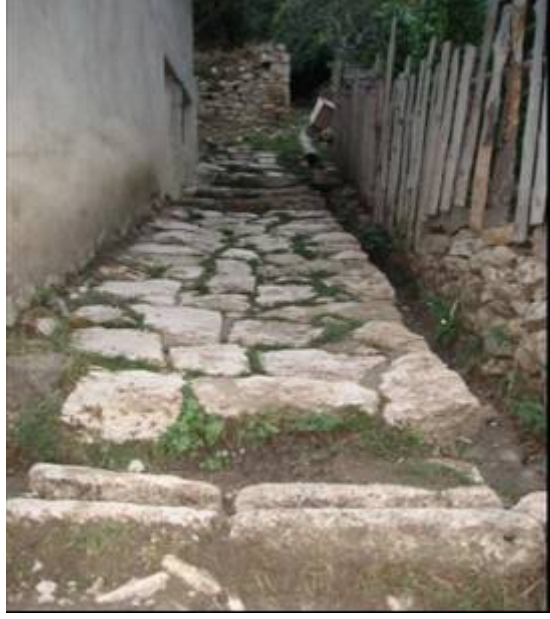
Şekil 45. Taş döşenmiş yol ve kanal
