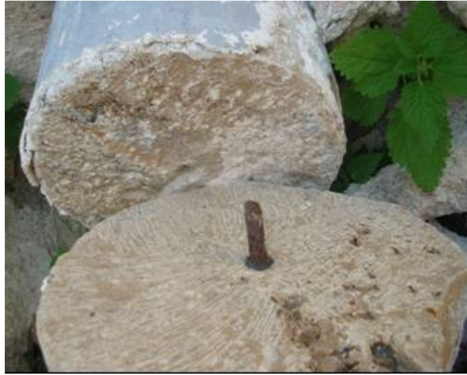
Şekil 33. Sütunların sabitlenmesinde kullanılan kenet demiri
