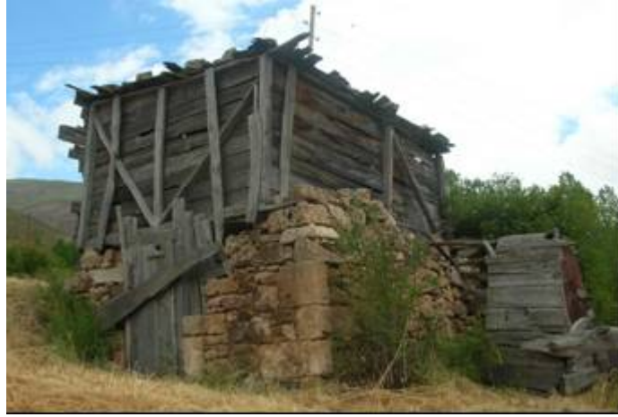
Şekil 21. Gavalak-Şamanlı mahallesi şapeline ait kalıntı ( yapı yayla evi olarak kullanılmaktadır)
