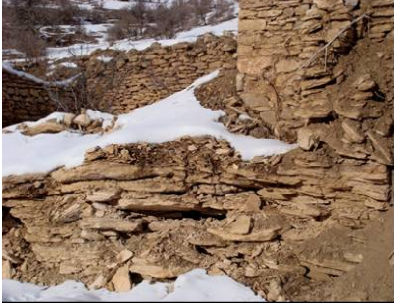
Şekil 30. Bölgede mevcut ve en yoğun kullanılan traverten doğal taşın doğal dokusu (altta) ve yapılarda kullanımı (üstteki duvarlar)
