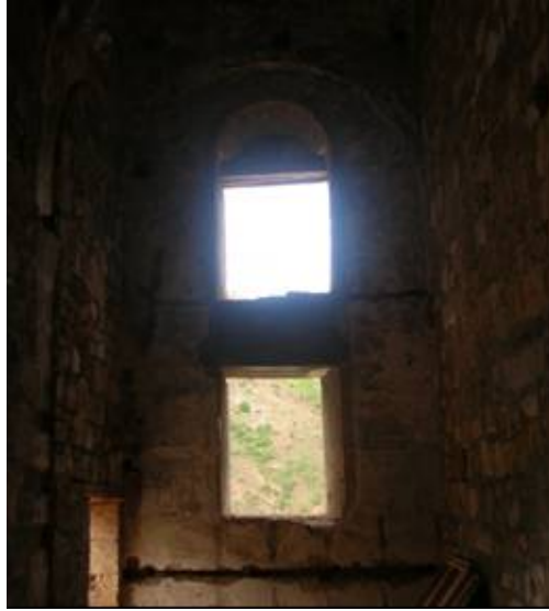
Şekil 52. Üzeri kemerli ve şevli koridor penceresi
