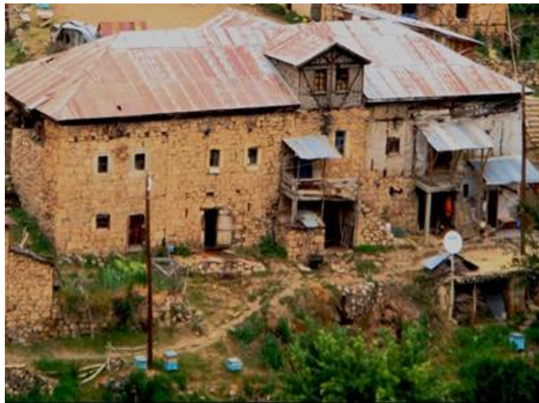
Şekil 89. İki katlı yapı örneği (Bulutayla Çolakoğlu evi)
