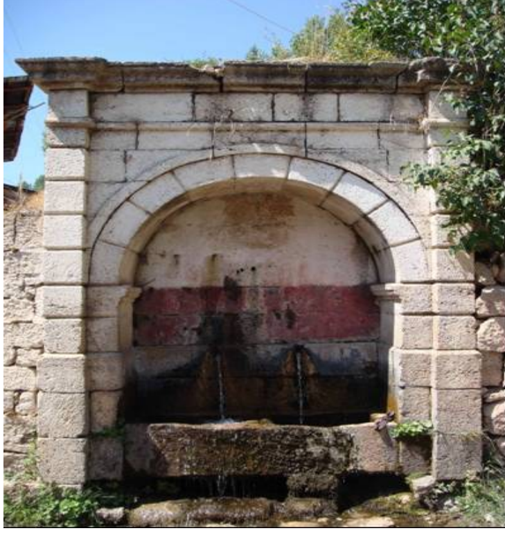
Şekil 28. İmera (Olucak) Aşağı mahalle çeşme
