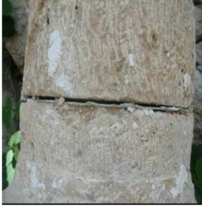
Şekil 35. Sütunların ve kenet demirinin sabitlenmesinde kurşun kullanımı
