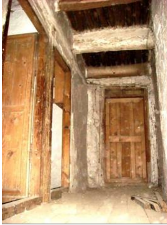
Şekil 49. Bir sofa etrafında dizilmiş oda kapıları
