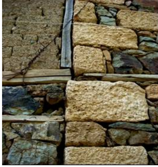
Şekil 36. Taş - kerpiç duvar köşeleri birleşim örneği
