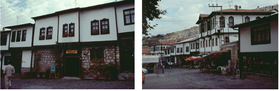
Şekil 33. Beypazarı'nda restorasyonu yapılmış bölgelerden görüntüler
