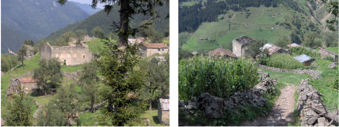
Şekil 1. Santa Harabeleri’ni oluşturan yedi mahalleden Zurnacı Mahallesi’nin günümüze ulaşabilmiş son durumu
