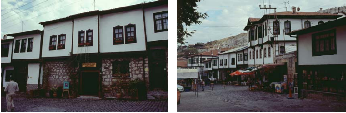
Şekil 29. Beypazarı’nda restorasyonu yapılmış bölgelerden görüntüler
