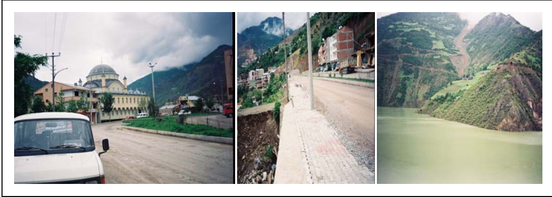
Şekil 65. Tehlikede olan binalardan; Merkez camii ve jeoteknik araştırmanın yapıldığı çizgi, Dutluca ve Araköy mahallerinin konumu
