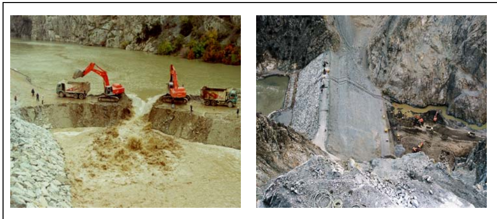
Şekil 34. Deriner barajı derivasyon - Memba batardosu çalışmaları
