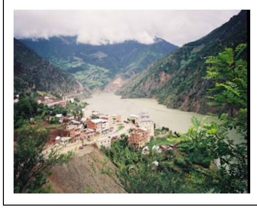
Şekil 27. Kürtün baraj rezervuarı ve Özkürtün İlçesi
