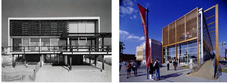
Şekil 123. McMullen Beach House, Breuer-Beckhard, New Jersey, 1960; Expo 2000 Hannover Türkiye Pavilyonu, Kamut-Gürsel-Tabanlıoğlu, Almanya, 2000
