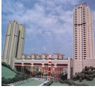
Şekil 45. Dikmen Vadisi Köprüsü, Doruk Pamir, Ankara, 1996
