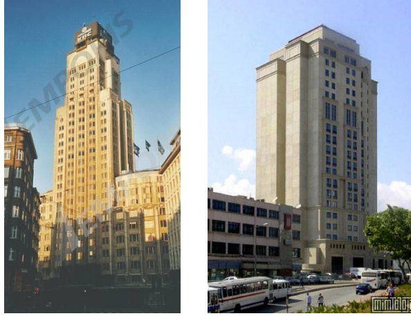
Şekil 57. KBC Tower, Hoenacker-Smolderen-Averbeke, Belçika, 1932; Mövenpick Otel, Alton-Ökmen-Otağ, İstanbul, 2003
