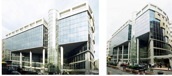
Şekil 152. İpekyolu İş Merkezi, Necdet Kırhan Yazıcı, Trabzon, 1999
