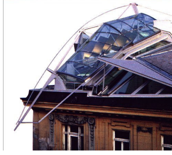
Şekil 41. Çatıda dekonstrüksiyon uygulaması, Coop Himmelblau, Viyana, 1988
