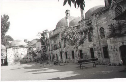
Foto 20. Şehzade Mehmet Külliyesi, İstanbul
