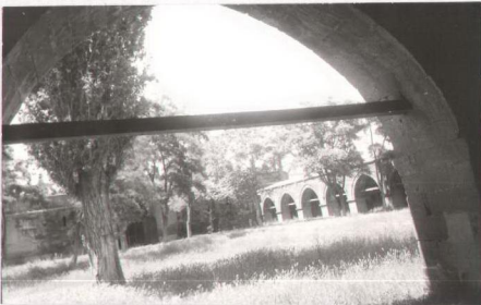
Foto 25. Kara Mustafa Paşa Külliyesi Kervansarayı Kayseri-İncesu, Avludan Görünüş
