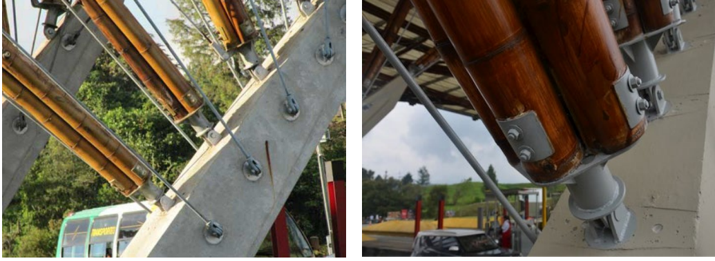
Şekil 92. Büyük yükleri taşımak için oluşturulan bambu demetleri (Harison ve ark, 2017; Ubidia, 2015).
