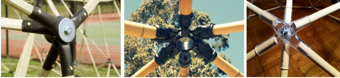
Şekil 84. Çeşitli malzemelerle oluşturulan hub konektörleri (Vahanvati, 2015; URL-112, 2020).
