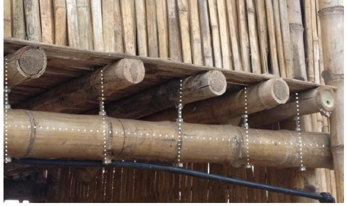
Şekil 55. İkincil kiriş mesafeleri (Gallant, 1980; Gouyen, 2018).
