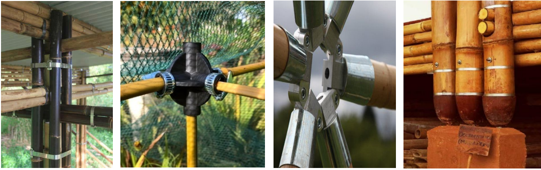
Şekil 78. Modern bağlantıda kullanılan çeşitli materyaller (URL-108,109 ve 110, 2020; Verhoeven ve Wal, 2014).
