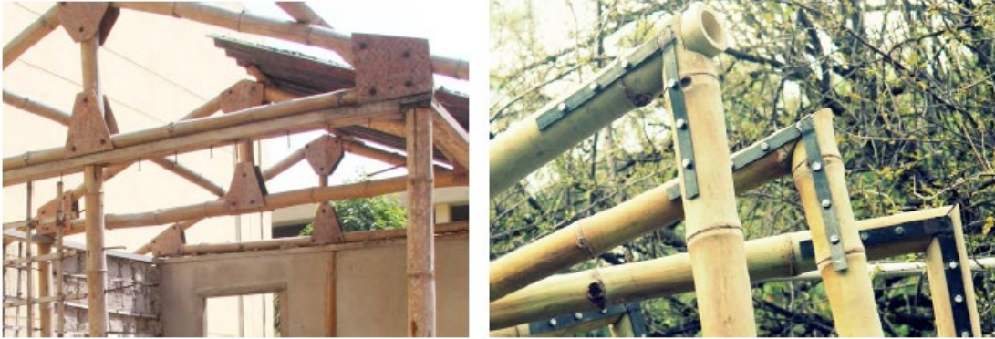
Şekil 82. Köşebent levha (solda) ve braketler (sağda) ile oluşturulan bağlantı (Vahanvati, 2015).
