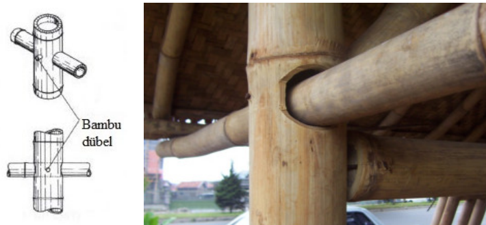
Şekil 77. İçten geçen bağlantı tekniği (López, 1981; Widyowijatnoko ve Harries, 2020).
