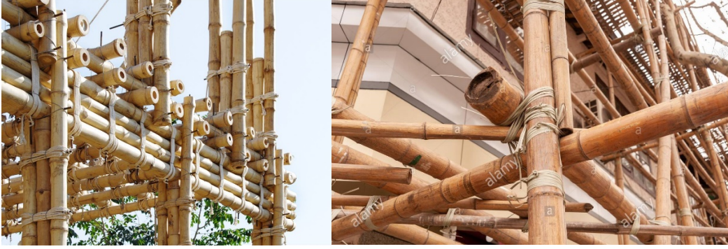
Şekil 61. Bambudan oluşturulmuş iskele örnekleri (URL-105 ve 106, 2020).
