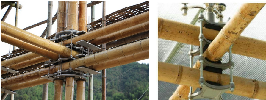
Şekil 93. Studio Cardenas ekibi tarafından tasarlanan bağlantı detayları (URL- 114, 2020; Scaramuzza, 2019).
