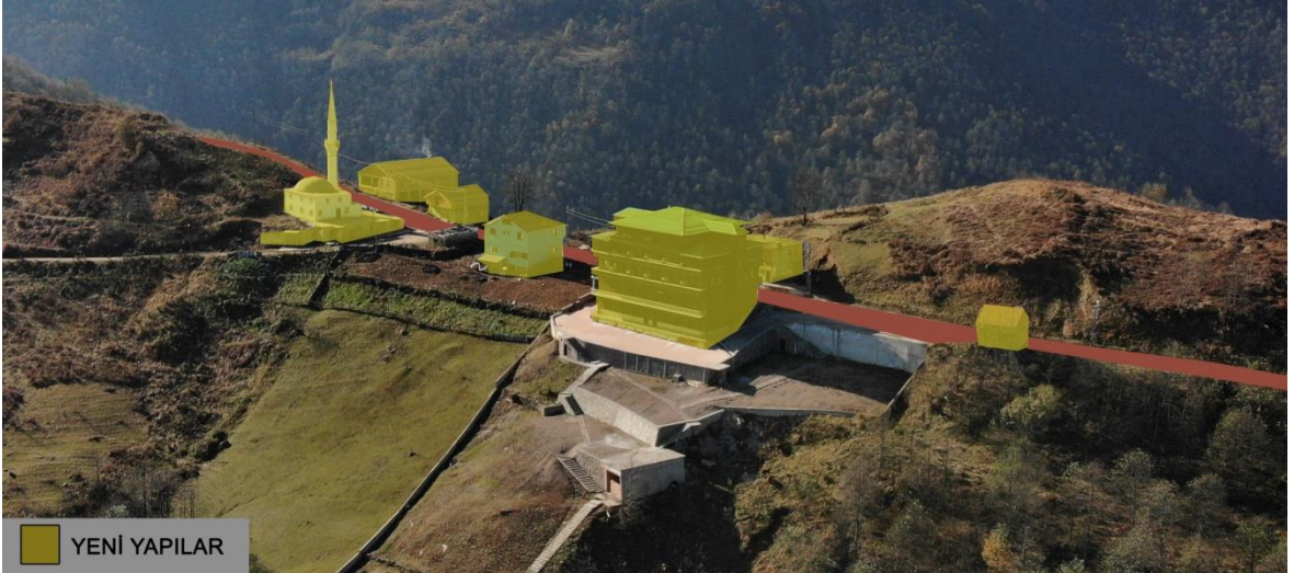
Şekil 29. Avulot Han Bölgesi’nde mevcut yapı incelemesi
