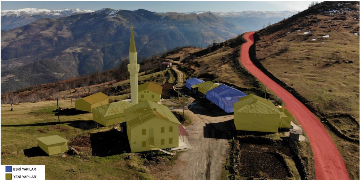
Şekil 37. Soğuksu Han Bölgesi'nde mevcut yapı incelemesi
