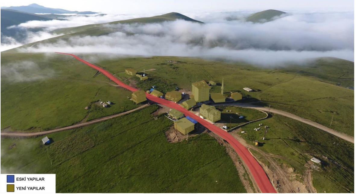
Şekil 56. Limonsuyu Han Bölgesi'nde mevcut yapı incelemesi
