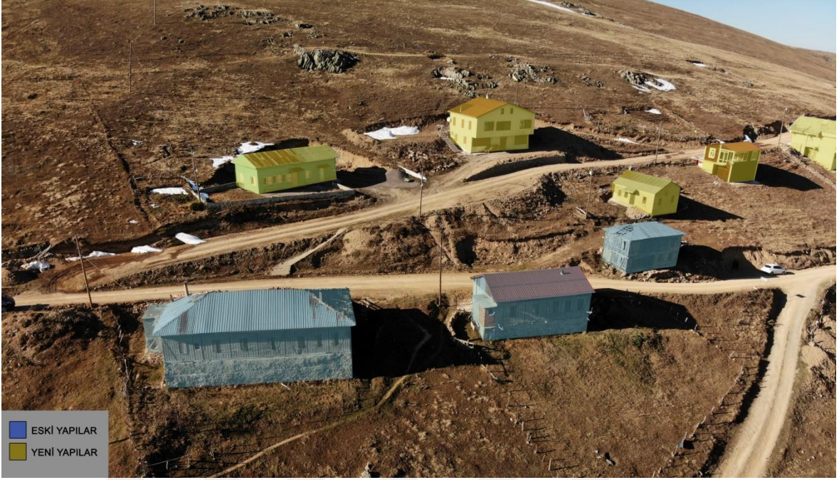
Şekil 48. Köşk Han Bölgesi'nde mevcut yapı incelemesi
