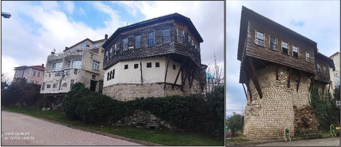
Şekil 96. Bolaman Konağı batı cephesi, konak ve kilise girişi, (Yavru, M. arşivi, 2020)
