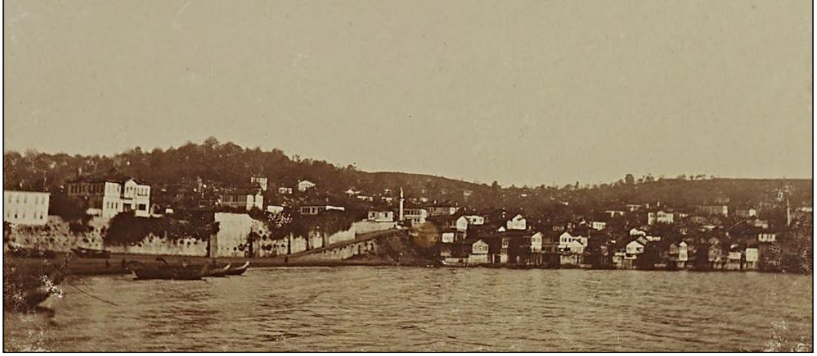
Şekil 20. Hazinedarzâde Süleyman Paşa Konağı surları ve sonradan inşa edilen konaklar, (Yıldız Arşivi)
