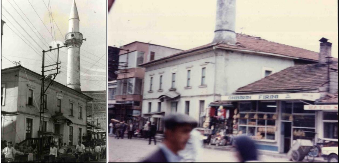
Şekil 85. Çarşamba Abdullah Paşa Camii (onarım sonrası), (Vakıflar Genel Müdürlüğü Arşivi)
