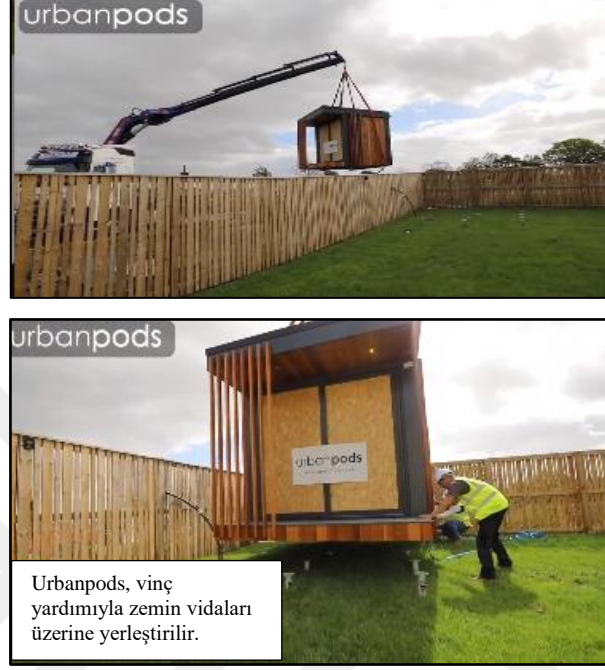
Şekil 57. Zemin vidaları üzerine vinç yardımıyla yerleştirilen "urbanpods" yapısı [74]
