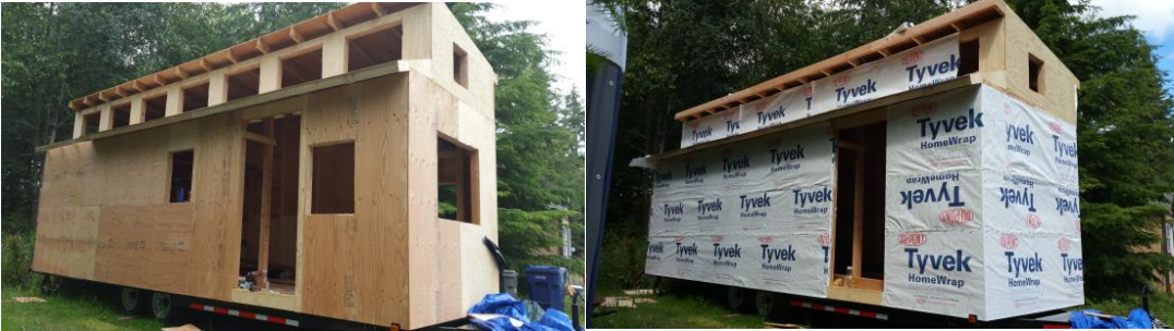
Şekil 85. Kaplama üzerine uygulanan su yalıtım örtüsü [103]
