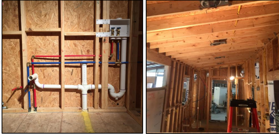
Şekil 95. Bir mobil konut yapısının tesisat sisteminin kurulumu [112]
