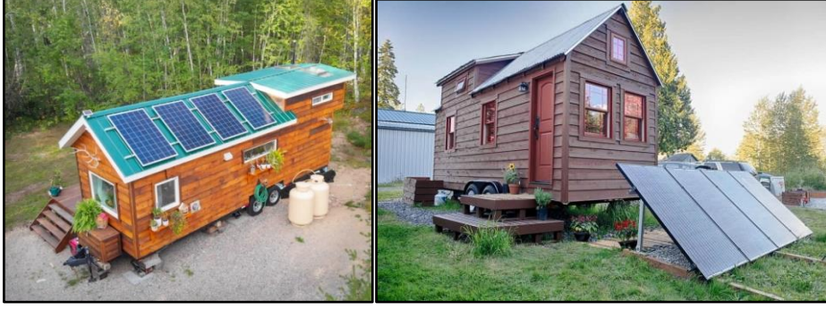
Şekil 96. Güneş panel sistemi konuta monte edilebilir [114] ya da harici olarak kullanılabilir [115].
