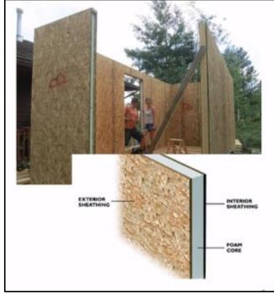
Şekil 75. SIP paneller yapısı ve inşası [85]
