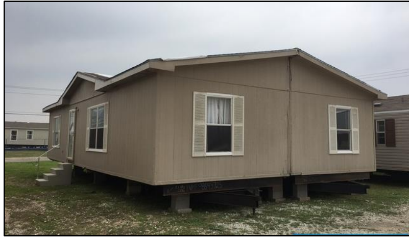
Şekil 22. 'Double-Wide' Mobil Konut Yapısı [39]
