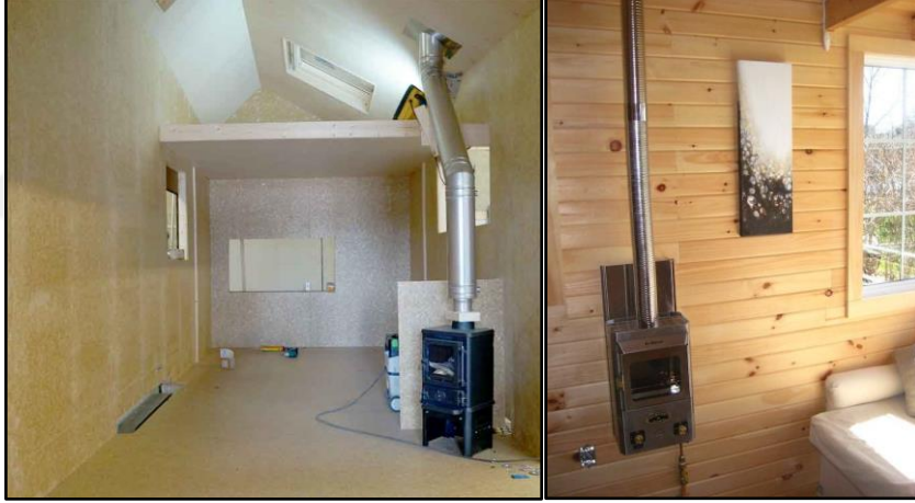
Şekil 101. Odun sobası(solda) ve propan soba(sağda) kullanımı [120]
