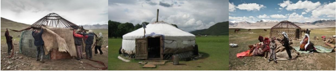
Şekil 2. Geleneksel Orta Asya ‘Yurt’ çadırının oluşum aşamaları [13]
