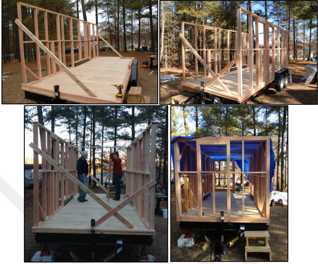
Şekil 72. Ahşap çerçeve sistem ile inşa edilen mobil konut [87]
