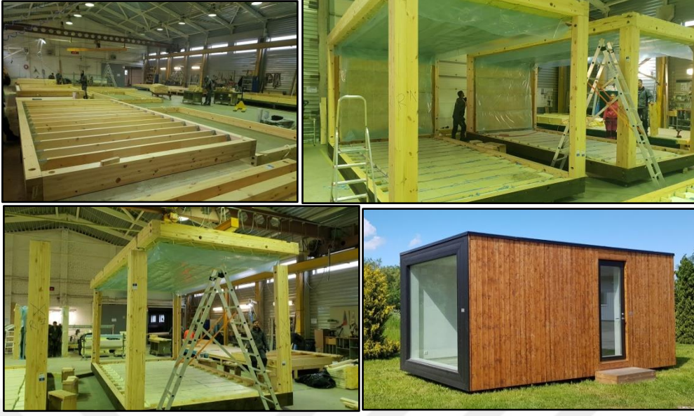
Şekil 73. Teokarp firması tarafından glulam kullanılarak inşa edilen mobil konut[88]
