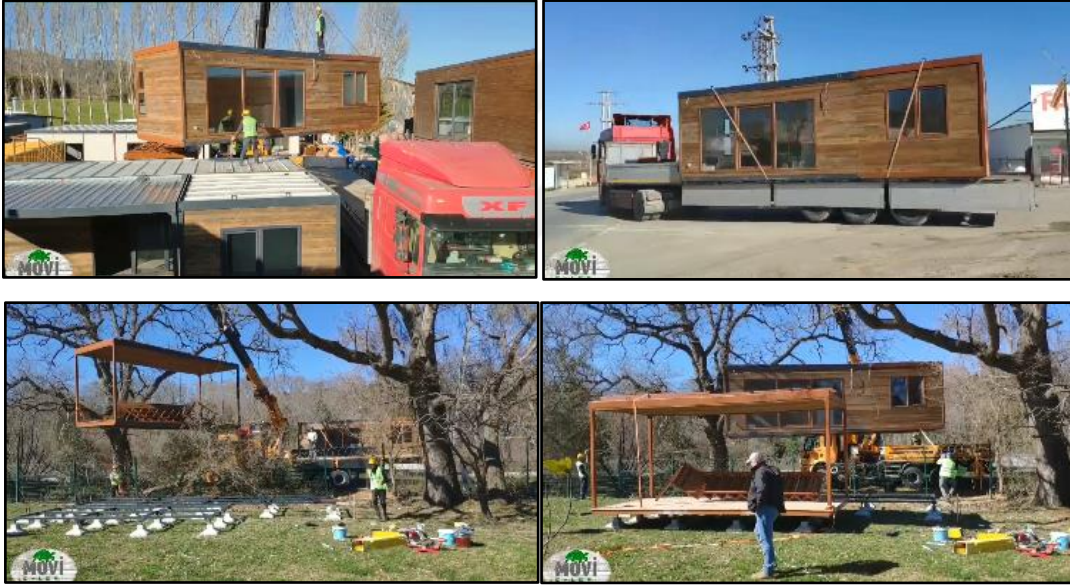
Şekil 64. Ayarlanabilir temel blokları üzerine vinç yardımıyla yerleştirilen mobil konut yapısı [78]
