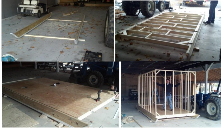
Şekil 67. Kızak temel yapım aşamaları [83]
