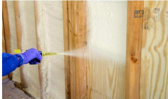
Şekil 84. Sprey köpük yalıtım uygulaması [101]
