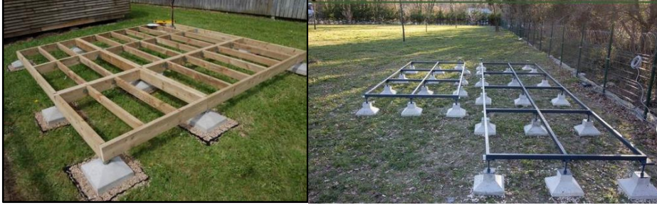
Şekil 63. Ahşap kiriş sistemi [76], çelik kiriş sistemi [78]
