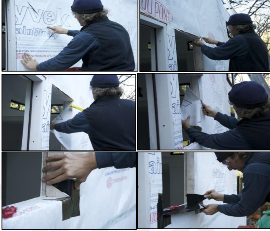
Şekil 86. Yalıtım örtüsünden pencere boşluklarının oluşturulması [104]
