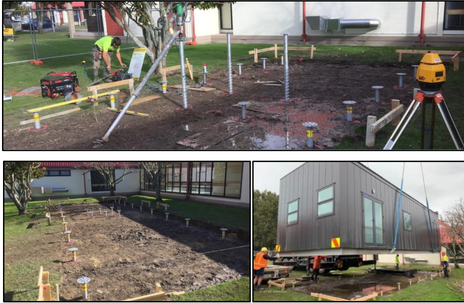
Şekil 58. Zemin vidaları üzerine vinç yardımıyla yerleştirilen mobil konut[75]
