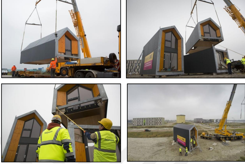
Şekil 32. 'Heijman' mobil konut modüllerinin monte edilme aşaması [45]
