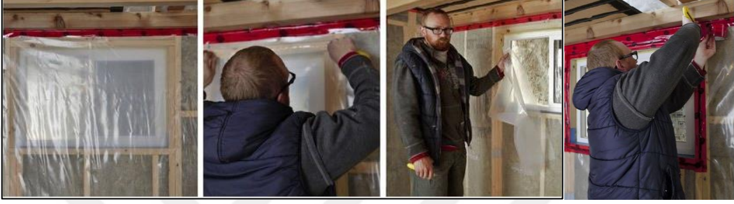
Şekil 88. İç mekanda buhar kesicinin uygulanmasının ardından boşluklar oluşturulur [105]
