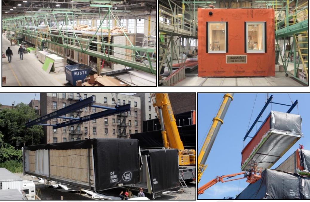
Şekil 34. ‘Gluck+’ tarafından tasarlanan modüler apartmanın yapım aşamaları [46]
