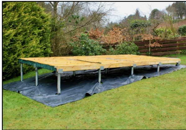
řekil 56. Eđimli arazi zerine monte edilmiř zemin vidalı temel [71]
