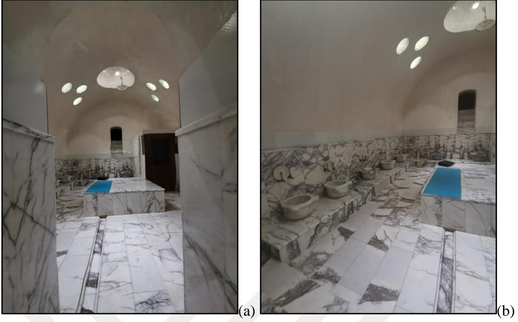
Şekil 84. (a), (b) Paşa Hamamı erkekler sıcaklık mekanı
