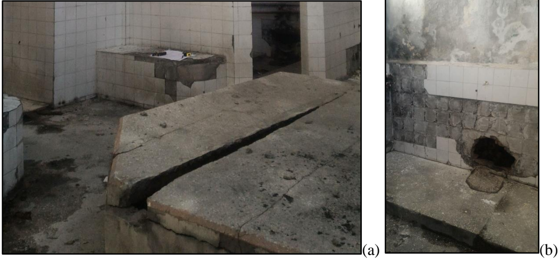
Şekil 58. (a) Göbek taşı, (b) seramik kaplama parça kayıpları
