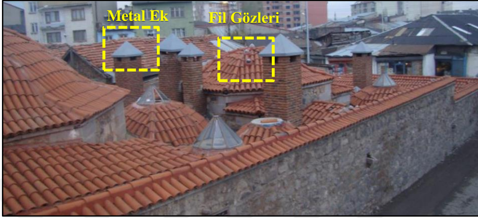
Şekil 37. Gümruk hamamı restorasyon sonrası (Çınar, 2012).
