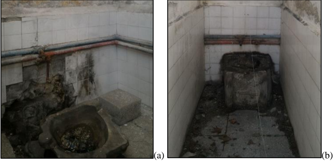
Şekil 59. (a) Sıcaklı mekânındaki taş kurna, (b) Usturalık(Z 06) mekânındaki kurna
