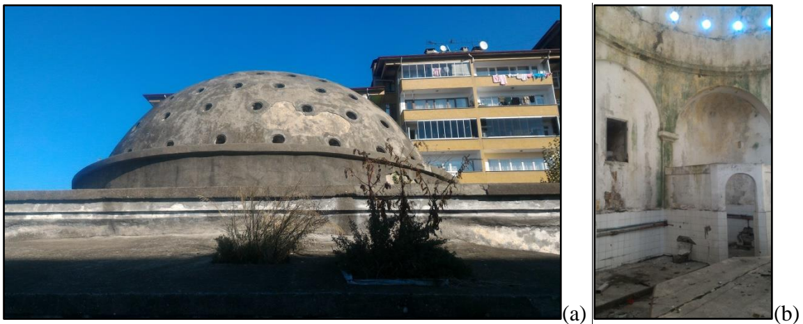
Şekil 69. (a) Kubbeye yer alan çimentolu alçı sıva uygulaması, (b) sıcaklık(Z 09) mekânındaki ek donatılar ve kaplama öğeleri
