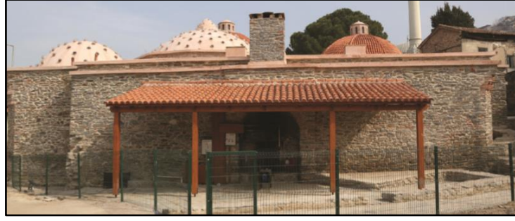
Şekil 32. Yalınayak hamamı batı cephesindeki sundurma (Çakmak, 2019).
