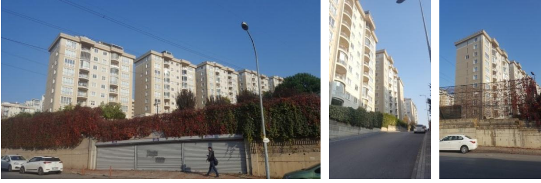
Şekil 13. Sitenin sokaktan görünümü
