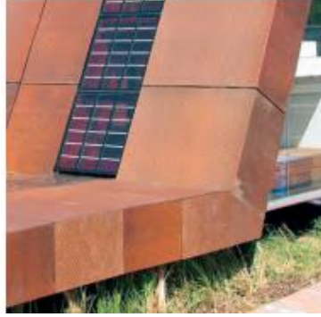
Şekil 39. Avustralya’da bir yapının dış cephede boya güneş pili uygulaması (Ritter, 2007).
