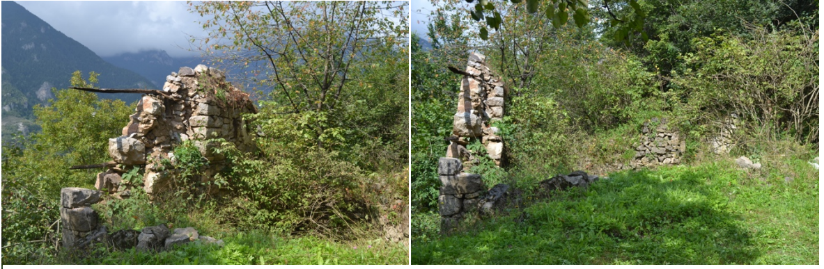
Şekil 26. Kilise papazının lojmanına ait olduğu söylenen duvar kalıntısı
