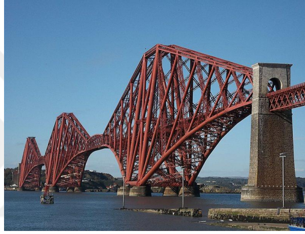
Şekil 6. Fourt Demiryolu Köprüsü (URL-12, 2019).
