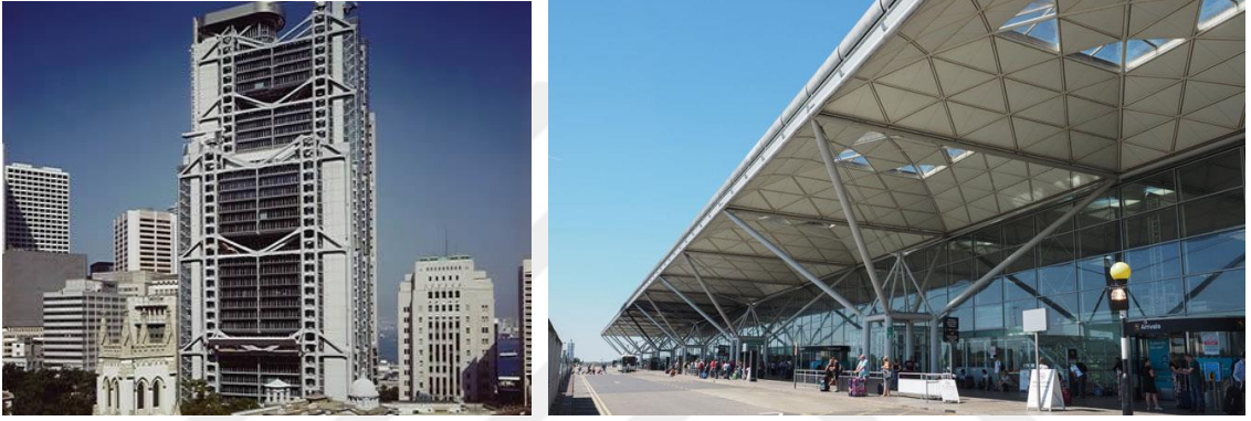
Şekil 10. Hong Kong ve Shanghai Banka Binası ile Stansted Havaalanı (URL-16, 2019; URL-17, 2019).
