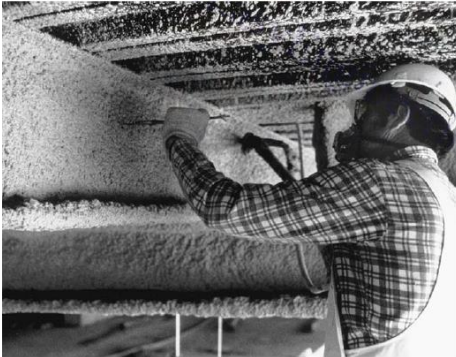
Şekil 30. Püskürtme uygulaması ve kesit gösterimi (Allen, Iano, 2009; Boring, 2000).
