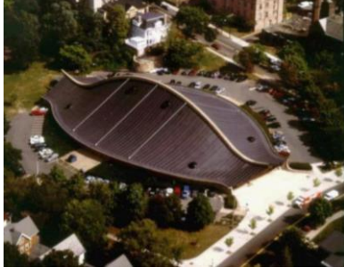
Şekil 52. Ingalls Hockey Alanı kablo ağı asma sistem örneği (Shirzad Rezaei, 2019).
