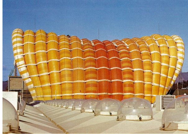
Şekil 53. Fuji grubu pavyonu pnömatik sistem örneği (URL-33, 2019).
