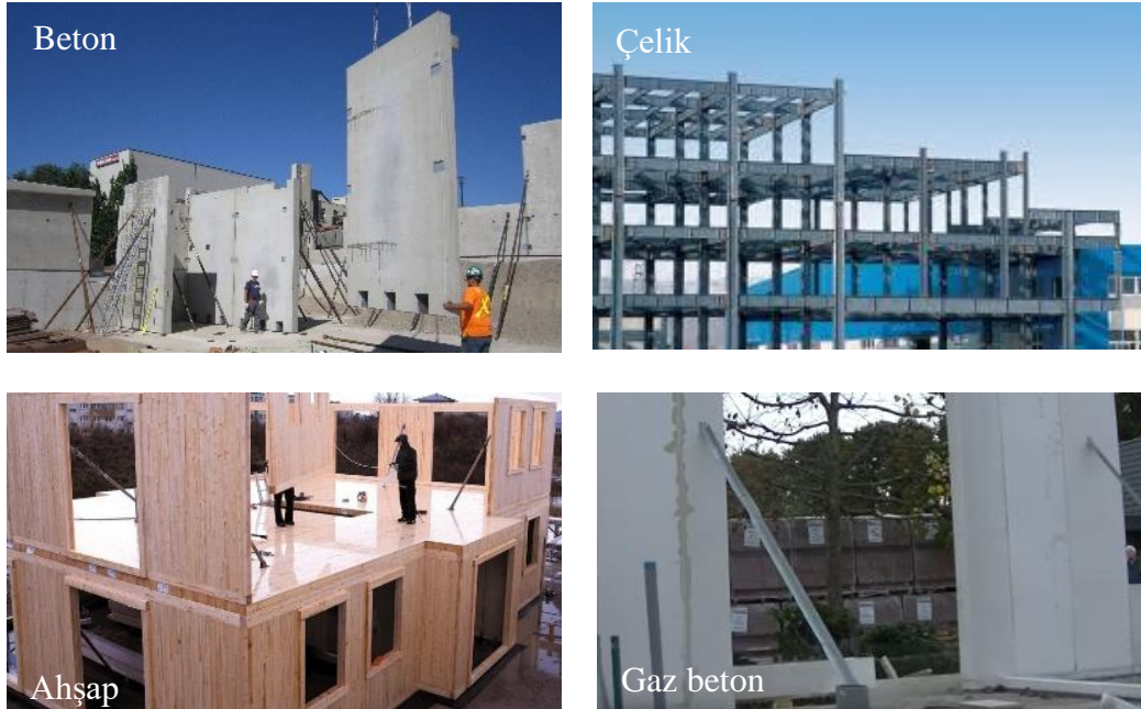
Şekil 1.2. Malzemelerine göre prefabrike yapı elemanları (URL-11, 12, 13 ve 14 2020)
