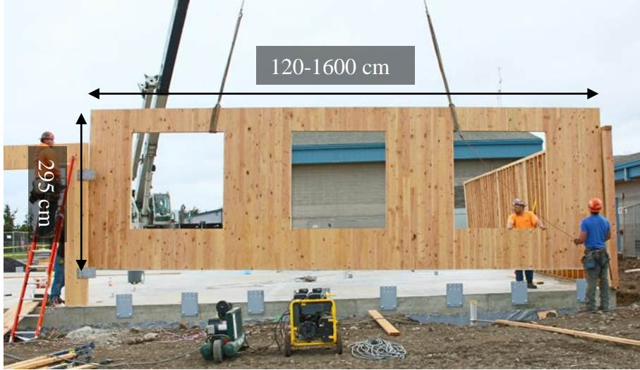
Şekil 2.77. CLT duvar yapı elemanı (URL-170, 2019)
