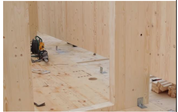
Duvar panellerinin montajı
