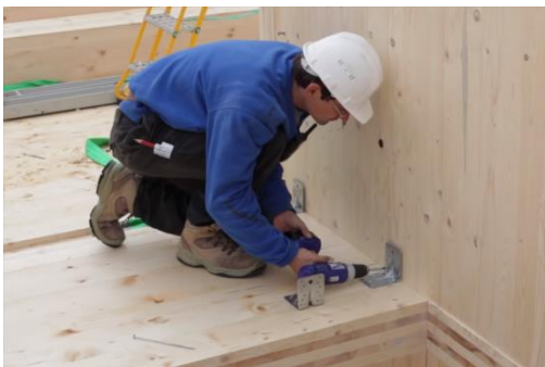
Duvar panellerinin montajı
