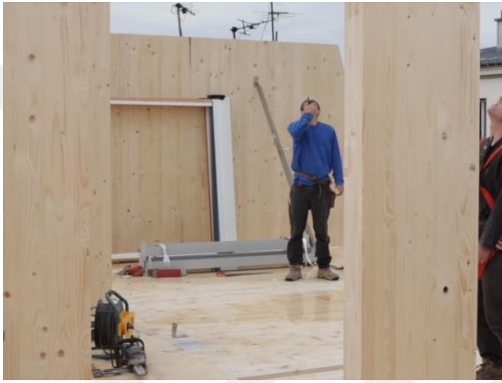
Duvar panellerinin kurulumu
