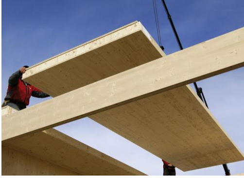
Döşeme panellerinin kurulumu
