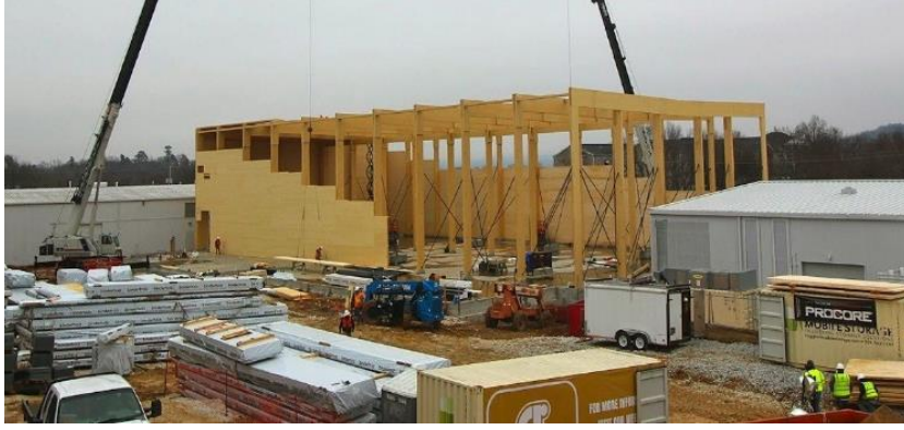
Şekil 2.32. CLT panelin depolandığı şantiye alanı (URL-90, 2020)
