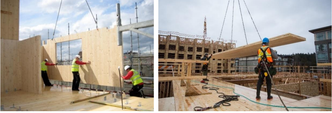
Şekil 2.49. İnşaat alanı (URL-117 ve 118, 2020)
