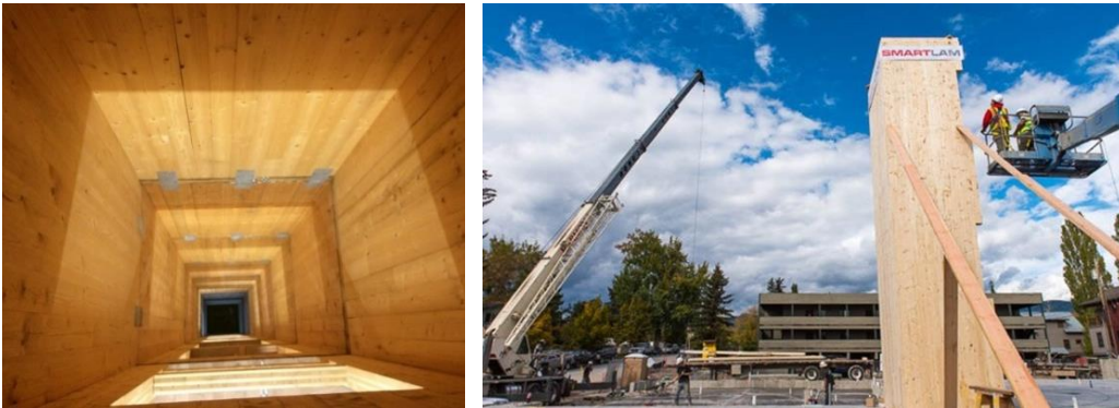
Şekil 2.72. CLT şaft paneli montajı (URL-158 ve 159, 2020)
