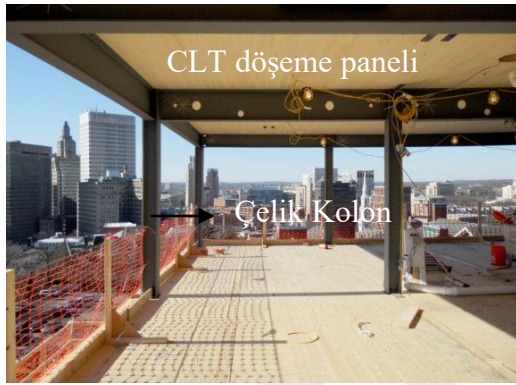
Çelik kolon-kiriş ve CLT döşeme ile hibrit yapım sistemi uygulaması
