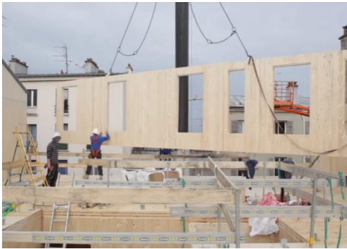
Duvar panelinin taşınması
