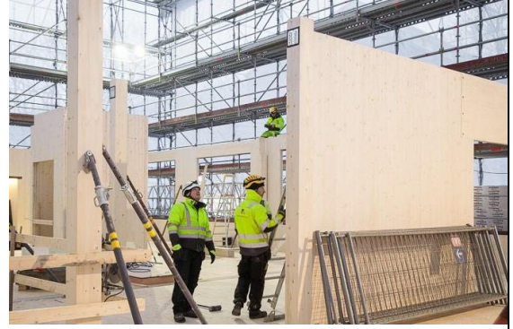
Kolon ve duvar panellerinin kurulumu
