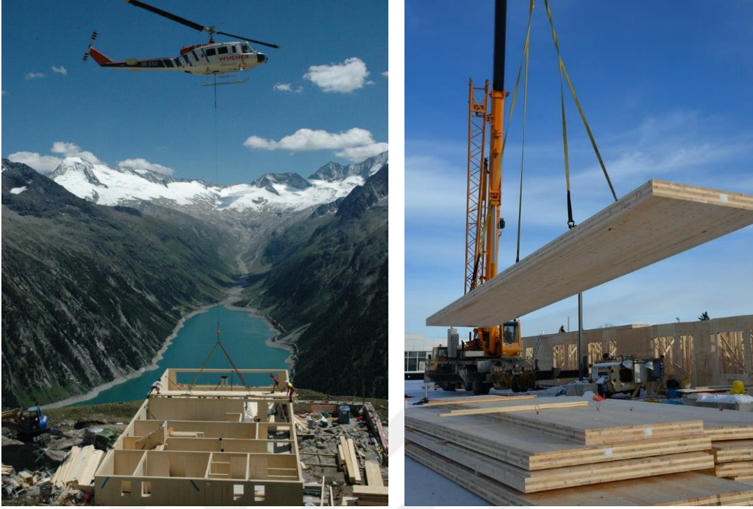
Şekil 2.31. Helikopter ve vinç ile panel taşıma işlemi (Trada, 2020 ve URL-133, 2019)
