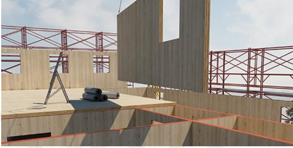
Şekil 2.63. CLT iç duvar paneli (URL-153, 2019)
