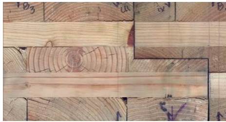
Şekil 2.51. Suya ve neme maruz kalmış CLT panel (Schmidt, 2020)
