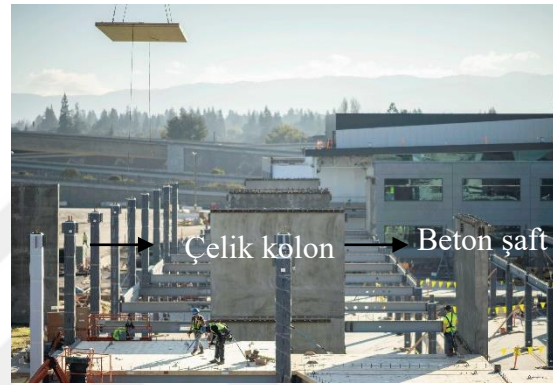
Çelik kolon, beton şaft ve CLT döşeme ile hibrit yapım sistemi uygulaması
