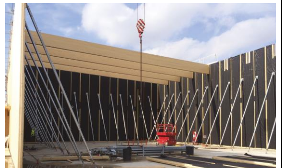
Duvar panellerinin çelik eleman ile desteklenmesi
