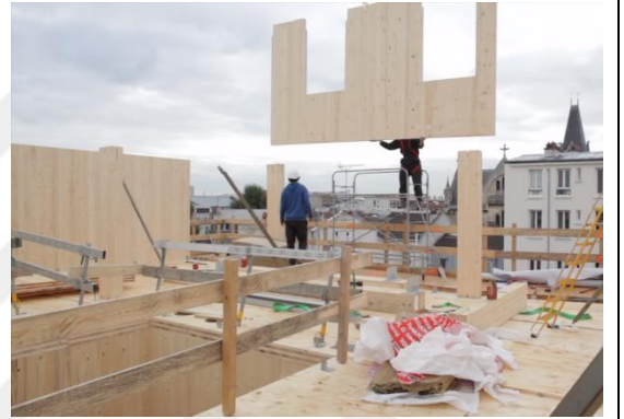
Duvar panelinin taşınması
