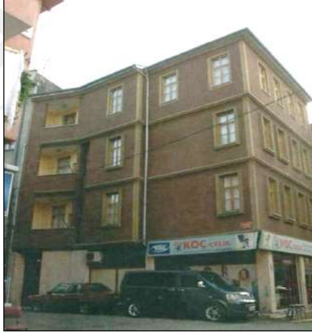
Şekil 48. 1990'lı yıllarda tescilli binanın yerine yapılan yeni yapı (Bozal, 2020).
