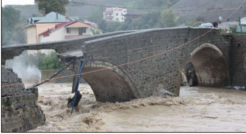
Şekil 61. Osman Baba Köprüsü'nün yıkılışı (URL-24, 2020).
