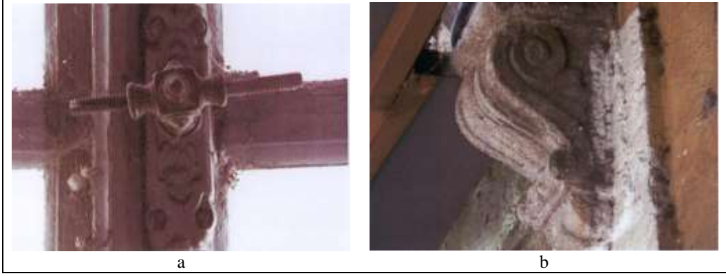
Şekil 57. a) Metal pencere kolu detayı, b) Tavandaki sütun başlığı detayı (KVKBK, 2020).
