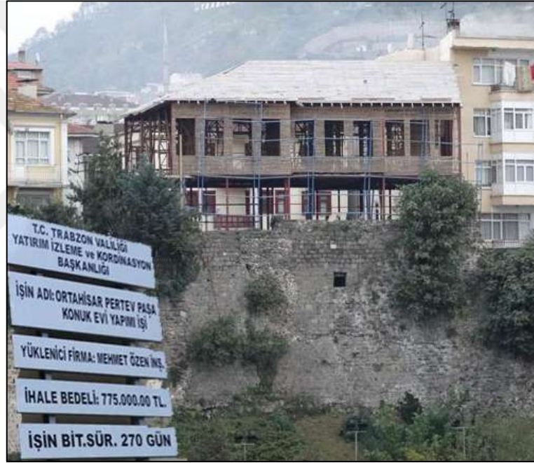
Şekil 41. Trabzon Pertev Paşa Konuk Evi'nin çelik konstrüksiyon yapım hali (URL-22, 2020).
