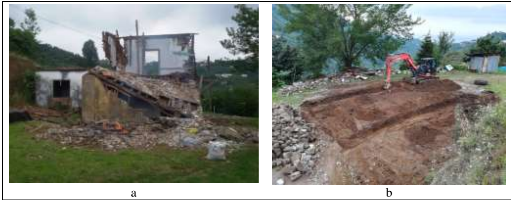
Şekil 38. a) Bekir Turan Evi'nin yıkımı b) Arazi düzeltme işlemleri (Ataman, 2020).
