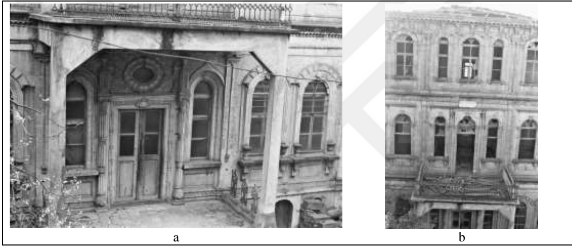
Şekil 45. a) Hacıkadızade Konağı'nın giriş alanı, b) Hacıkadızade Konağı'nın güney cephesi (Sümerkan, 2020).
