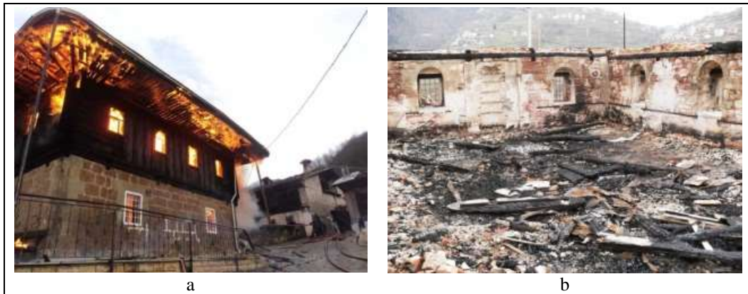
Şekil 31. a) Taşören Camii yangın anı, b) Yangın sonrası yıkık durumu (VBM, 2020).
