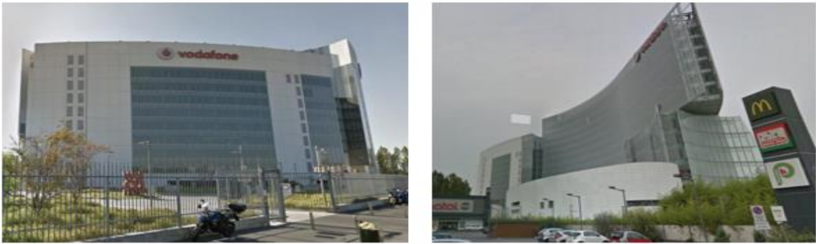
Şekil 2.42. Vodafone Village Ekim 2017 fotoğrafları (URL-54, 2019).
