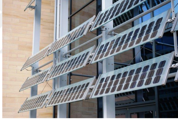
Şekil 40. İki cam arasında Monokristal PV hücre entegre edilmiş bir yatay gölgeleme elemanı [100].
