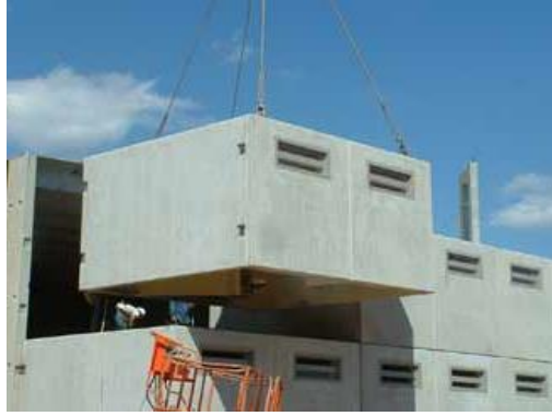
Şekil 91. Prefabrike beton hücre ile yapım örneği (URL-85, 2018)
