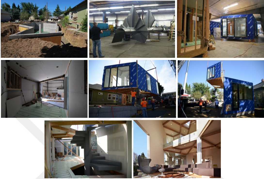
Taft Evi yapım aşaması
