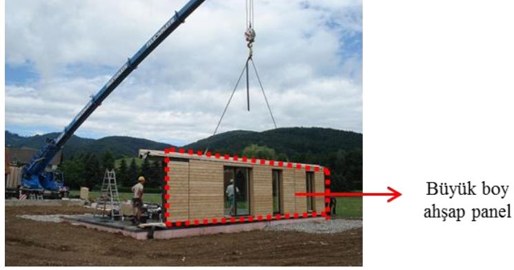
Şekil 74. Prefabrike büyük boy ahşap paneller ile örnek bir konut uygulaması (URL-63, 2018)
