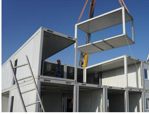
Şekil 104. Prefabrike çelik hücre ile yapım örneği (URL-108, 2018)
