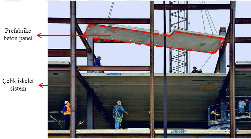
Şekil 59. Prefabrike beton panel ile hibrit yapı örneği (URL-36, 2018)
