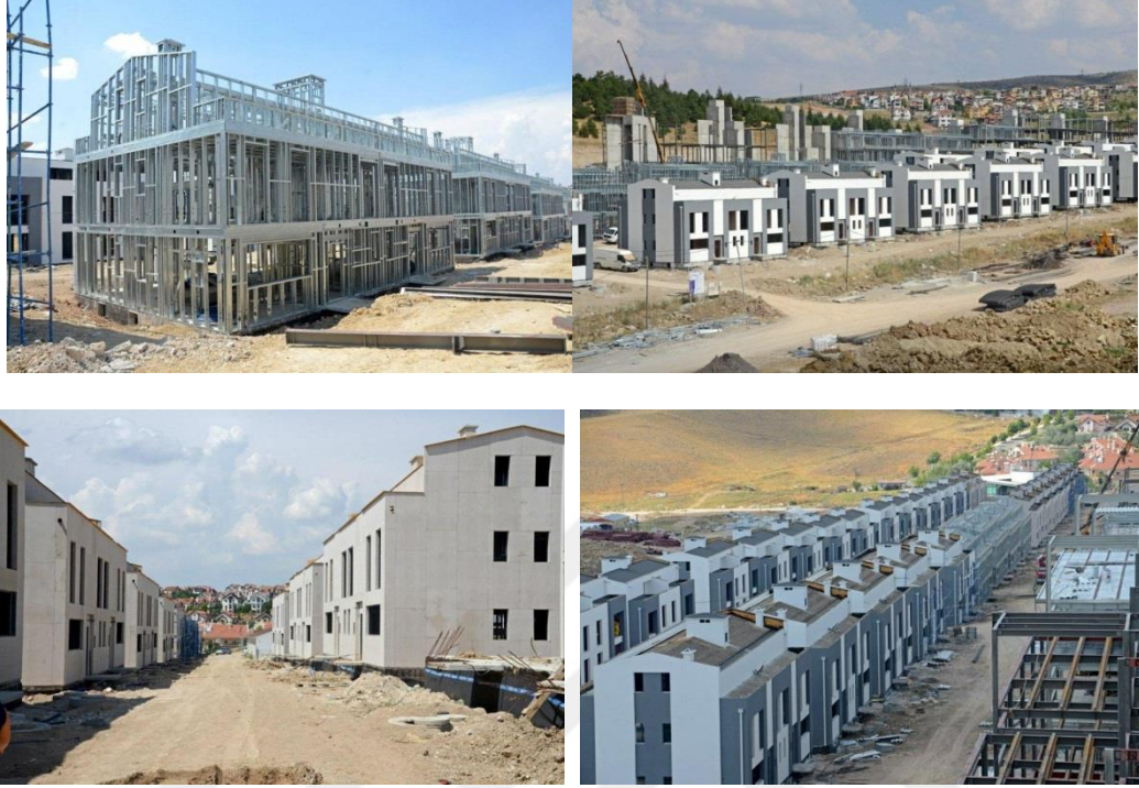
Ankanatura villaları yapım aşaması
