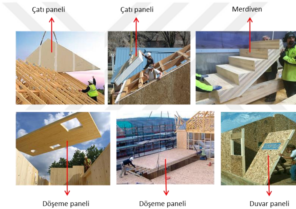
Şekil 68. Prefabrike ahşap paneller ve yapıda kullanım şekilleri (URL-53, 2018; URL-54, 2018; URL-55, 2018; URL-56, 2018; URL-57, 2018; URL-58, 2018)
