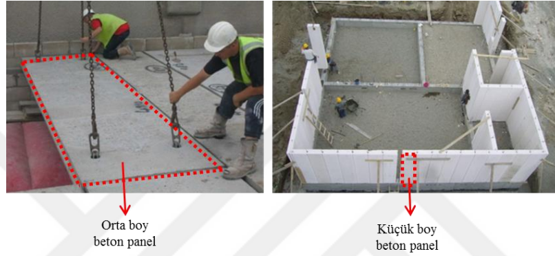
Şekil 67. Prefabrike küçük ve orta boy beton paneller ve örnek bir uygulama (URL-46, 2018 ; URL-47, 2018)
