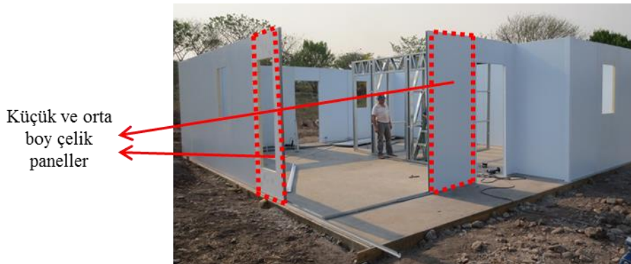
Şekil 84. Prefabriye küçük ve orta boy çelik paneller ile örnek bir konut uygulaması (URL-81, 2018)
