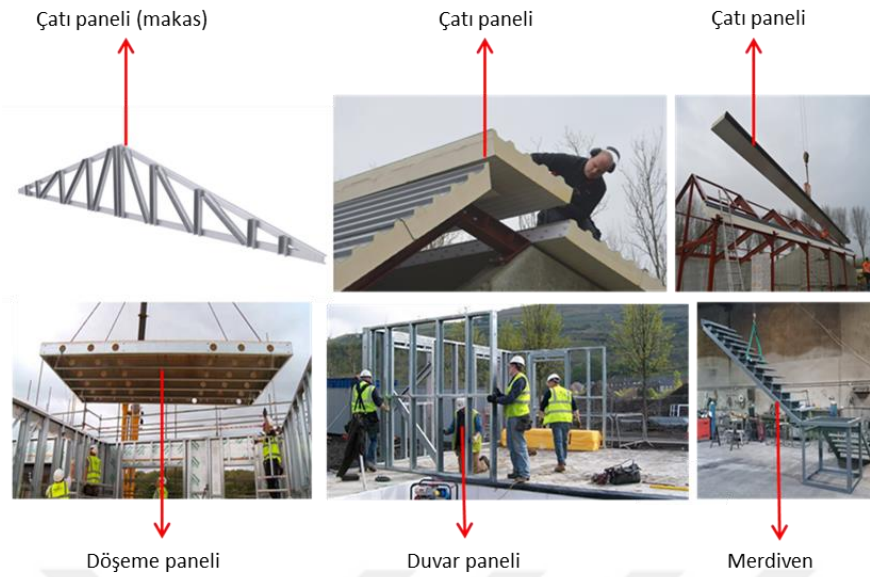
Şekil 76. Prefabrike çelik paneller ve yapıda kullanım şekilleri (URL-67, 2018; URL-68, 2018; URL-69, 2018; URL-70, 2018; URL-71, 2018)
