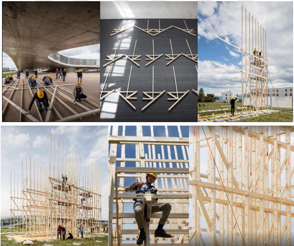
House 1 yapım aşaması
