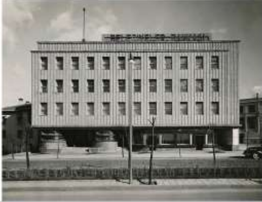
İller Bankası Binası Seyfi Arkan 1935-37 (URL-28)
