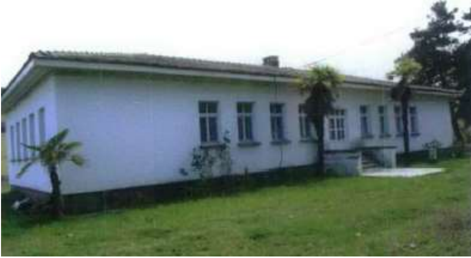
Şekil 21. İdari Bina (Revir) (TKVKBKM Arşivi, 3383)
