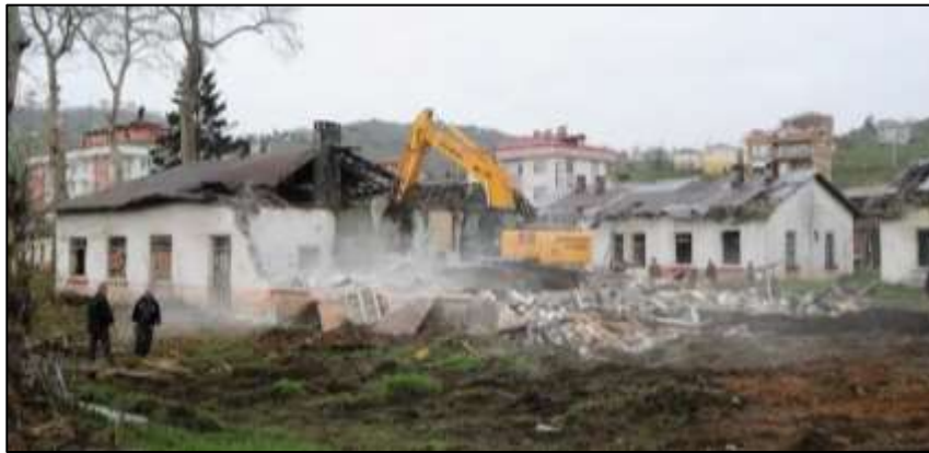
Şekil 24. Şose yolunun kuzeyinde bulunan dersliklerin ve laboratuvarın yıkım anı (URL-63, 2016)
