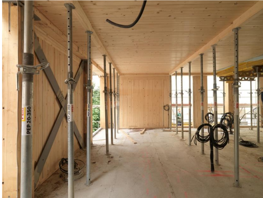
Şekil 2.18. Çapraz Gergi Elemanı ile Desteklenen Sistem [43]
