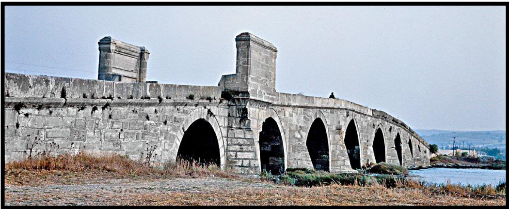
Şekil 63. İstanbul Büyükçekmece Köprüsü, (Kaynak: URL-36)
