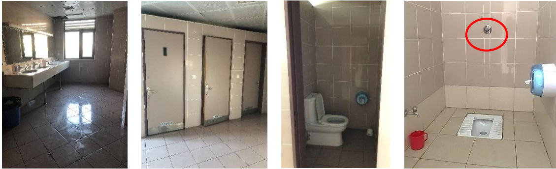
Şekil 126. WC3 iç mekânı ve WC kabinleri
