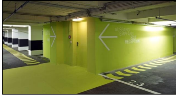
Şekil 55. Otoparktan binaya giriş kapısı (URL-44, 2019)
