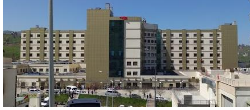
Hastane doğu cephesi
