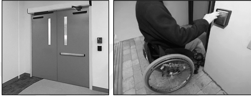
Şekil 41. kontrol tuşu yardımıyla açılan kapılar (N.D.A., 2018)
