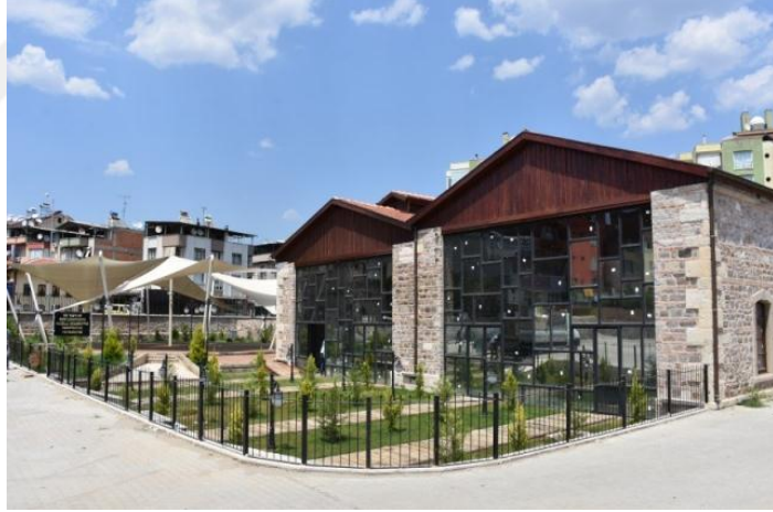
Şekil 14. TCDD hangar binaları cephe tamamlaması (URL-52, 2019).
