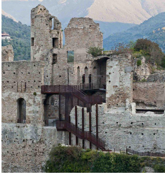
Şekil 16. Castello dei Deria'ya merdiven eki (URL-23, 2019).
