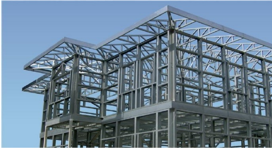
Şekil 1. 6. Çelik yapı iskelet sistem [42].
