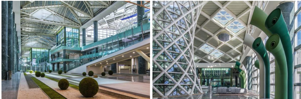
Şekil 17. Adnan Menderes Havalimanı Dış Hatlar Terminal Binası
