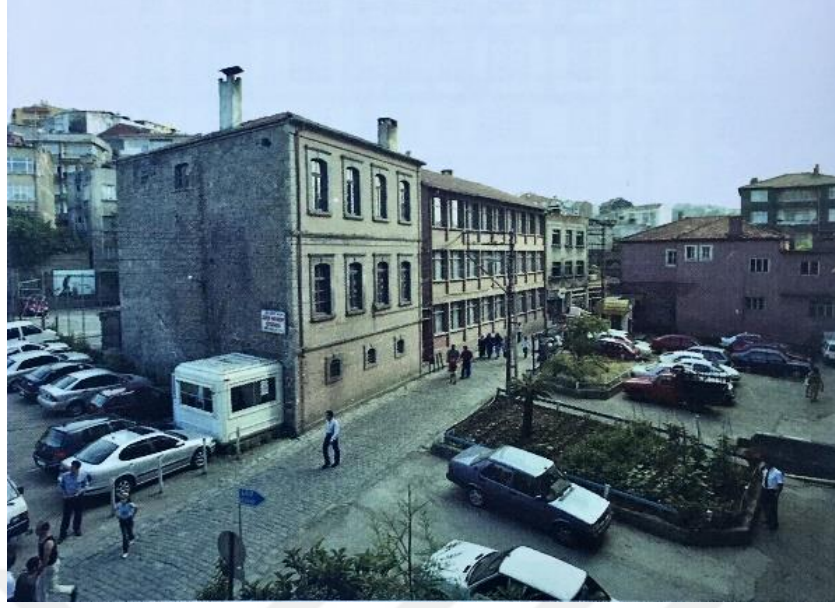
Şekil 63. Kurtuluş İlkokulu'nun yıkımdan önceki durumu (Özen vd., 2010)
