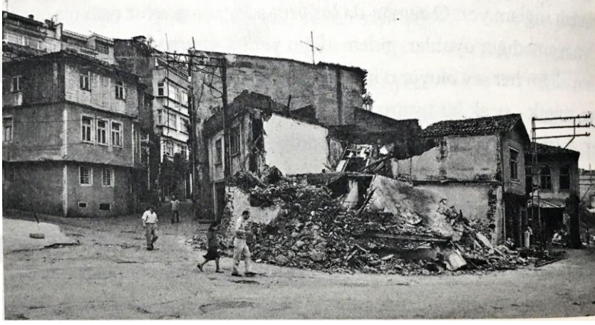
Şekil 13. Hacıkasım Fırını'nın yıkımı (Sezer, 2011)
