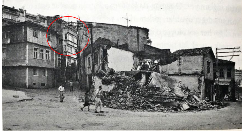
Şekil 24. Yıkılan Hacıkasım Fırınına ait fotoğraf
