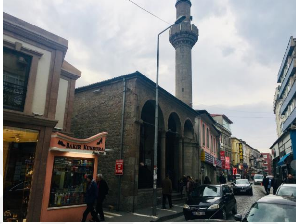
Şekil 59. Uzun Sokak'ta bulunan Konak Camii ve çevresinin durumu
