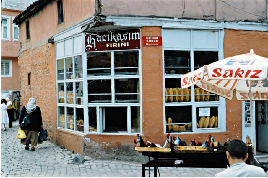
Şekil 15. Tanjant Yolu yapımı ile yıkılmadan önce Hacıkasım Fırını (Mustafa Reşat Sümerkan Arşivi).
