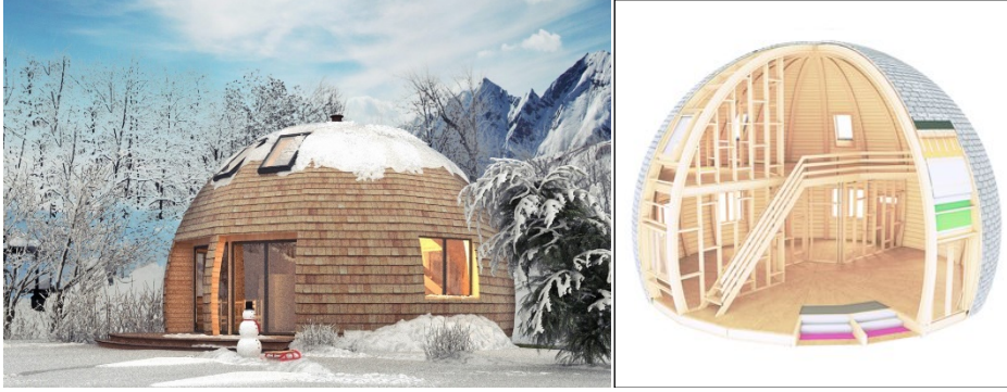
Şekil 36. Ahşap levha kaplı kubbe örneği, Skydom, Rusya [63].
