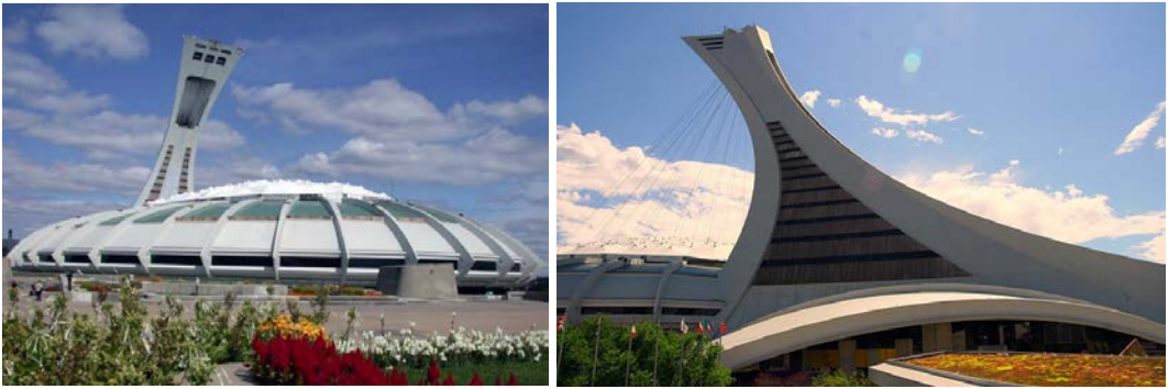
Şekil 28. Düşey taşıyıcıya bağlı kablo askılı sistem örneği, Monreal Olimpiyat Stadyumu, Montreal, Kanada [52].
