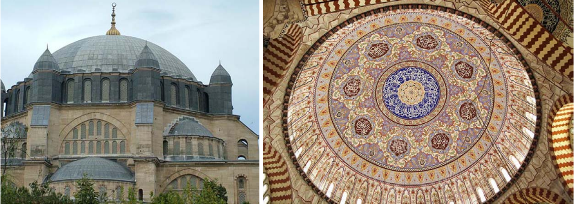
Şekil 21. Yığma kubbe örneği, Selimiye Camii, Edirne [41].
