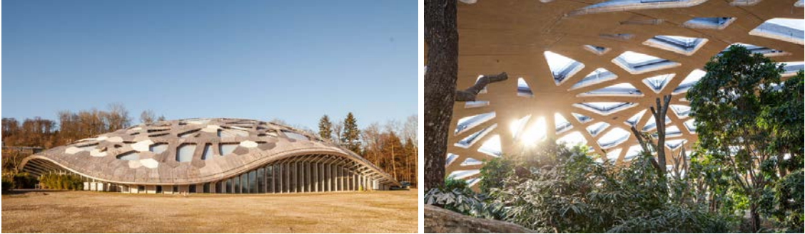
Şekil 51. Isı pompası sistemi, Kaeng Krachan Fil Evi [169].
