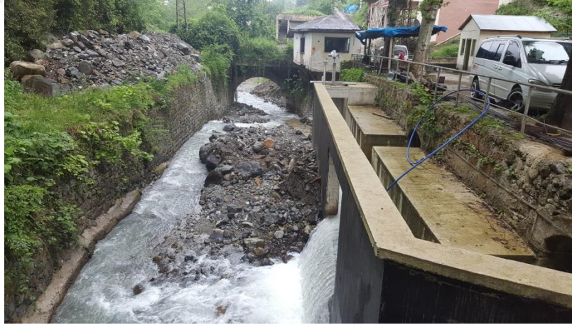
Şekil 57. Visera Santrali'nin kuyruk suyu çıkışına yapılan su alma yapısı
