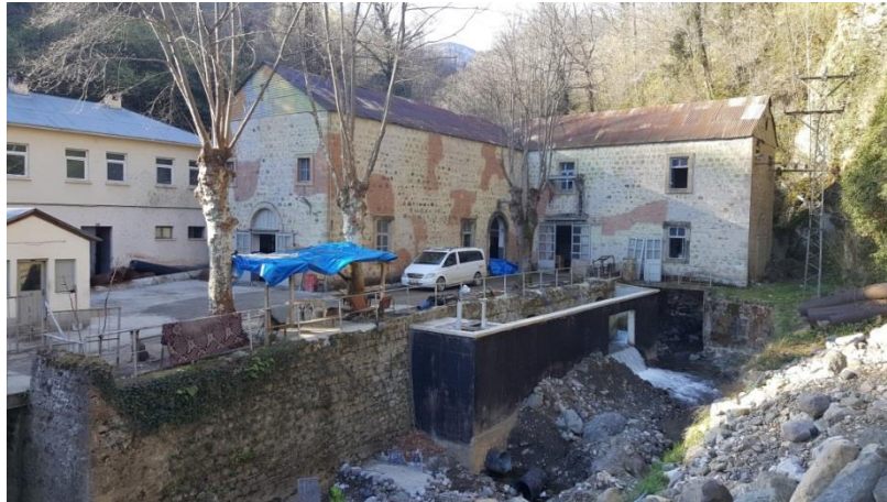
Şekil 45. Visera Santrali'nin kuzeybatı cephesi
