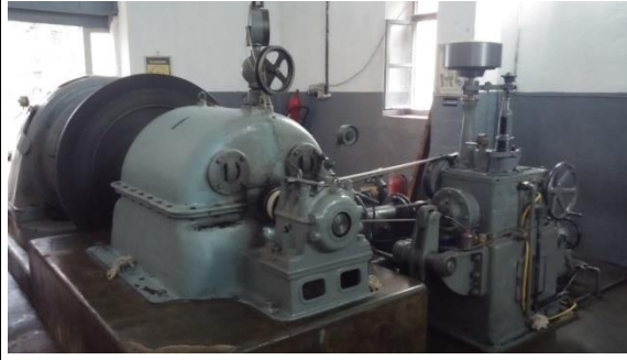
Visera Santrali'ndeki Pelton türbini
