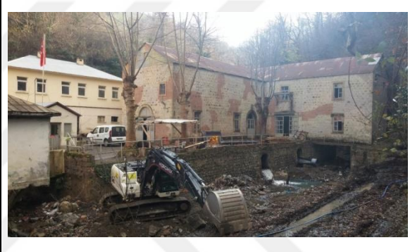
Işıklar Suyu projesi çalışmaları yapılırken
