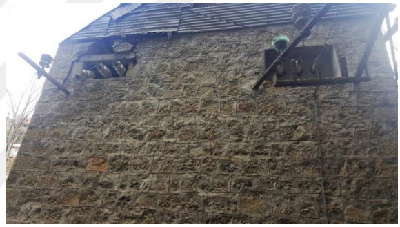
Visera Santrali'nin kuzeybatı cephesi ön görünüş
