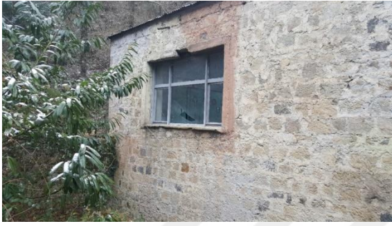
Visera Santrali'nin güneydoğu cephesi
