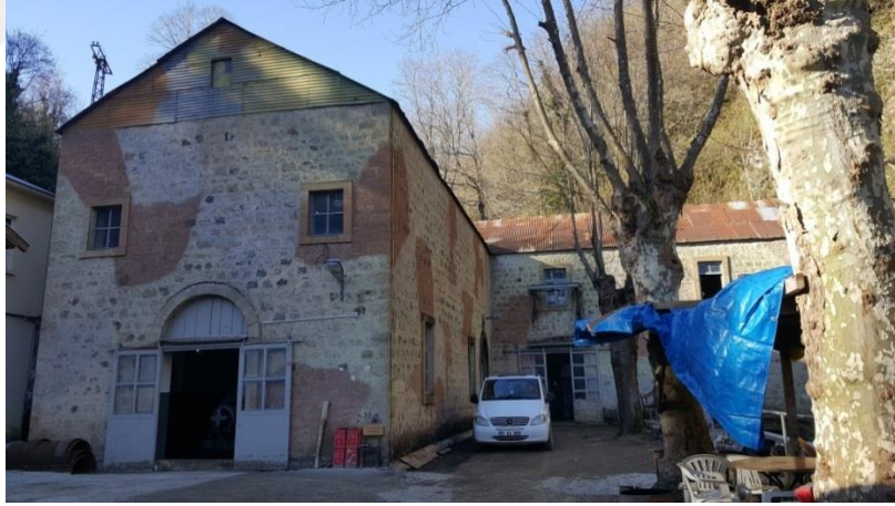
Şekil 43. Visera Santrali'nin kuzeydoğu cephesi
