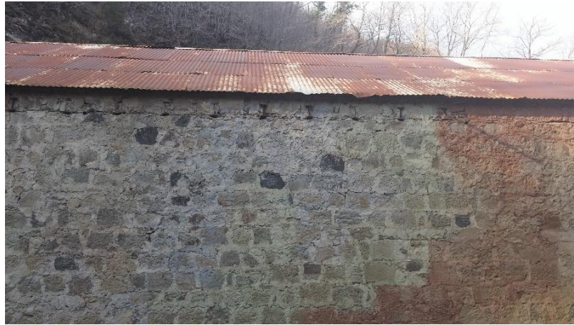
Şekil 54. Visera Santrali'nin çatısı
