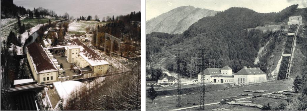
Şekil 71. Walchensee Santrali (URL-13, 2017)
