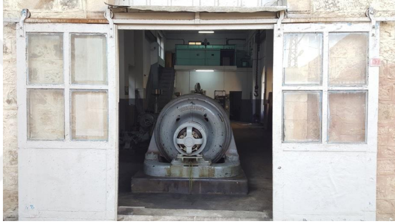
Şekil 30. Visera Santrali'nin türbin alanı giriş kapısı
