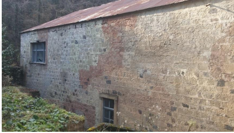
Şekil 49. Visera Santrali'nin güneydoğu cephesi
