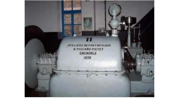
Visera Santrali'ndeki Pelton türbini
