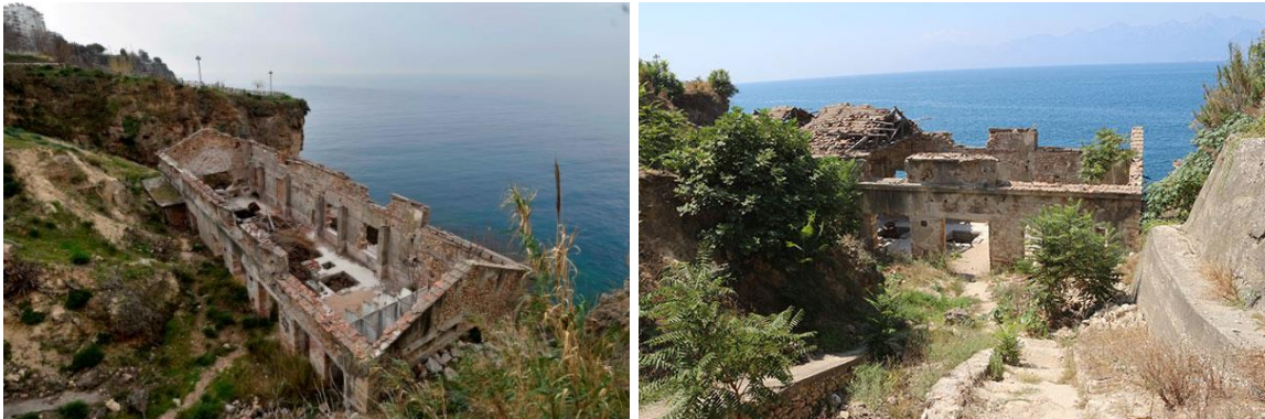
Şekil 66. Antalya Hidroelektrik Santrali (URL-10, 2017)
