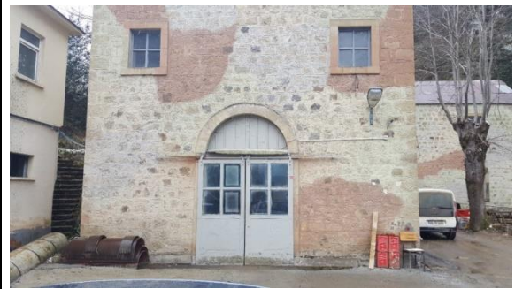
Kuzeydoğu cephesinden detaylar
