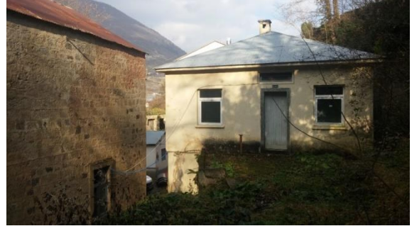
Visera Santrali'nin güneydoğu cephesinden detaylar
