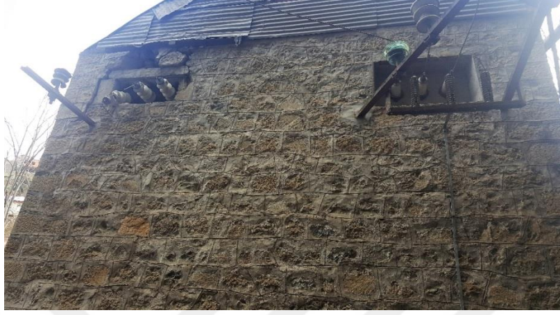
Şekil 52. Visera Santrali'nin kuzeybatı duvarı
