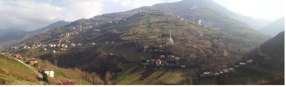
Şekil 15. Işıklar Mahallesi'nin Gökçeler Mahallesi'nden görünüşü
