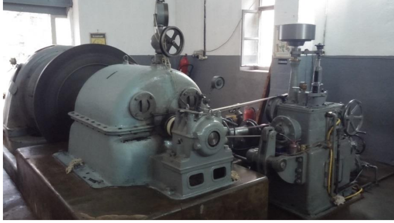
Şekil 11. Visera HES'teki Pelton türbini
