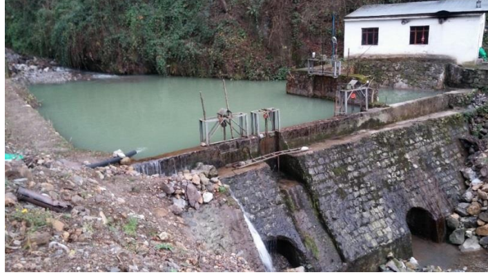
Şekil 9. Visera HES'in regülatörü
