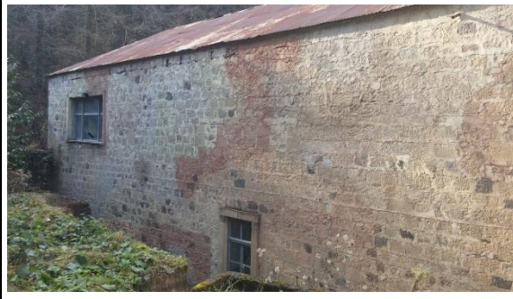
Visera Santrali'nin güneydoğu cephesi
