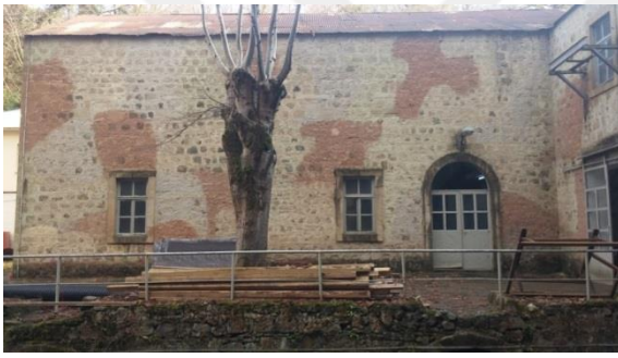
Visera Santrali'nin kuzeybatı cephesi arka görünüş
