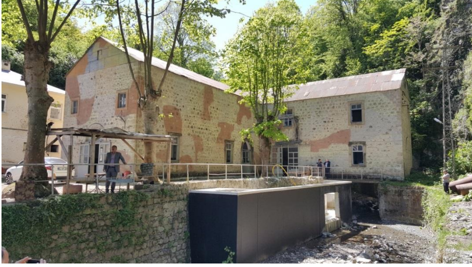
Şekil 13. Visera HES'in kuyruk suyu çıkışı 2016 yılı
