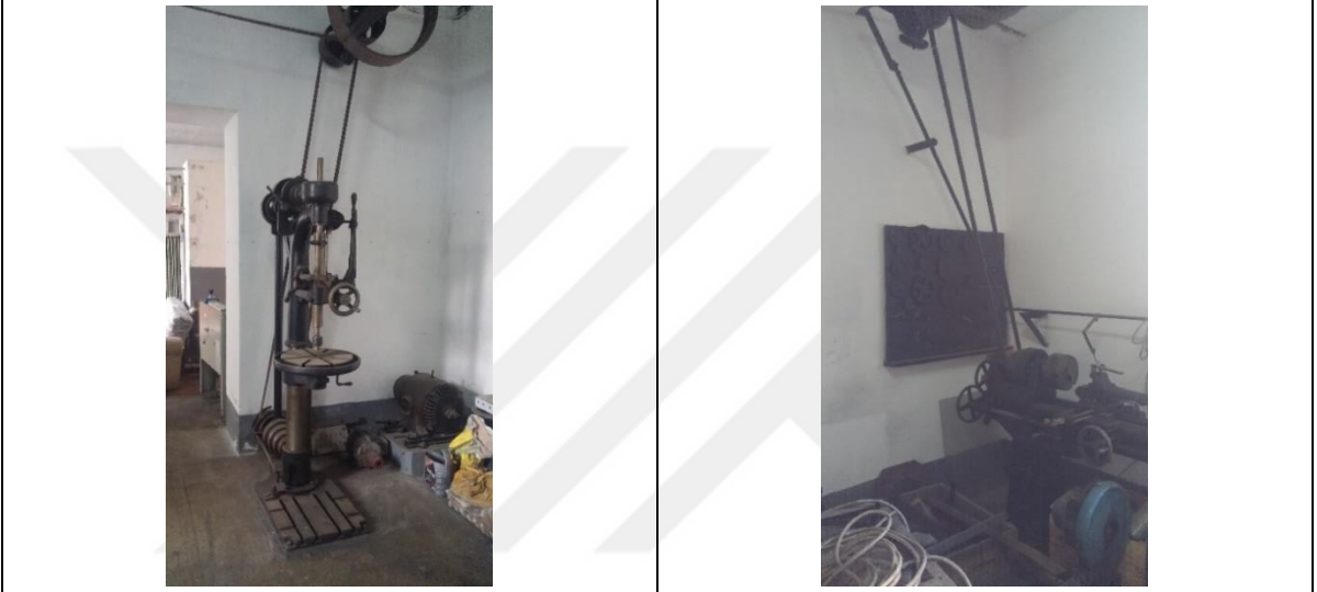
Visera Santrali'nin atölyesindeki ekipmanlar
