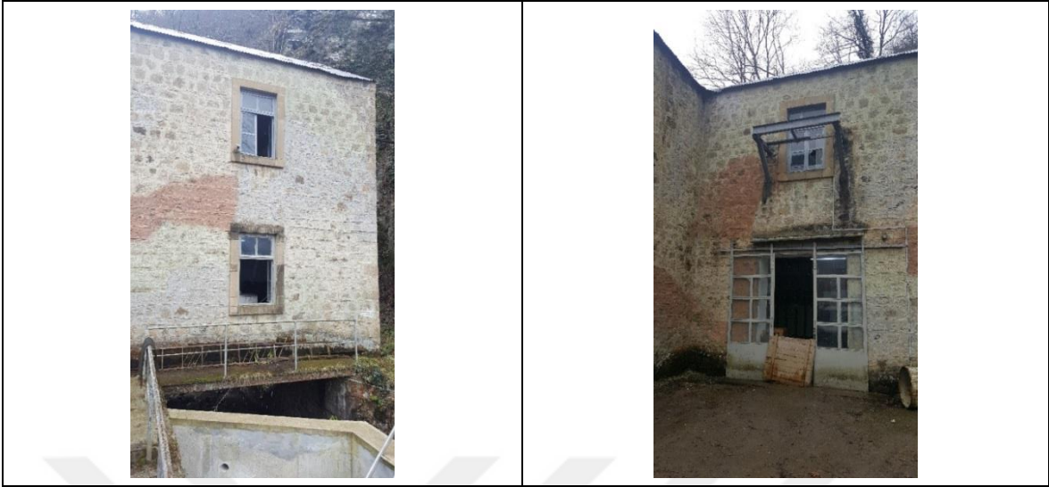
Visera Santrali'nin kuzeydoğu cephesinden detaylar
