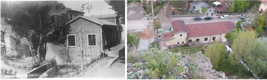
Şekil 67. Bünyan Hidroelektrik Santrali (Hovardaoğlu ve Aksoy, 2017)
