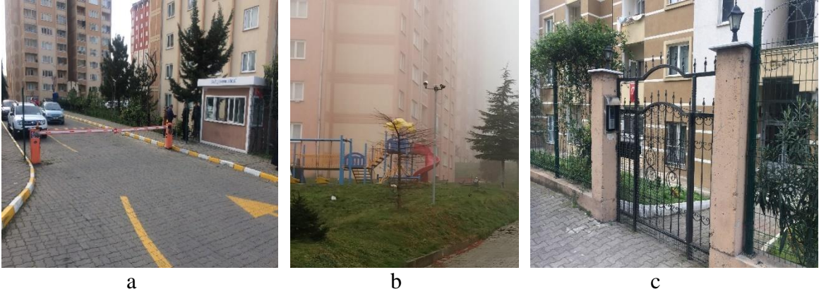
Şekil 43. İncelenen toplu konut alanlarındaki çeşitli güvenlik önlemleri a: Bahçekent Sitesi; b: Yıldızlı TOKİ; c: Vadikent Sitesi
