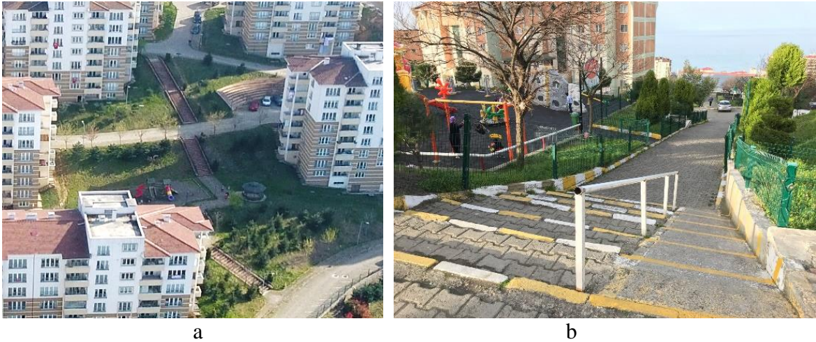
Şekil 30. Toplu konut alanlarındaki merdivenli yaya yolları a: Vadikent Sitesi; b: Sarıtaş TOKİ
