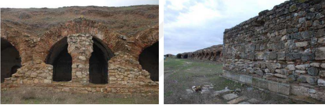
Şekil 23. Edirne Hıdırlık Tabyası taş ve tuğla örgüleri (Yeler, 2013)
