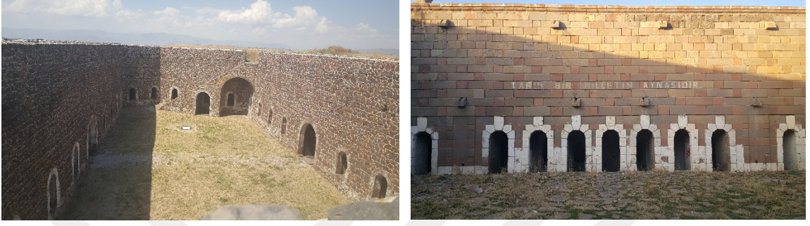
Şekil 52. Aziziye 3 Tabyası'nın moloz taş duvarları (solda), Tafta Tabyası'nın kesme taş duvarları (sağda)
