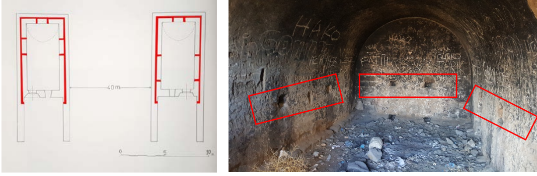
Şekil 73. Küçük Kiremitlik Tabyası havalandırma boşlukları planı (Çam, 1993) ve mekanın iç görünümü
