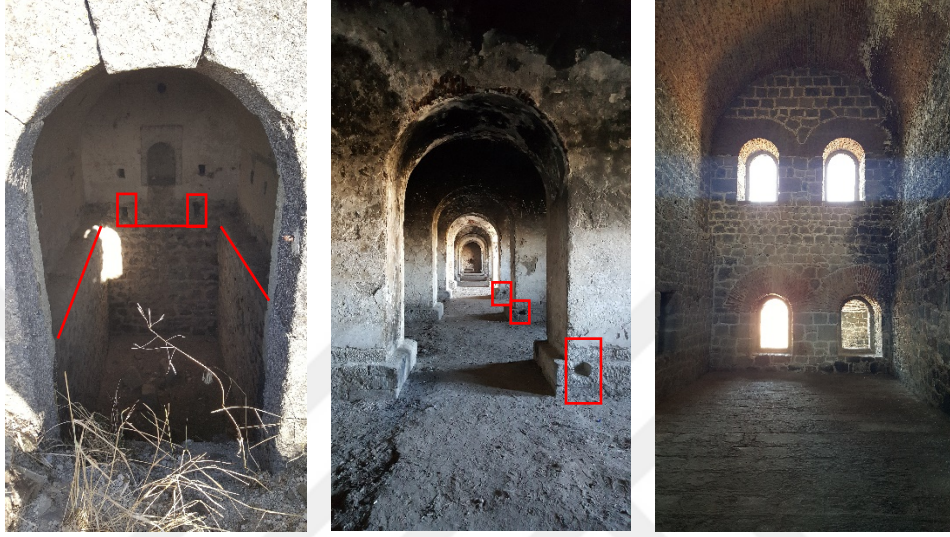
Şekil 54. Sivişli Tabyası'nın topçu odasında, Büyük Kiremitlik Tabyası'nın kışlasındaki döşeme ve kiriş izleri ile Aziziye I Tabyası'nın kışlasındaki taş blok döşeme
