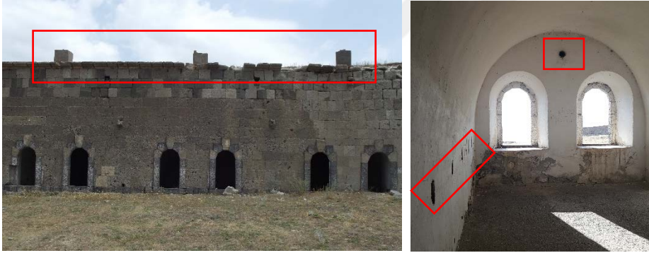
Şekil 74. Sivişli Tabyası bacaları, soba delikleri ve havalandırma boşlukları
