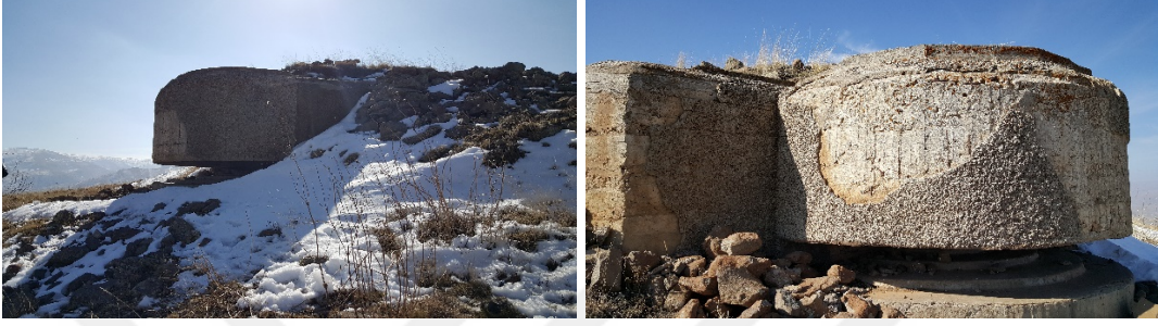
Şekil 49. Ağzıaçık Tabya yakınlarında bulunan bunker
