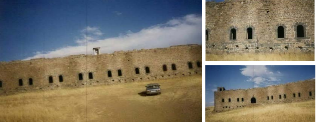
Şekil 98. Mecidiye Tabyası'nın onarım öncesi fotoğrafları (KTVKK, 1996)
