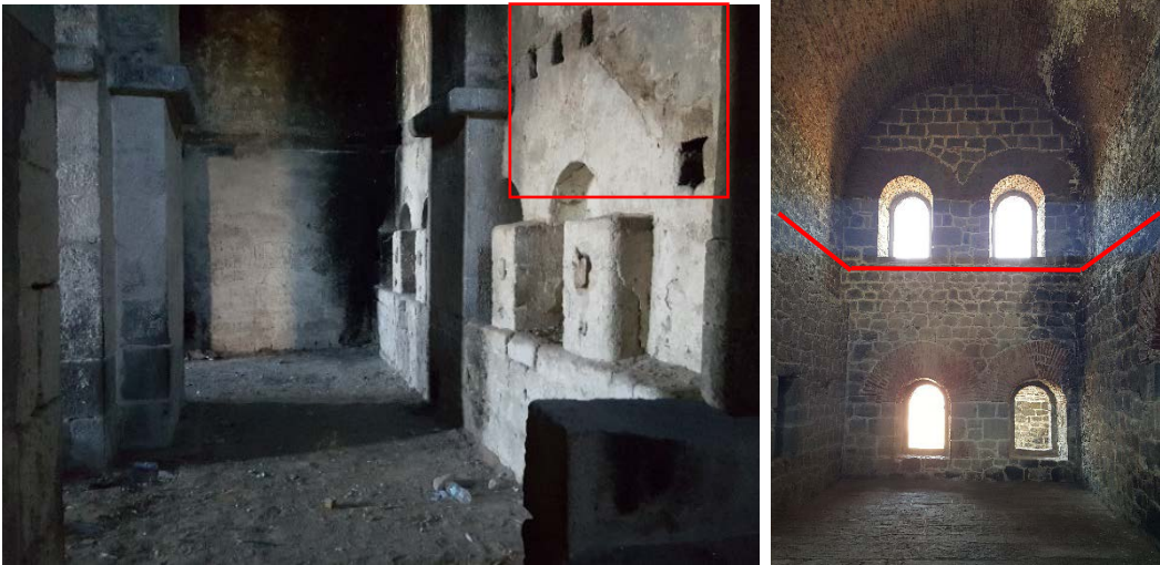
Şekil 59. Büyük Kiremitlik Tabyası döşeme kiriş izleri ve Aziziye Tabyası döşeme izi
