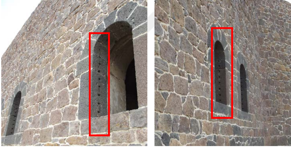
Şekil 110. Mecidiye Tabyası'nın pencerelerinde bulunan korkuluk izleri
