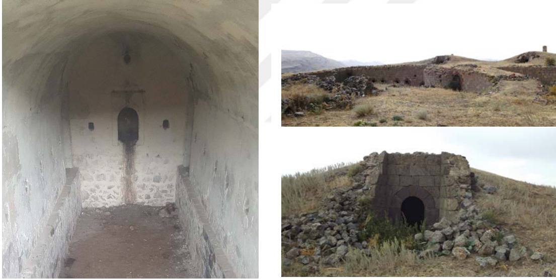
Şekil 63. Uzunahmet Tabyası topçu odaları, rampaları ve giriş cephesi
