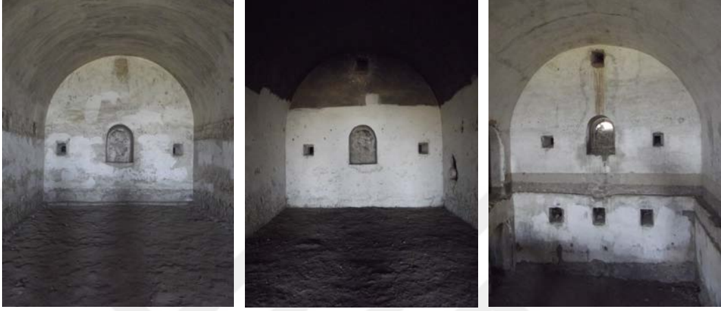
Şekil 107. Mecidiye Tabyası koğuşlarının arka cephesinde bulunan sonradan kapatılmış pencere boşlukları
