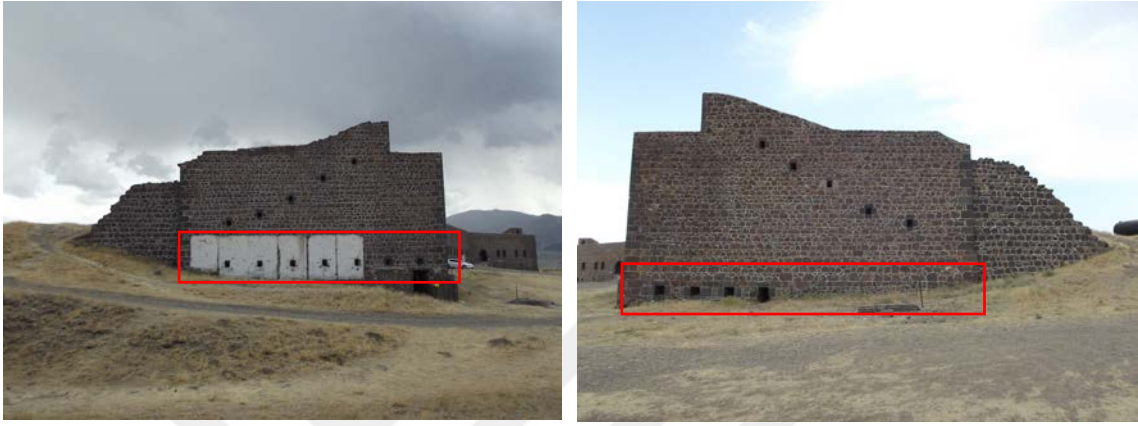
Şekil 105. Yapının sol cephesindeki mekan izleri ve sağ cephesindeki mazgal pencereler
