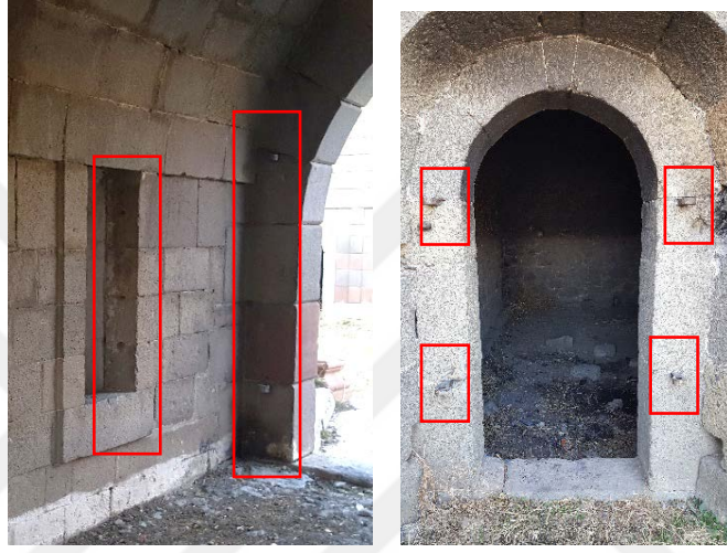
Şekil 60. Tafta ve Büyük Kiremitlik Tabyalarının kapı- pencere kanat izleri
