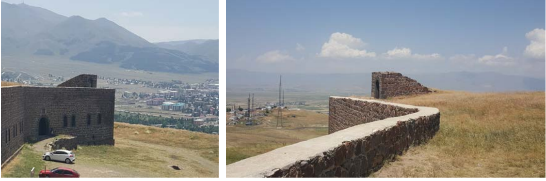
Şekil 81. Mecidiye Tabyası'nın iç mekanından üstüne erişim sağlayan merdivenlerin cepheden algılanışı
