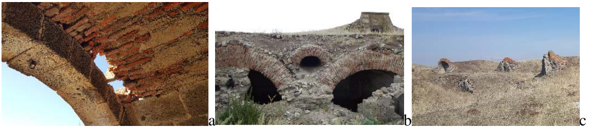
Şekil 53. Ağzıaçık tabya nizamiye kapısı kemeri (a), Uzunahmet Tabyası kışla birimi (b), Toparlık Tabyası (c) topçu odalarında kullanılan taş ve tuğla yapı malzemeleri
