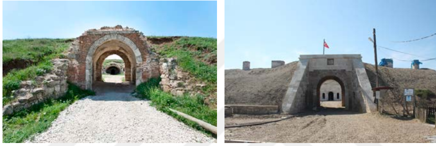
Şekil 41. Hıdırlık Tabyası nizamiye binasının restorasyon öncesi ve restorasyon aşamasındaki görüntüsü (URL-34, 2017)
