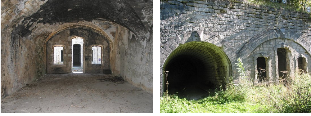
Şekil 24. Fransa'da Bulunan “Fort de Bois Bourrus” Tabyası'nın taş duvar ve üst örtüsü (URL-14, 2017)
