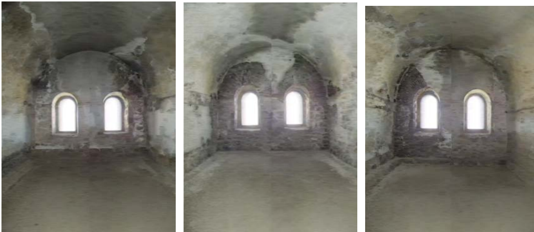
Şekil 100. Mecidiye Tabyası'nın batı cephesinde meydana gelen sıva bozulmaları ve lekeler
